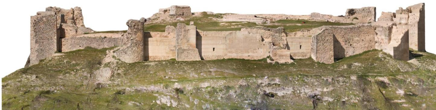
Ortofotografía del alzado sur con resolución de 1cm. Realizada por J.A.Benavides 2017
