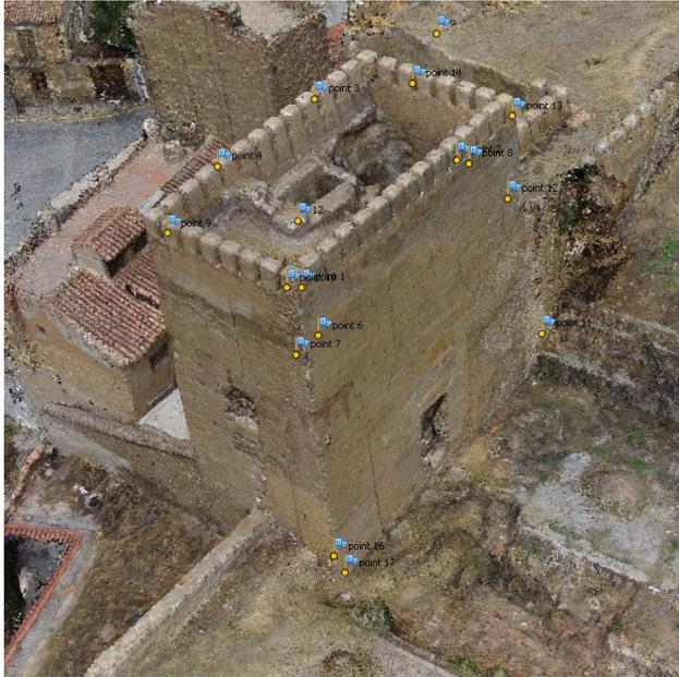
Situación de los puntos de apoyo sobre la estructura de la torre puerta.
