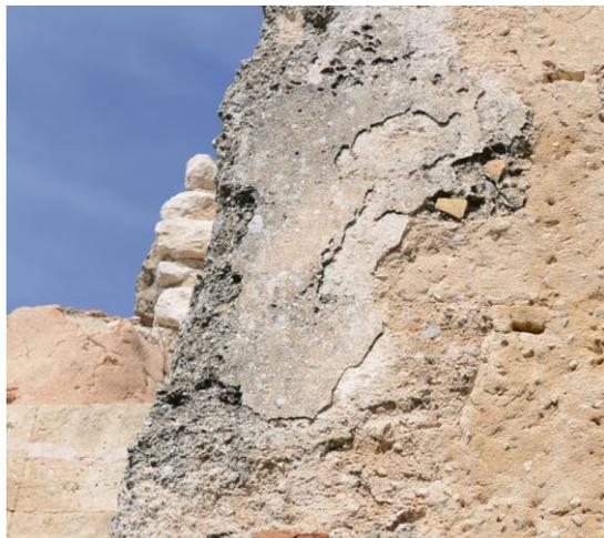
Imagen del enfoscado y enlucido de cal en la cara exterior del tapial de tierra en la torre 8
