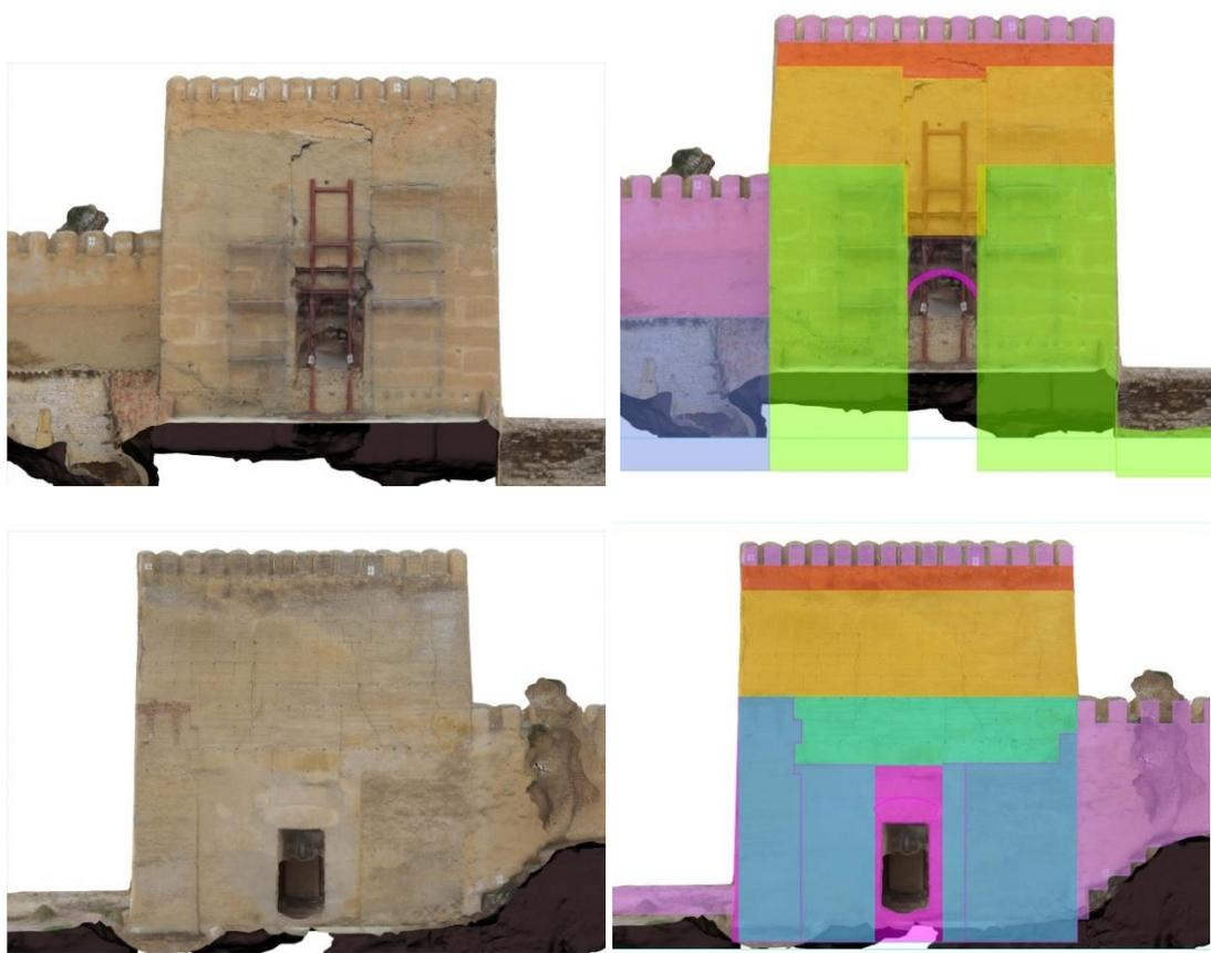
Digitalización de las unidades estratigráficas muráreas correspondientes a la estructura de la torre puerta de la alcazaba de Guadix. Alzado sur (arriba), Alzado norte (abajo). (J.A. Benavides).
