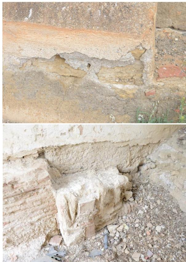
Sillar de piedra caliza reforzando la esquina del CE 12 (izquierda). Restos muy deteriorados de las jambas de la torre puerta mediante sillares colocados a soga y tizón.
