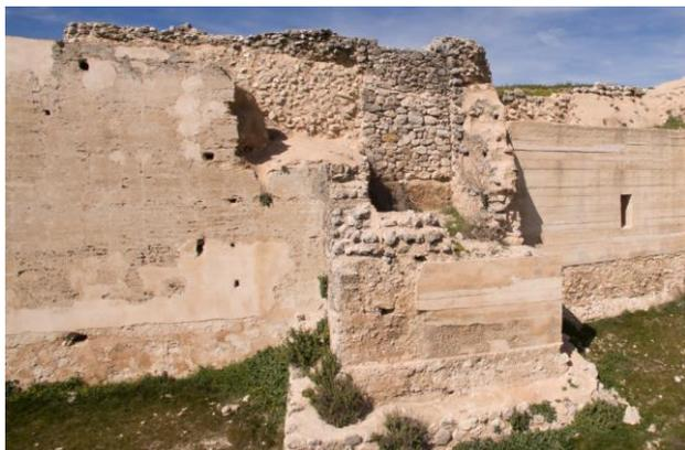
Estructura de la torre 9 donde se aprecian la secuencia de fases constructiva y la reparación con mampostería en determinadas zonas.
