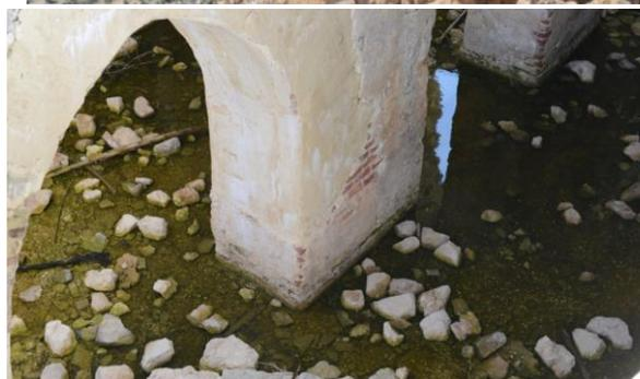
La utilización del ladrillo se limita a pequeñas obras de reparación y en las pilastras interiores del aljibe 2.
