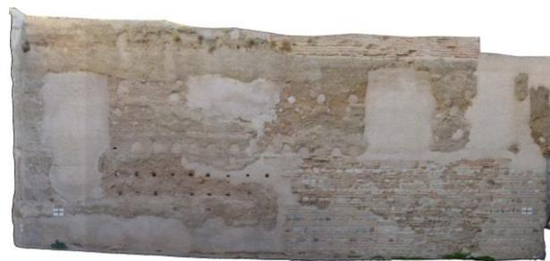
Ortofotografía del Alzado norte de Puerta de Elvira. Permite el dibujo del análisis estratigráfico directamente en campo. Elaborada por el J.A. Benavides
