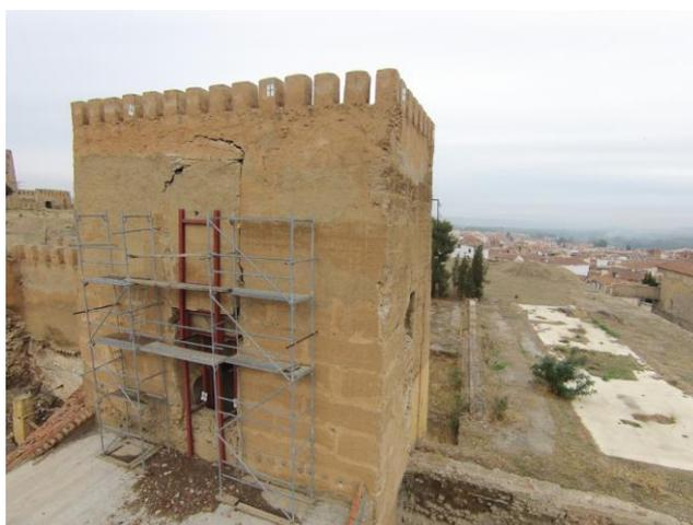
Vistas horizontales de los paramentos verticales. La mejor distancia de captura nos proporciona imágenes de gran resolución. Debido a la baja altura del vuelo y la presencia de edificios próximos se hace necesario el control manual para evitar choques con objetos.
