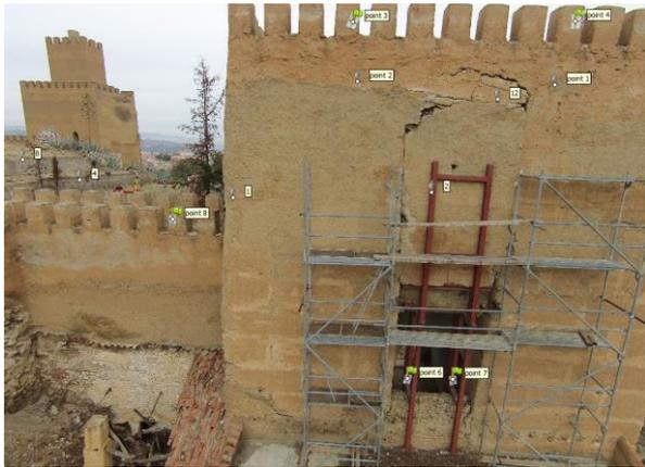
Puntos de apoyo topográfico. En verde puntos de apoyo visible en esta imagen. En gris, puntos de apoyo del modelo no utilizados para esta imagen.
