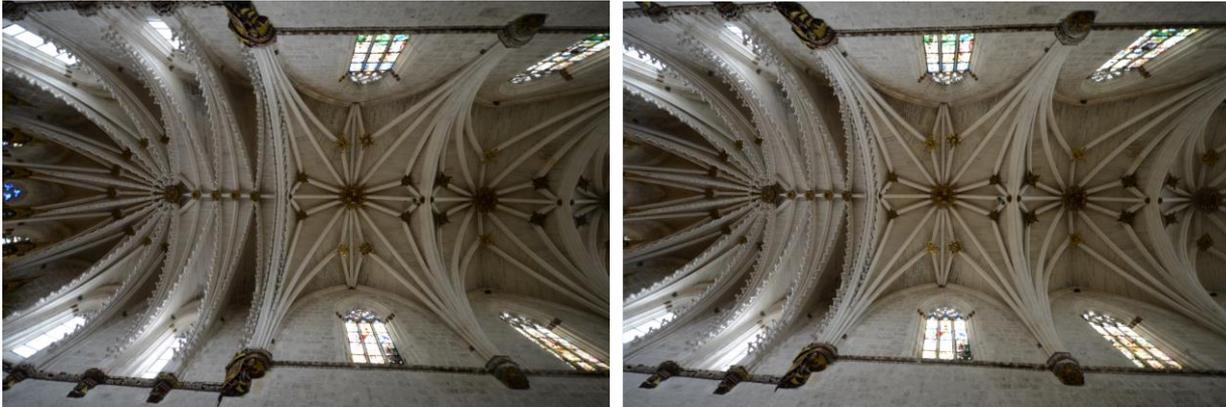
Imagen izquierda y derecha de un par estereoscópico. La cámara se desplaza longitudinalmente para capturar un objeto desde dos puntos de vista diferentes. Capilla de la Cartuja de Miraflores (Burgos)
