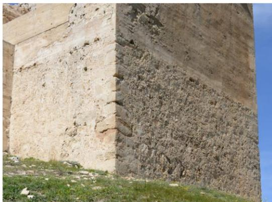
Imagen de tapial tipo 2 "calicastro", apoyado sobre mampostería irregular para nivelar los cajones y aislar el tapial de la humedad del terreno. Sillares conformando las esquinas en zonas bajas.(J.A.Benavides)
