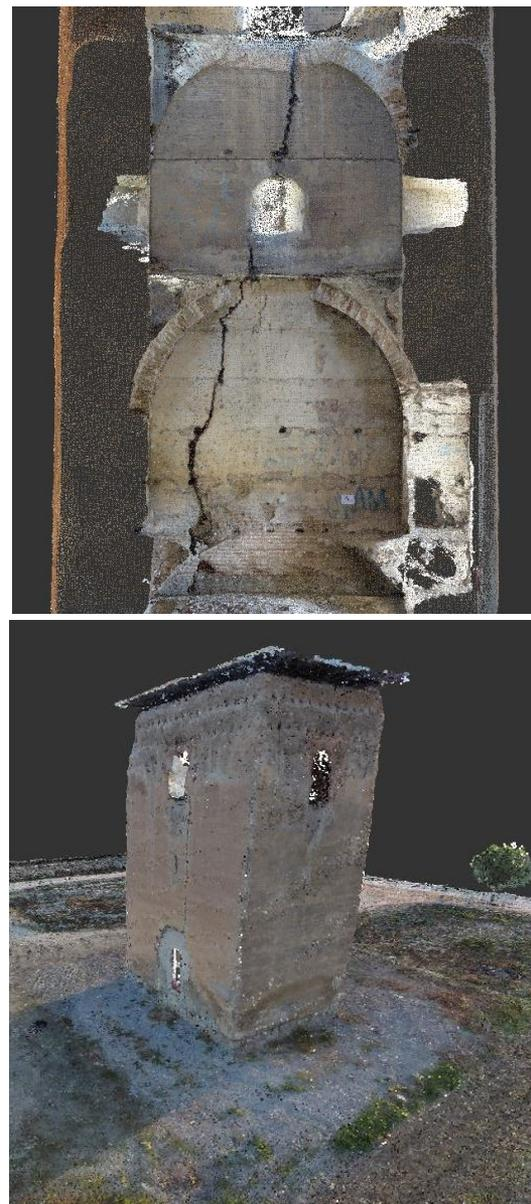
Nube de puntos interior y exterior de la torre de Romilla capturadas con fotogrametría multimagen. (J.A.Benavides)
