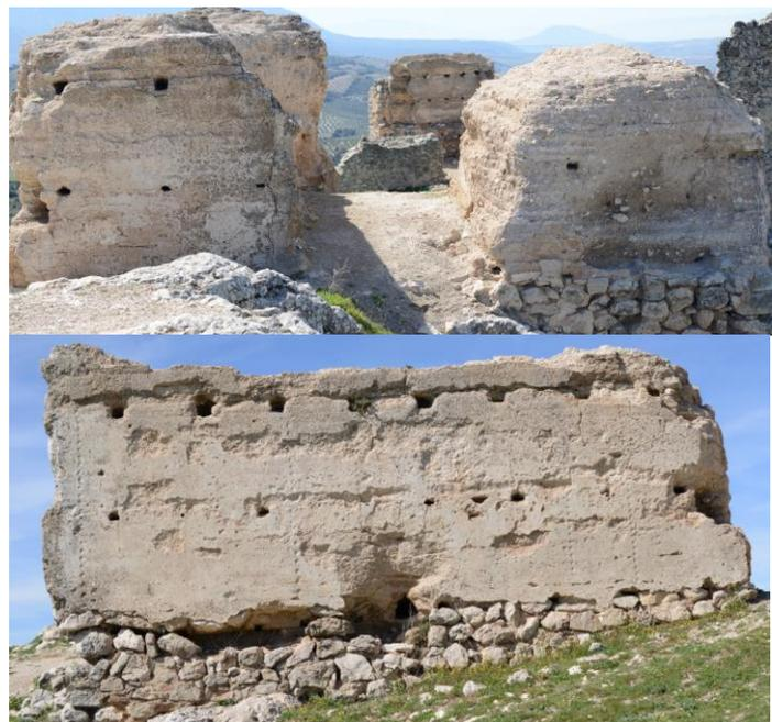
Imagen de la Torre 4 desde el interior del recinto, donde se aprecian las diferentes tongadas de tierra y cal, propia de la tipología "tapial real". Se trata de una torre maciza que apoyada sobre una base de mampostería de gran tamaño para salvar los desniveles del terreno y aislarla de la humedad del terreno.
