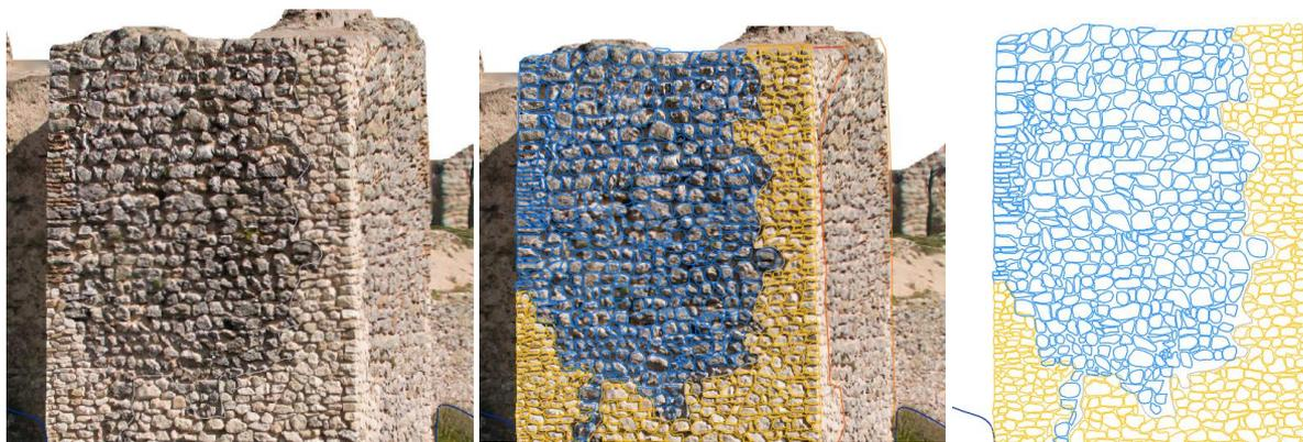
Digitalización de fases constructivas y detallada “pieza a pieza” del lateral oeste de la torre 6 del castillo de Piñar.(J.A.Benavides)
