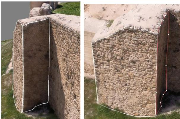
Digitalización tridimensional alámbrica de una misma torre, desde dos puntos de vista distintos. El punto de vista de la primera imagen hace que la digitalización parezca correcta. Con el giro del modelo se observa la falta de precisión. (J.A.Benavides)
