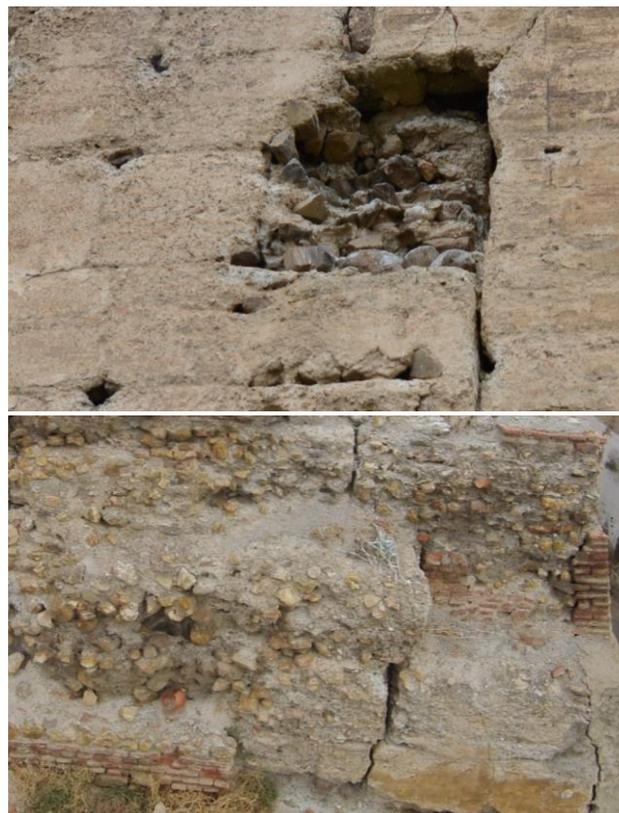
Detalle de tapial de cal y canto en la torre puerta S-E. Detalle de la gran cantidad de mampuestos en el núcleo de las estructuras. Muralla sur junto a torre puerta.
