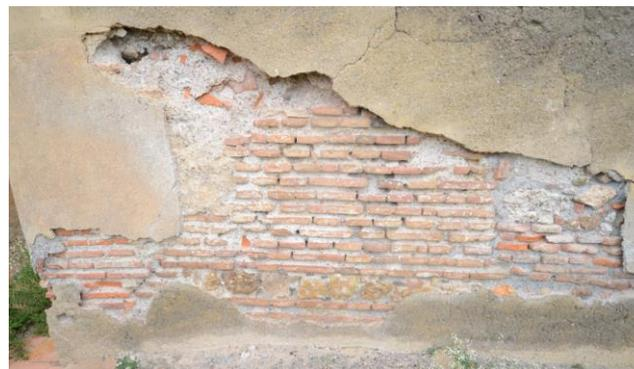
Hilada de mampostería regularizando el apoyo de la fábrica irregular de ladrillo en una obra de restauración o reparación.
