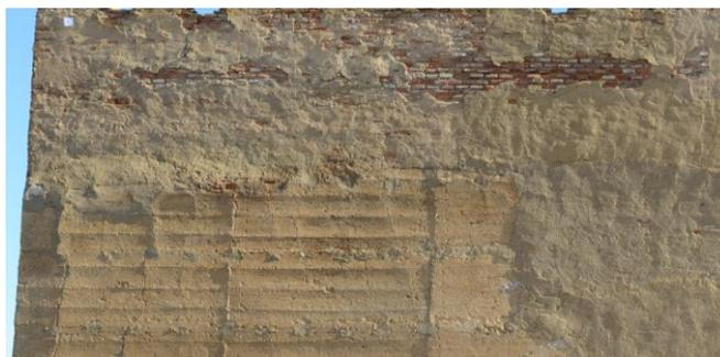
Detalle de dos tipos de encofrado de un mismo tapial. (J.A.Benavides)
