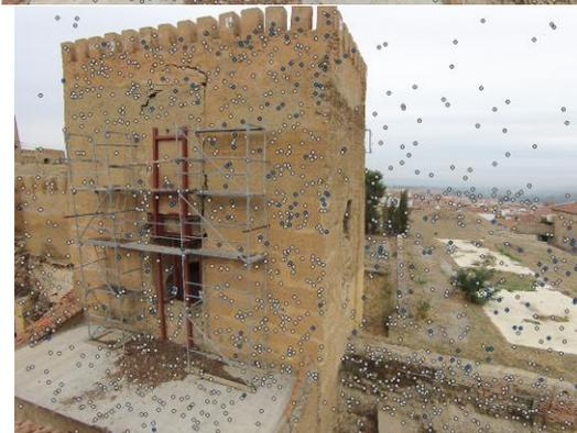
Puntos de enlace radiométrico en base al algoritmo SHIF
