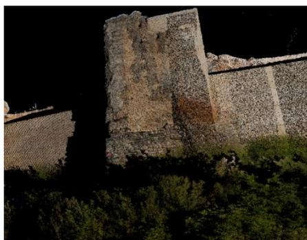
Imagen de la torre 8 captura con cámara Canon Ds1-Mark II. Los puntos de referencia que aparecen se alinearon con sus homólogos en la nube para dar textura.(J.A.Benavides).
