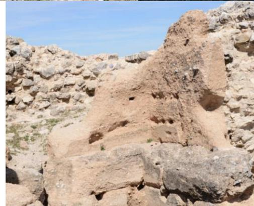
Cara interior del tapial de tierra en la torre 7: Se aprecia claramente la tongada de mortero de cal en la coronación de cada cajón, así como los mampuestos que cubren los mechinales. (derecha) Interior de la torre 5: muestra del color rojizo del tapial
