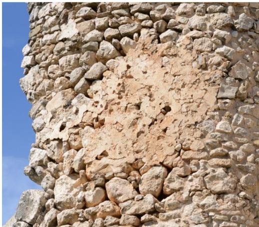
Torre 7: imagen de la construcción por hiladas de diferente tamaño. Imagen del resto de enfoscado exterior.
