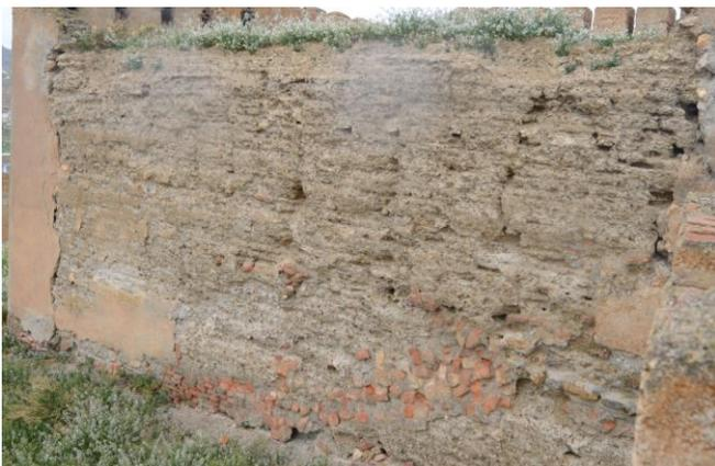
El deterioro del tapial sufrido en aquellas zonas con humedad (muros de contención), ha provocado un importante desprendimiento en la cara exterior. .(J.A.Benavides)
