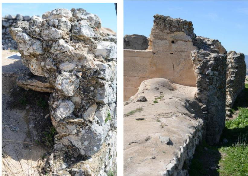
Mampostería irregular adosada a la cara interna del muro de tapial T1. Su mayor resistencia hace que sobrevivan al propio tapial de tierra (izquierda). En la imagen derecha, junto a la torre 8, se observan esta tipología de muro con mayor altura y espesor, que junto con unos mechinales, delata que en algunos casos formaban parte de la estructura de viviendas. (J.A.Benavides)
