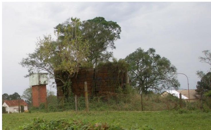
Fig. 4. Candelaria (Argentina). De la capital de las reducciones no queda más que una serie de muros situados dentro de una institución penitenciaria.
