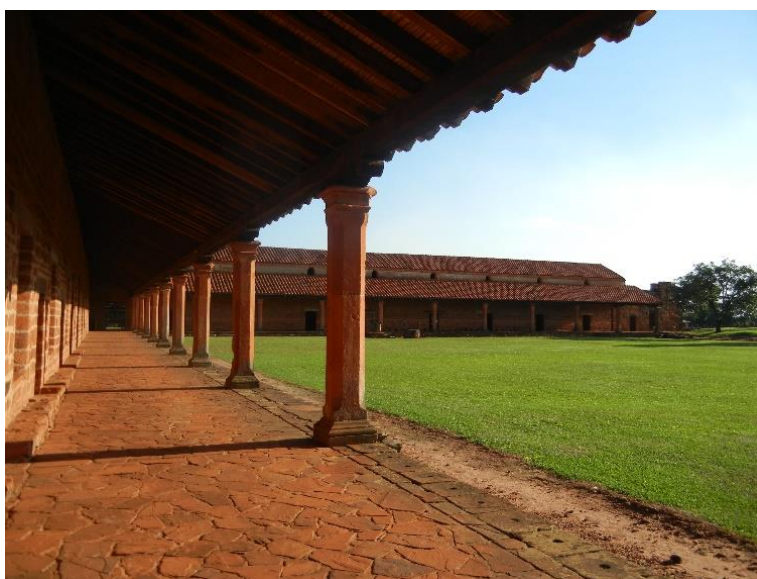
Fig. 20. Vista del primer claustro desde la galería de la iglesia improvisada. Al fondo se observa la zona de residencia de los jesuitas.
