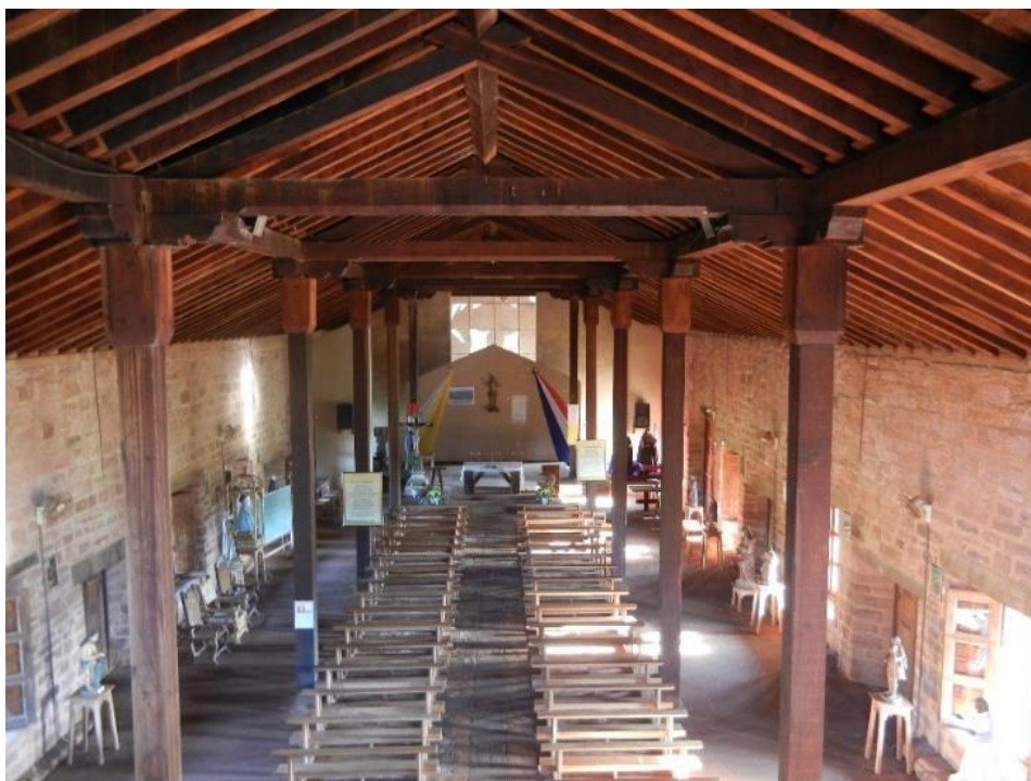
Fig. 17. Interior de la actual iglesia de San Cosme. Su longitud se redujo tras el incendio reservándose un tramo para salón parroquial.
