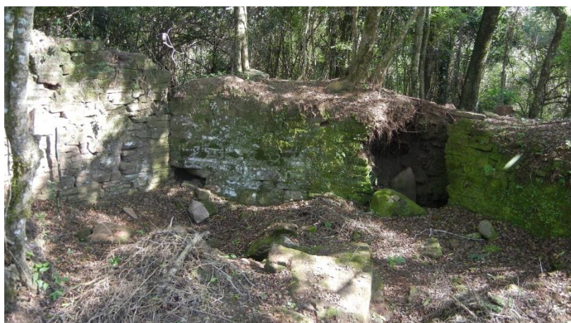
Fig. 57. Estructura hexagonal de la capilla del monte Calvario en Loreto (Argentina). Situación en el año 2013.
