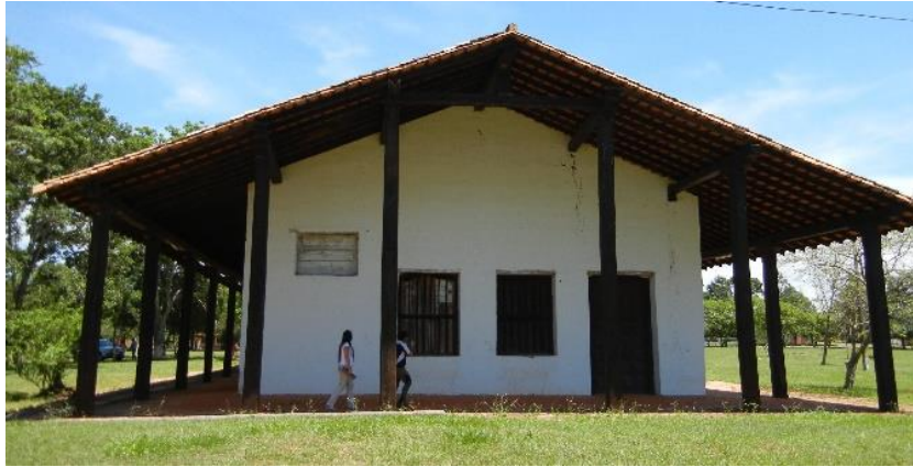
Fig. 8. Parte trasera de la construcción.
