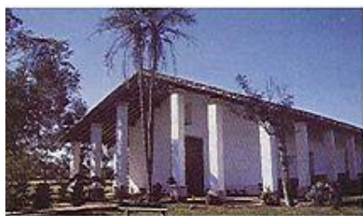
Fig. 6. En esta antigua fotografía se aprecia cómo sus horcones fueron recubiertos simulando gruesos pilares. Fuente: http://www.portaleducativo.gov.py/Espanol/Thumbails/375px-Iglesia_San_Joaquin.jpg [consulta: 21.01.2017]
