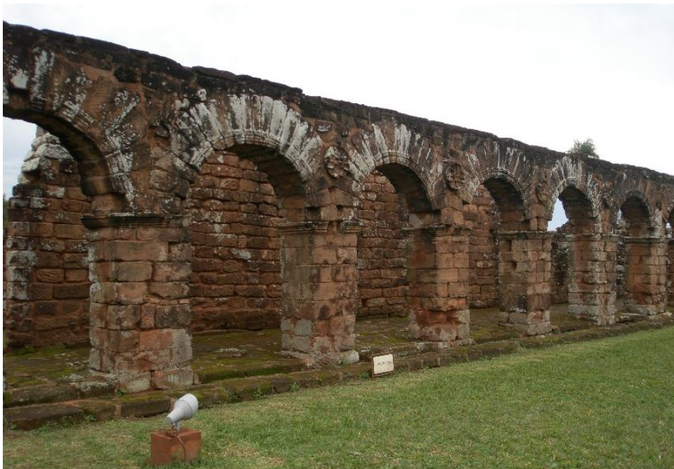
Fig. 54. Arquerías de las viviendas de Trinidad (Paraguay).
