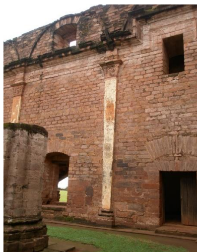
Fig. 26. Muro lateral de la iglesia de Jesús.
