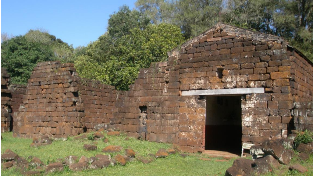
Fig. 9. Capilla instalada en una de las estancias de la residencia.
