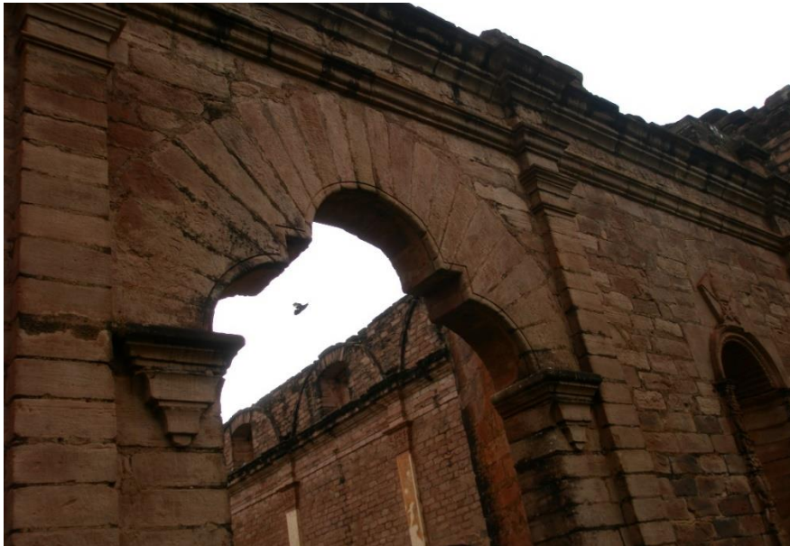
Fig. 30. Detalle de uno de los arcos trilobulados. Se puede apreciar aún la numeración de las dovelas.
