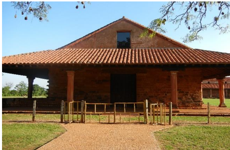
Fig. 13. San Cosme (Paraguay), fachada del templo en uso actualmente. Sector ubicado entre ambos patios donde se instalaría la iglesia provisional.
