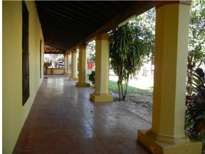
Fig. 17. Pilares que enmascaran la estructura de madera en la galería lateral del templo.
