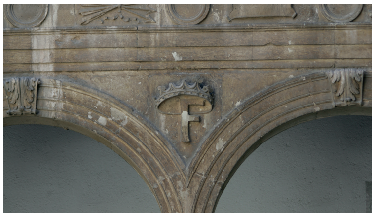
fig.6.8 Detall del patio de los Mármoles. Hospital Real de Granada.
