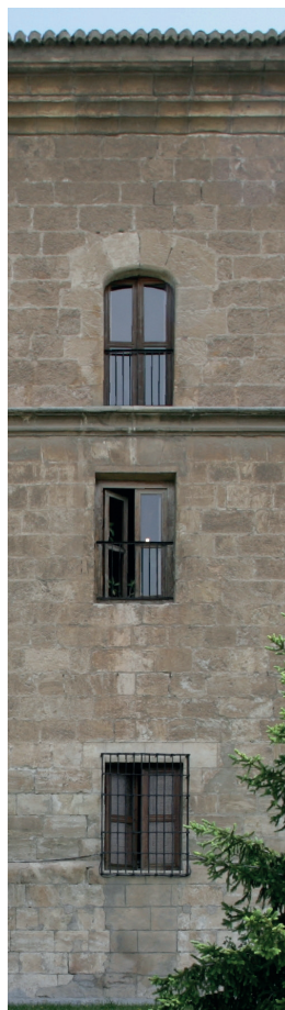
fig.6.10 Externo del Hospital Real de Granda.
