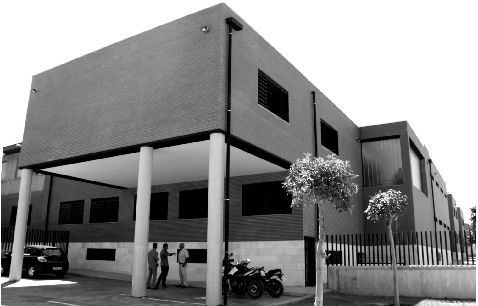
Imagen 4. Centro docente de bachillerato, Roquetas de Mar, Almería. Autor: MZJ
