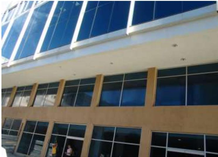
*Figura 104. Edificio hermético con fachada de cristales estáticos que obliga a climatización artificial y al uso de deshumidificadores.*
