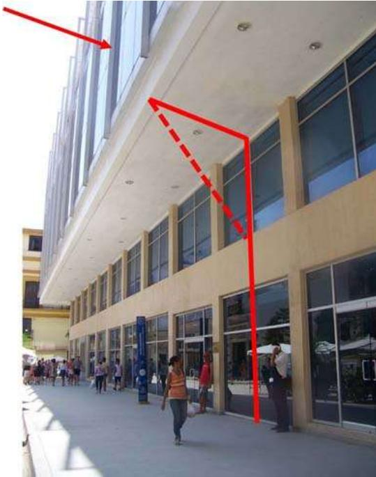
Figura 106. Incidencia directa de la luz solar sobre la fachada a partir del segundo piso y sombra que proyecta el saliente sobre la fachada del entresuelo.
