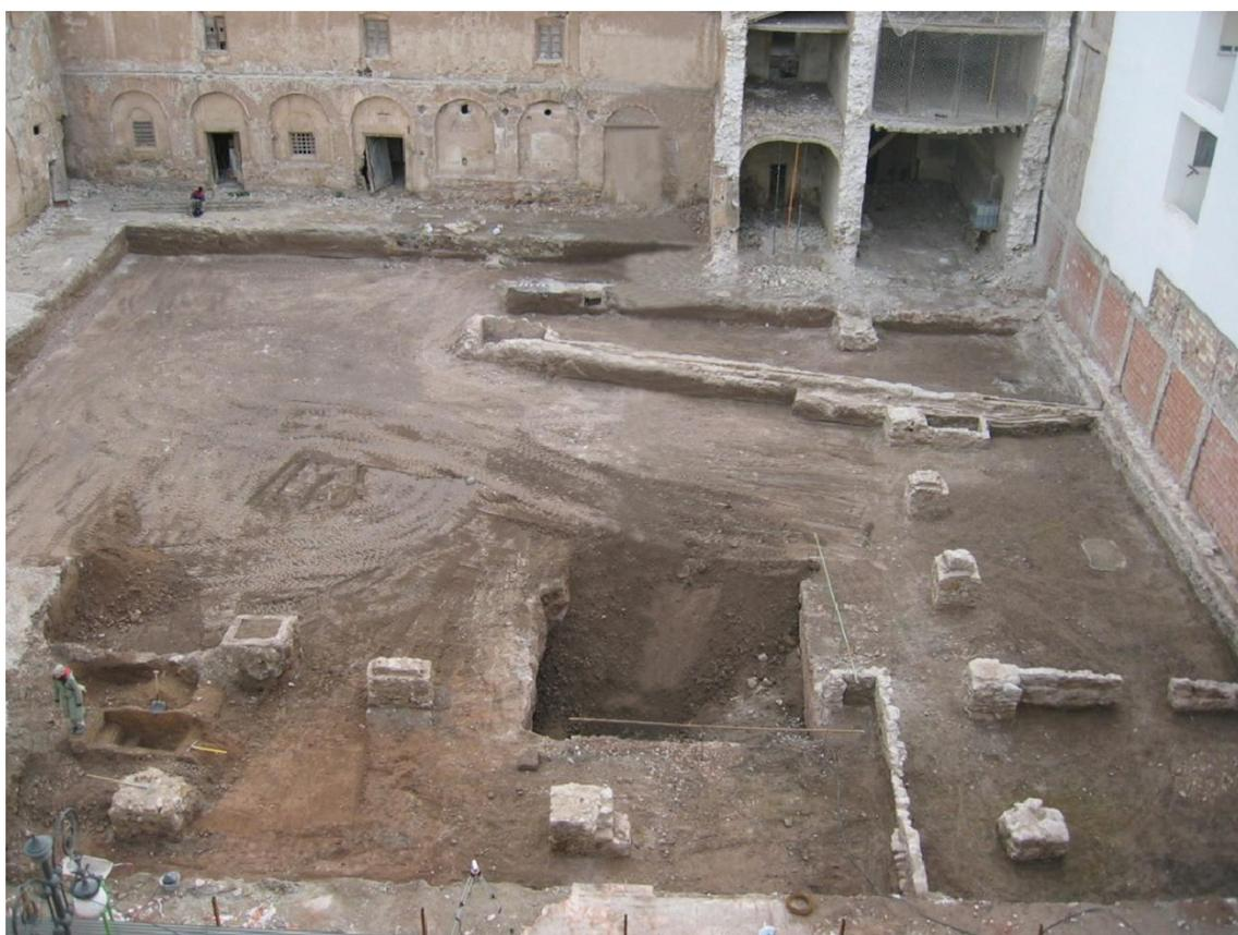
Lámina 24. Panorámica de estructuras conventuales de cimentación exhumadas (zapatas y correas de cimentación), infraestructuras de recogida y almacenamiento de agua, y canalizaciones para riego
