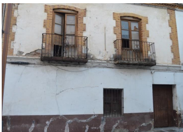
Fotografía n° 23. M.A.B.B. (Escuela de peseta. C/ Pintor Velázquez. Peligros 2015) Imagen actual de la fachada de la “escuela de peseta”
