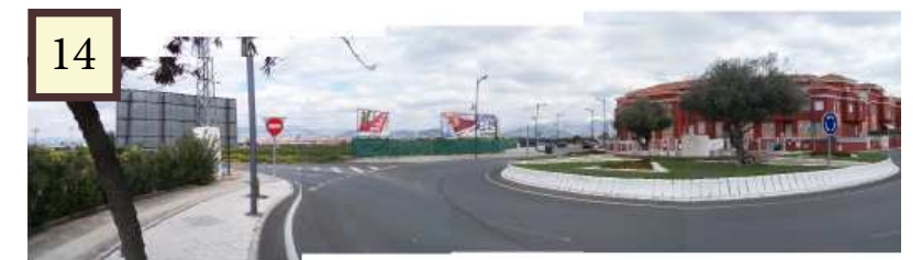
Salida de la carretera GR-3304 hacia Granada norte. Cruce sin paso de peatones. Corta y separa el itinerario del borde.
