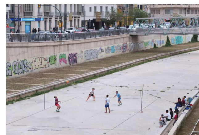
Uso intermedio del encauzamiento del río Guadalmedina en Malaga
