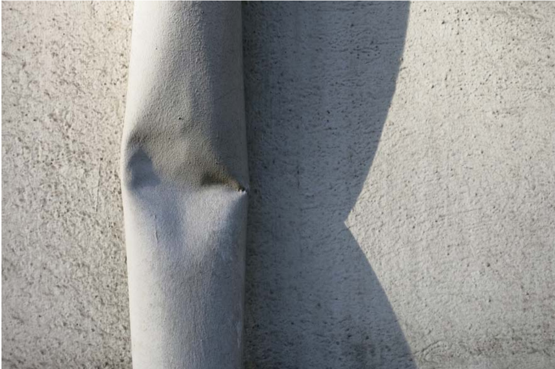
Fotografía independiente. Genet, R.(2015). Tubería . Fotografía digital.
