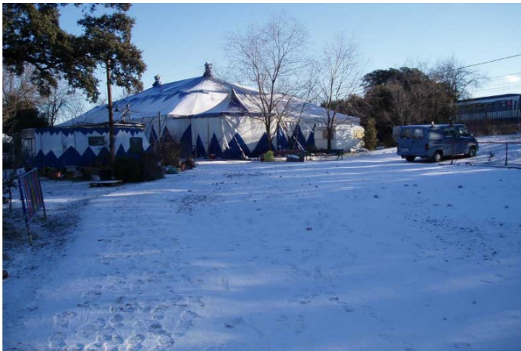
Figura 711. Imagen de la nueva carpa adquirida e instalada en el recinto de la casa de campo. Obtenido de : http://carampa.com/
