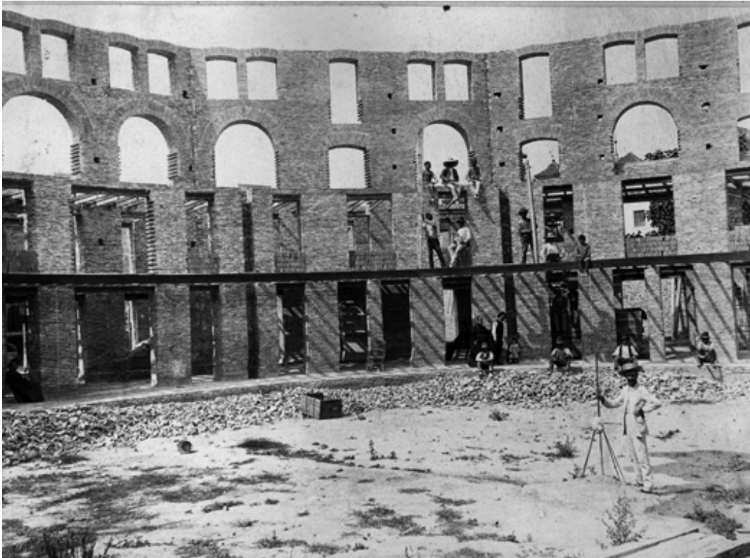
Figura 116. Construcción del Teatro Circo de Murcia, proyectado y construido por Justo Millán. Obtenido de: http://www.teatrocircomurcia.es/historia.php
