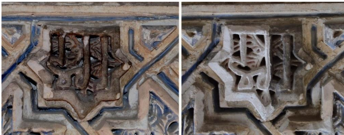
Figura 139. Imagen del embozado de la decoración localizada en el friso superior en un sino de ocho mutilado, y detalle de la delicadeza del relieve original en la capa de limpieza mecánica realizada.
