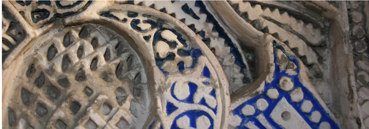
Figura 95. Distintas tonalidades de azul, correspondientes a diferentes intervenciones que se observan en el intradós de la puerta de acceso al Salón del Techo de Carlos V.
