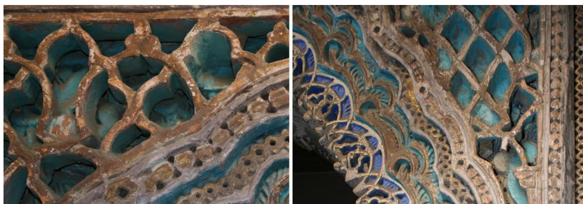
Figura 41. Estado actual de las albanegas y decoración que se observa debajo.
