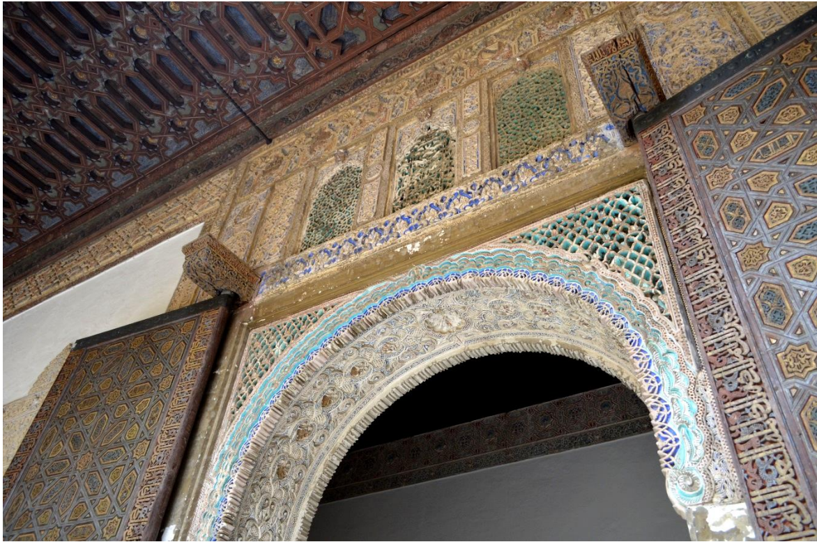
Figura 29. Imagen general de la puerta de acceso al Salón del Techo de Carlos V.
