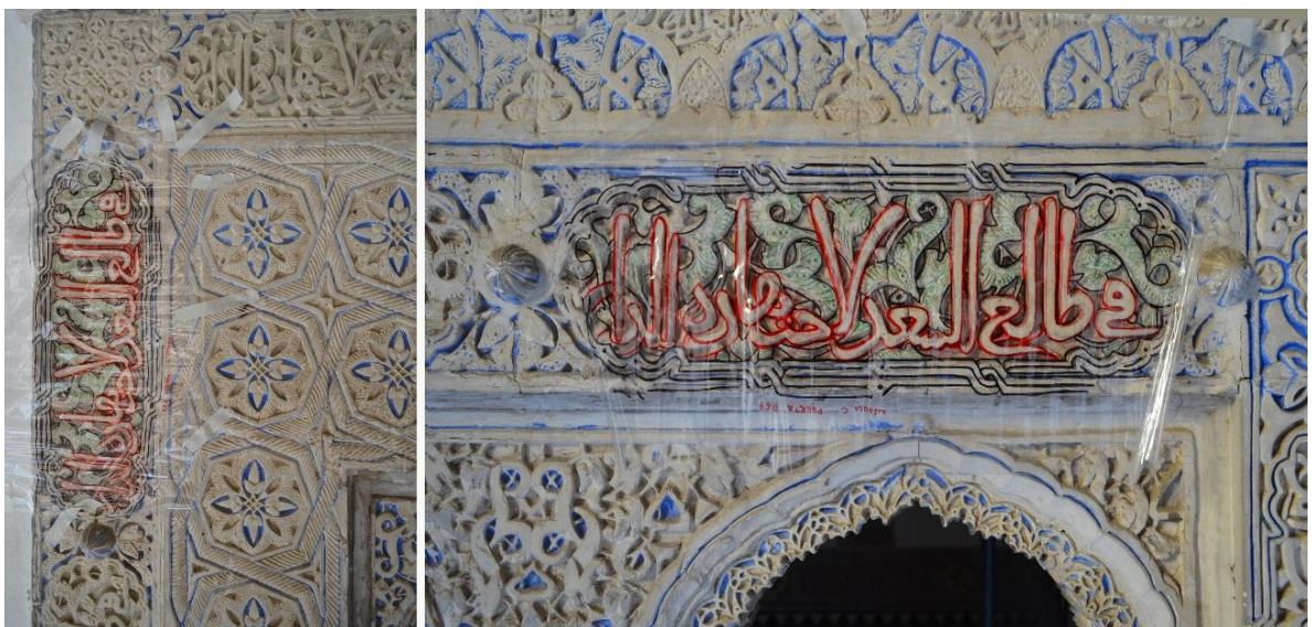
Figura 133. A la derecha, calco sobre una de las cartelas epigráficas que se localizan en la puerta pequeña o de escape. A la izquierda, transposición del mismo calco en la ventana occidental donde se comprueba que han sido sacados de la misma placa, ya que coinciden a la perfección todos los elementos decorativos del mismo.
