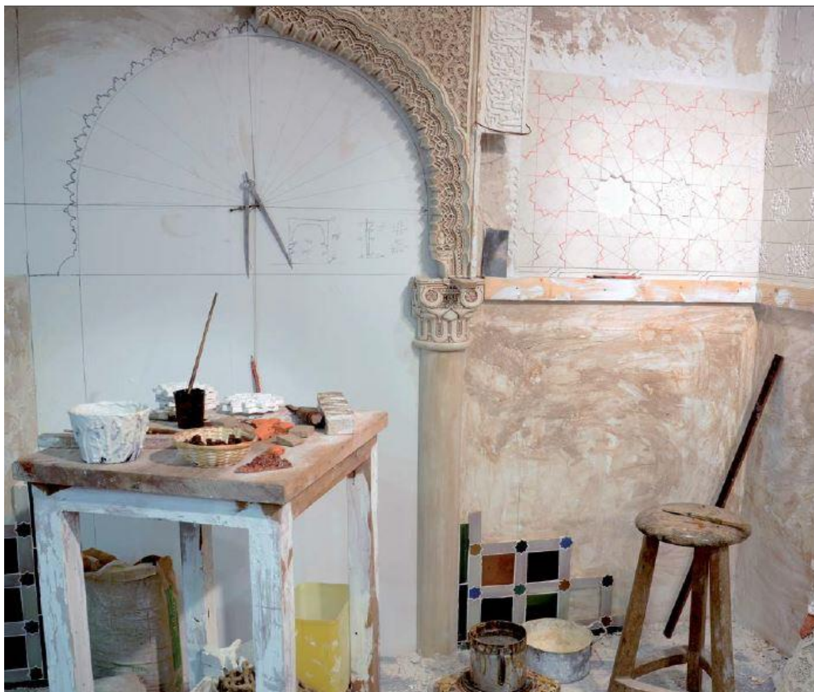
Figura89. Imagen reconstruida de las herramientas empleadas para la ejecución de la decoración. Imagen extraída (Patronato de la Alhambra y Generalife, 2015, p.44).
