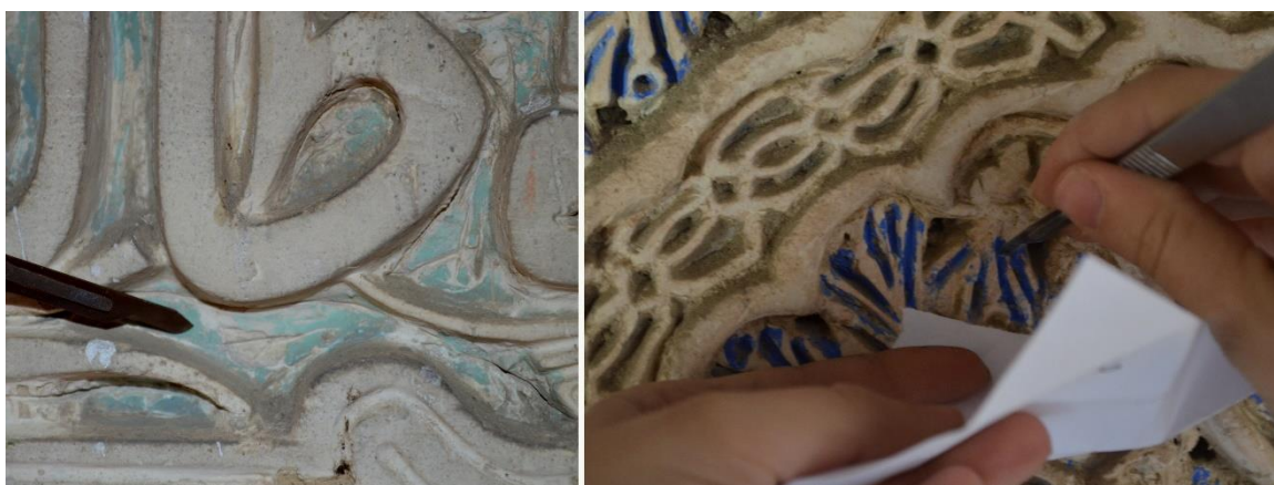
Figura 2. Imágenes de la toma de muestra efectuada en el paramento.
