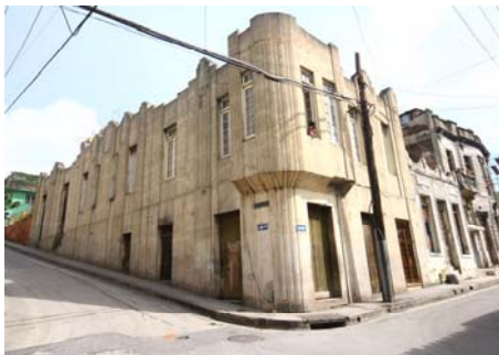
Casa-establecimiento en Reloj N° 351 esquina San Gerónimo, Centro Histórico, 1930. Rodulfo Ibarra
