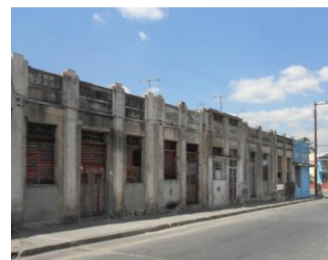
Calle 10 N° 2, 2 1/2 , 4, 6, 214 y 216 esquina Cuabitas
