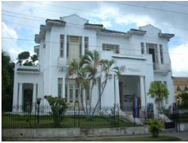
Vivienda en calle 6 N° 253 (neocolonial ecléctico)
