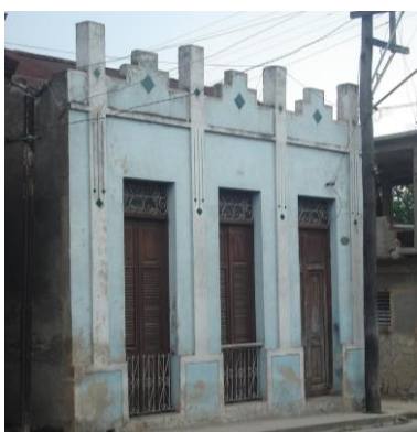
Ave. Jesús Menéndez N° 1152 esquina calle 6
