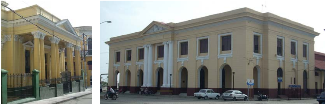
Figura 2.21.- The National City Bank of New York (1908) y el edificio de La Aduana (1909)
