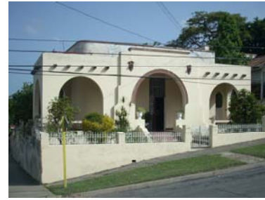
Vivienda en calle 4 N° 206 (neocolonial mediterráneo)
