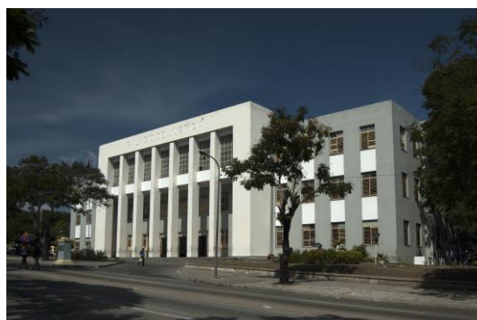
Obra construida en los años cincuenta
