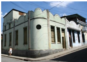
Maceo Nº 303 y 305 esquina San Fermín
