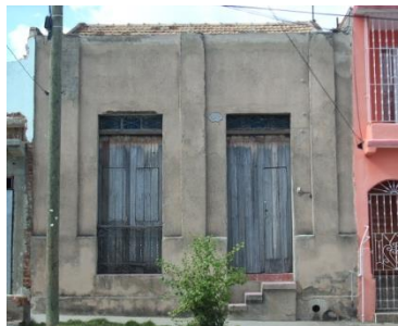
Calle B N° 99 e/ Ave. de Céspedes y calle 3
