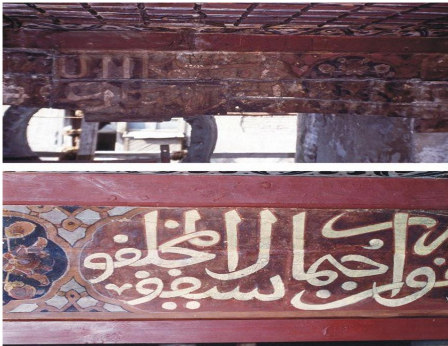
Fig. 37: Detalle de los tallados de texto coránico antes y después de la restauración, sala principal de la Madraza de Sonqor Al-Saadi (Fuente: CIERA)
