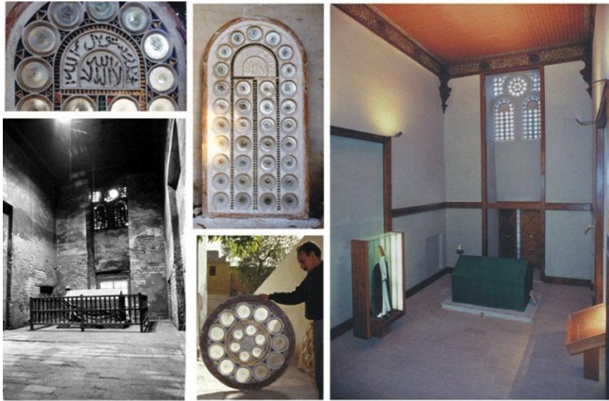
Fig. 41: Detalle de las ventanas de vidrieras de colores, antes, durante y después de la restauración, aula de la Madraza de Sonqor Al-Saadi (Fuente: CIERA)
