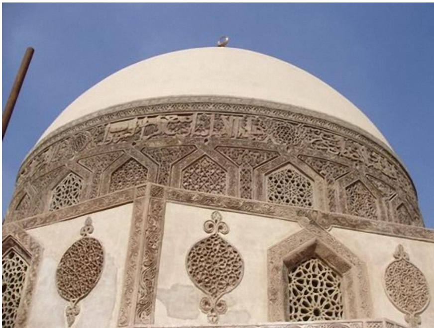
Fig. 33: Cúpula del mausoleo de Hassan Sadaqa , vista desde la calle Al-Suyufiyya . Detalle de la decoración tallada en madera y yeso (Fuente: CIERA)
