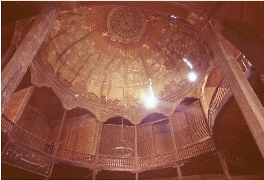
Fig. 68: Bóveda de la Sama khana , antes de la restauración (Fuente: CIERA)
