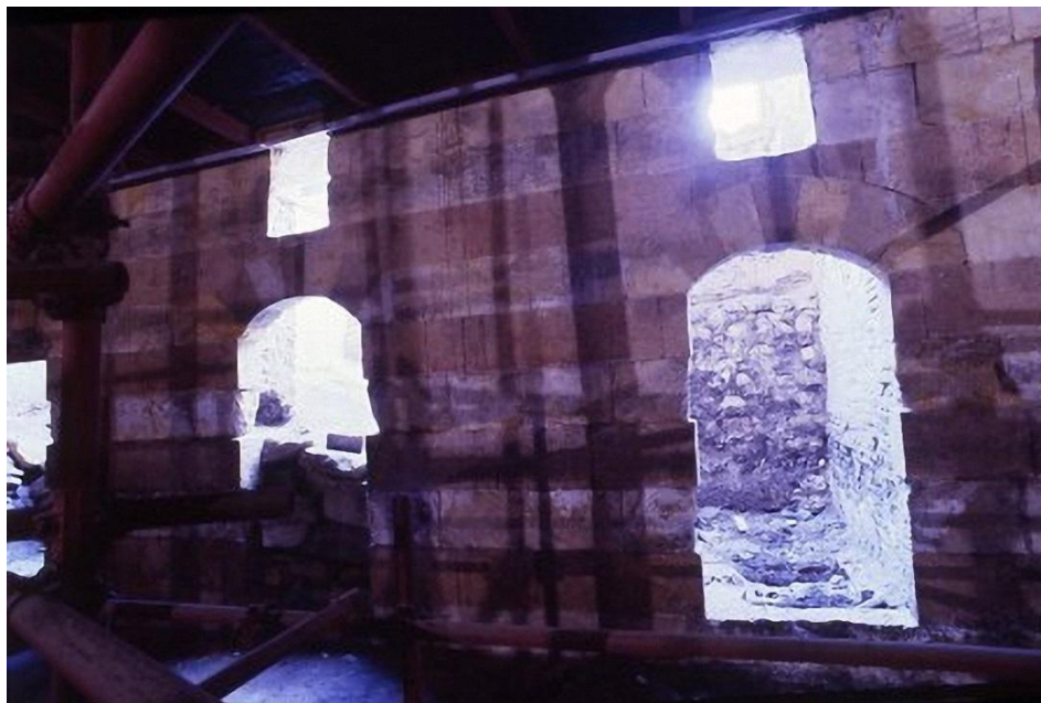
Fig. 53: Sala de baños, diferentes entradas, durante el proceso de restauración (Fuente: CIERA)
