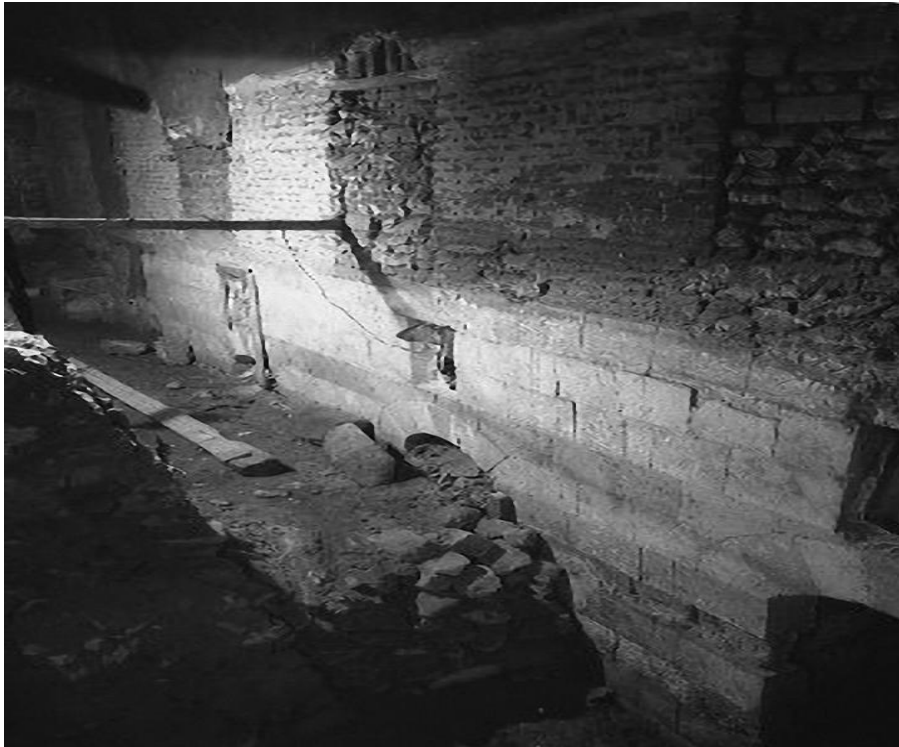
Fig. 55: Sala de baños, diferentes entradas casi totalmente enterradas, antes de restauración (Fuente: CIERA)
