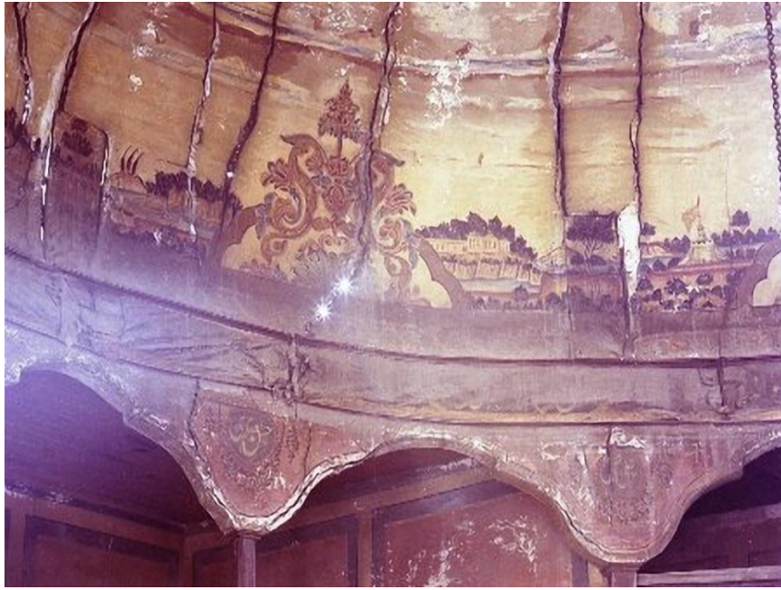
Fig. 84: Bóveda de la Sama'khana antes de la restauración. (Fuente: CIERA)
