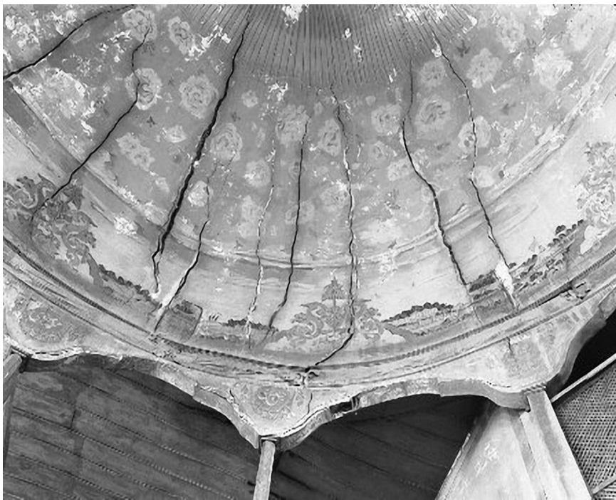
Fig. 69: Bóveda de la Sama khana , antes de la restauración (Fuente: CIERA)
