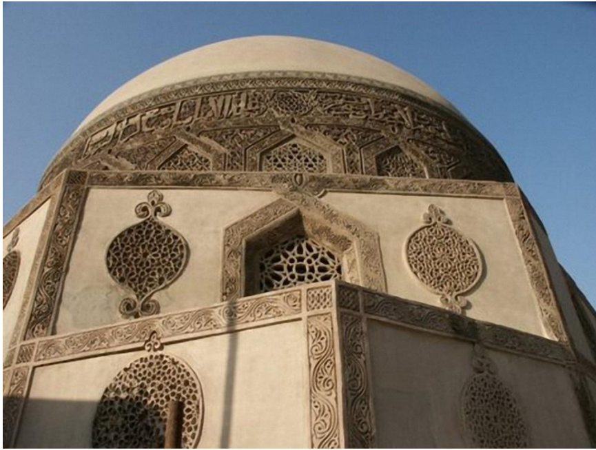
Fig. 32: Cúpula del mausoleo de Hassan Sadaqa , vista desde la calle Al-Suyufiyya . Detalle de la decoración tallada en madera y yeso (Fuente: CIERA)
