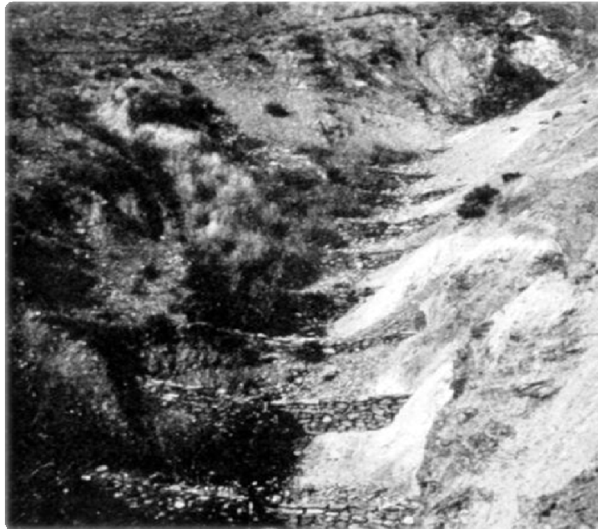
Imagen 31: Sucesión clásica de diques o pequeñas albarradas destinadas a la contención de laderas. Fuente: Fototreca INIA
