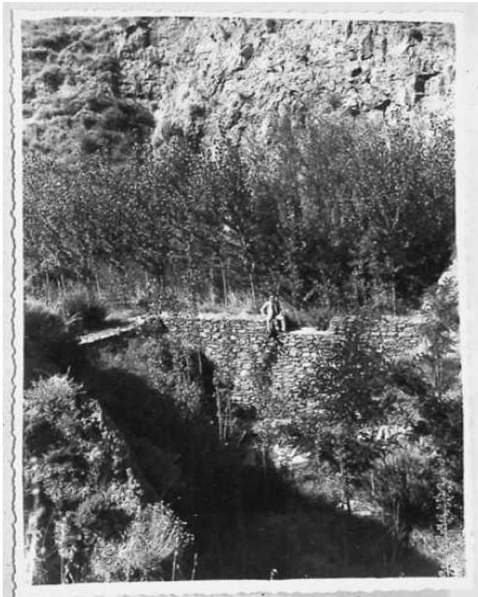
Número 27.- Cenes de la Vega. Dique de gaviones metálicos en las obras de corrección del barranco de la Palma y plantación de frondosas en el aterramiento. Año 1.941.
