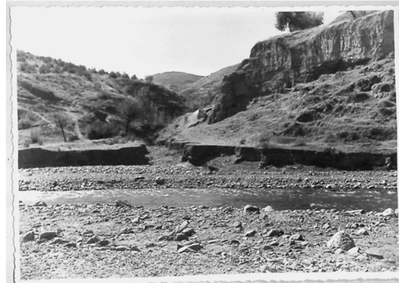
Número 29.- Cenes de la Vega. Efecto de los trabajos de res- tauración sobre el cono de deyección del barranco de La Palma.
