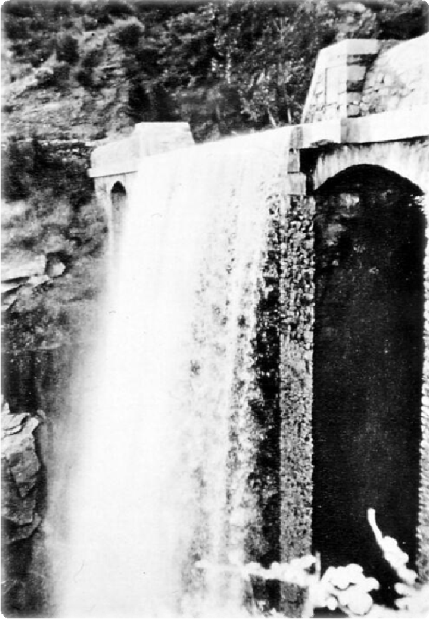
Imágenes 71 y 72: Izquierda, vista cercana del dique 1-B de 29,30 metros de altura y 67 de coronación, en el río Chico, año 1.963 Dique 24. Derecha en el año 2.015
