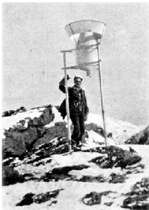
Imágenes 50 y 51: Pluviómetro totalizador, sistema Mougín. Refugio Elorrieta. Sierra Nevada
