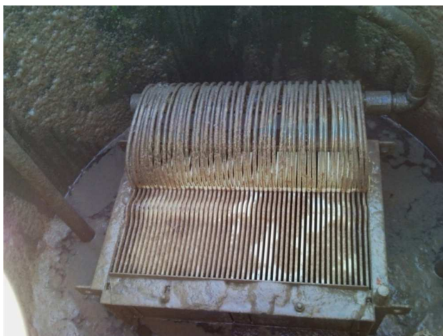
Figura 3.3. Módulo de membranas de microfiltración MBR-MF.
