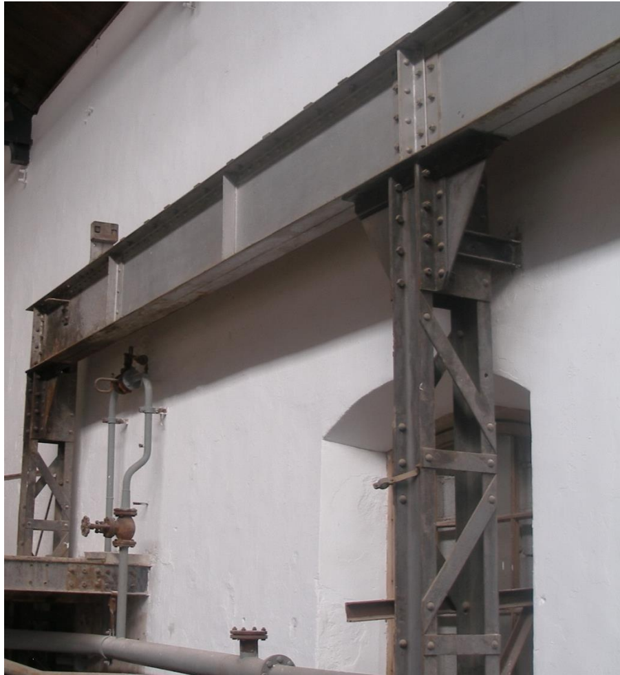
Figura 96. Columnas de perfiles de acero laminado en Fábrica Nuestra Señora del Pilar (Motril). Fuente: Elaboración propia.
