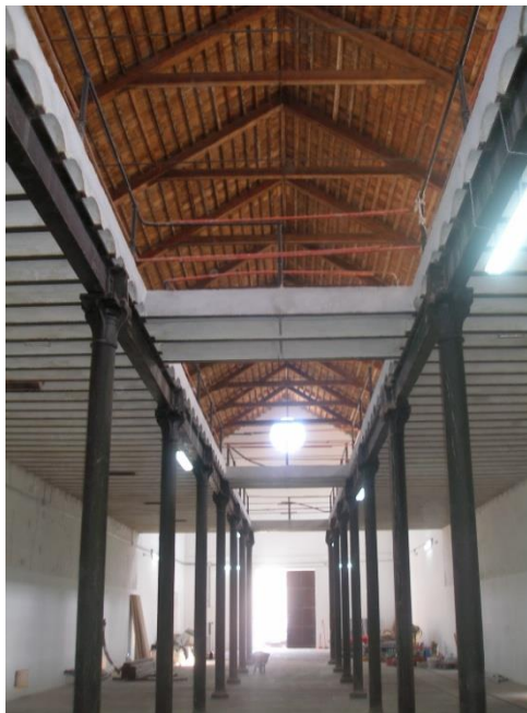
Figura 105. Forjados de bovedillas en el recinto de la Fbrica de Nuestra Seora del Pilar (1882, Motril), durante el proceso de restauracin (abril de 2008). Fuente: Elaboracin propia.
