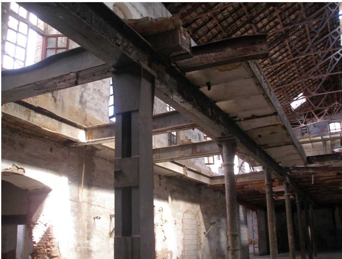
Figura 106. Forjado de bovedillas en Fábrica de San Isidro, ubicado en la zona de la primera construcción (1901). Fuente: Elaboración propia.
