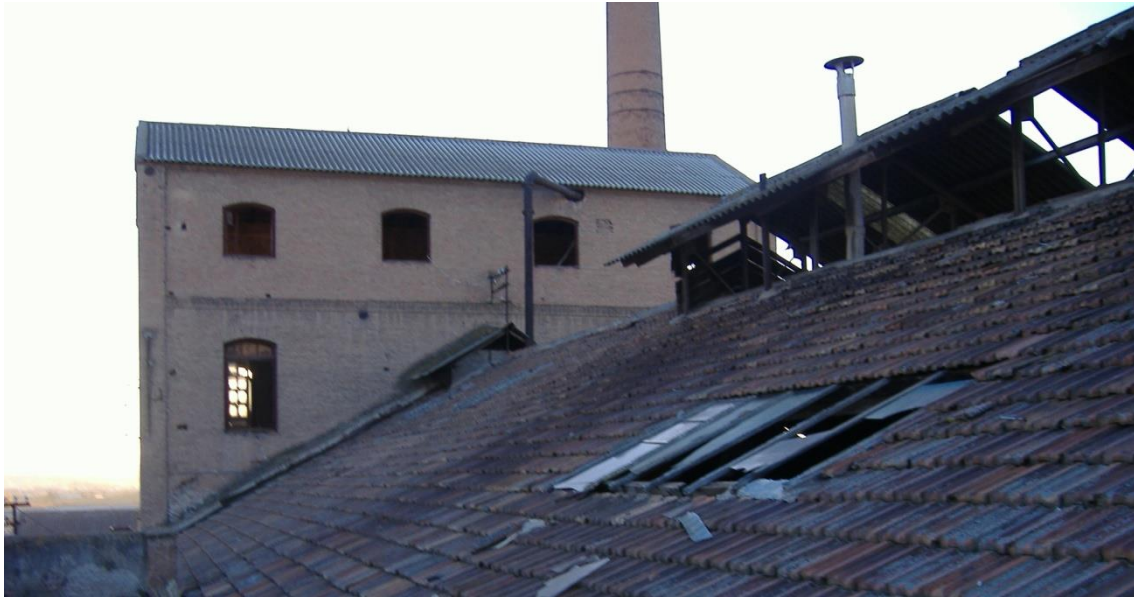
Figura 120. Lucernario en Fábrica de San Isidro, con chimenea reforzada al fondo. Fuente: Elaboración propia.
