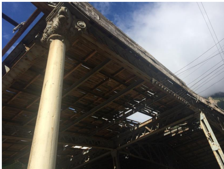
Figura 182. Pilares de fundición, columnas de acero laminado empresilladas y vigas de acero en Estación de Canfranc. Fuente: Elaboración propia.
