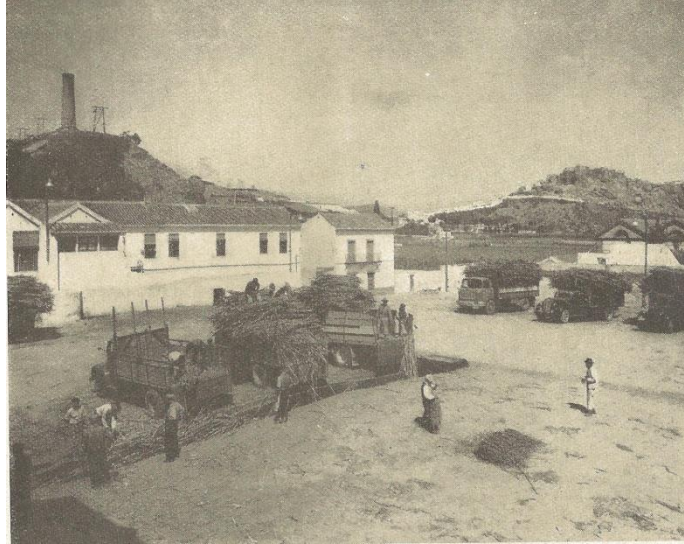
Figura 5. Plaza para la descarga de la caña en las instalaciones de la Fábrica N o Sra. del Rosario de Salobreña. Fuente: (Azucarera de Salobreña Nuestra Señora del Rosario S.A., 1961, pág. 13).
