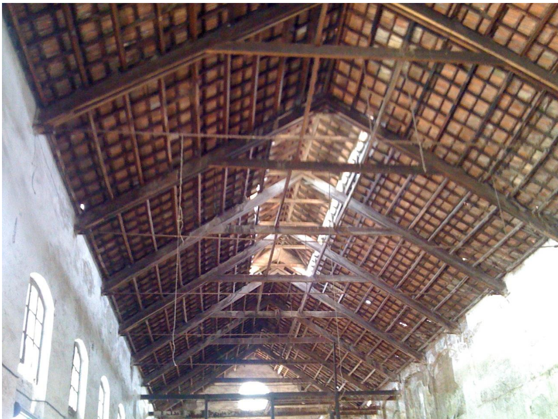
Figura 26. Estado del lucernario del "salón de aparatos" en julio de 2009. Fuente: Elaboración propia.
