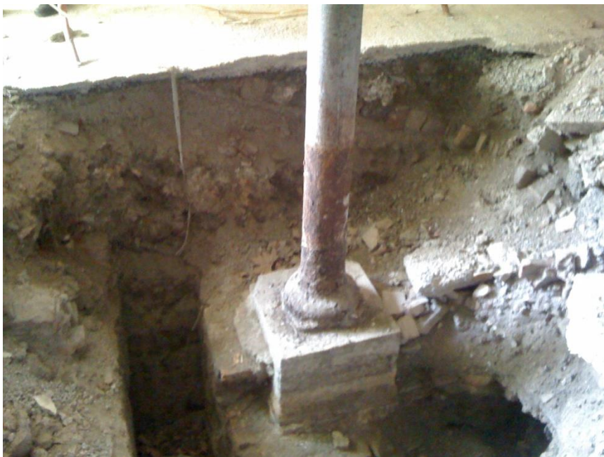
Figura 57. Estado de cimentación aislada del Ingenio de Nuestro Señor de la Salud en julio de 2009. Fuente: Elaboración propia.
