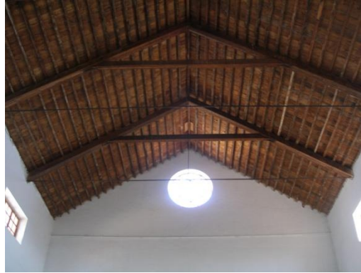
Figura 75. Cubierta de madera restaurada en Fábrica Azucarera del Pilar (1882). Fuente: Elaboración propia.
