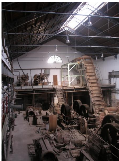
Figura 4. Conjunto principal de maquinaria en Nuestra Señora del Pilar (Motril), en abril de 2008. Fuente: Elaboración propia.
