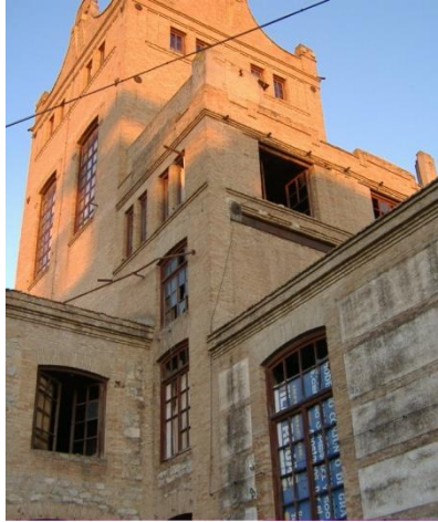
Figura 113. Edificio de la alcoholera de San Isidro (noviembre de 2007). Fuente: Elaboración propia.
