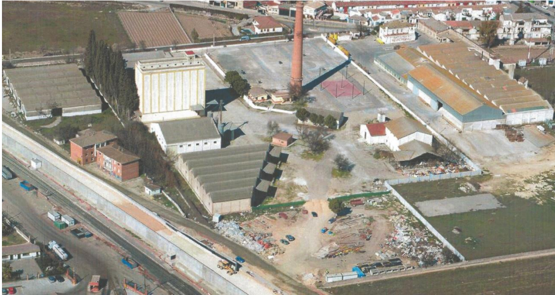
Figura 49. Azucarera Nueva Rosario: solar, chimenea y almacenes aún en pie. Fuente: Colección privada del autor.
