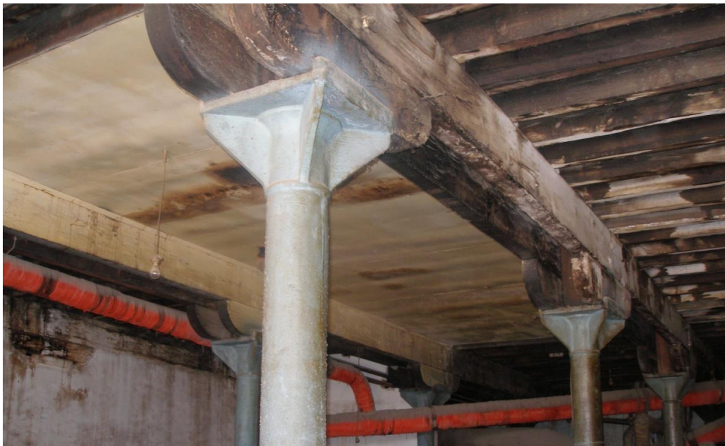
Figura 90. Pilares de fundición sosteniendo vigas de madera en edificio de almacenes de la Fábrica Azucarera Nuestra Señora del Pilar (Motril, 1882). Fuente: Elaboración propia.
