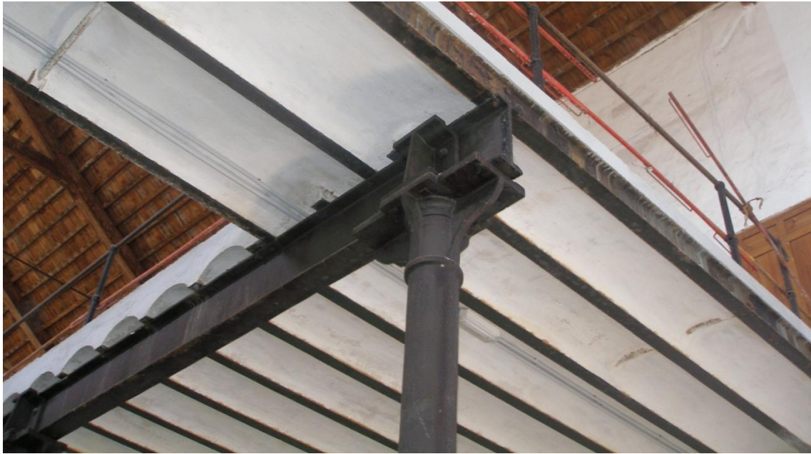
Figura 102. Vigas de acero laminado en forjados en Nuestra Señora del Pilar (Motril, 1882). Estado de la restauración parcial en abril de 2008. Fuente: Elaboración propia.
