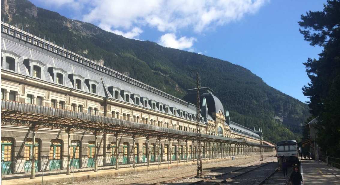
Figura 181. Estado de la Estación Internacional de Canfranc en agosto de 2013. Fuente: Elaboración propia.
