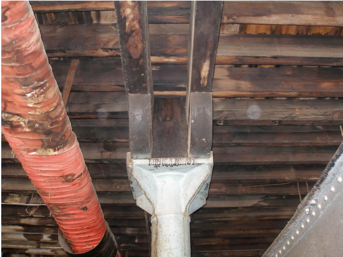
Figura 119. Forjado de madera en Fábrica Nuestra Señora del Pilar (Motril, 1882). Fuente: Elaboración propia.
