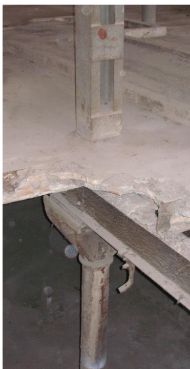
Figura 95. Cambio en tipologías estructurales en las columnas de dos plantas sucesivas, correspondientes a dos períodos constructivos diferentes, en la Fábrica de San Isidro. Fuente: Elaboración propia.
