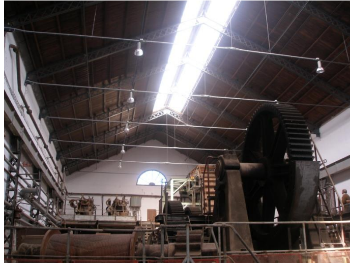
Figura 111. El conjunto industrial de la Fábrica de Nuestra Señora del Pilar en Motril (1882) está considerado como uno de los cinco más importantes de España desde el punto de vista del Patrimonio Industrial. Fuente: Elaboración propia.
