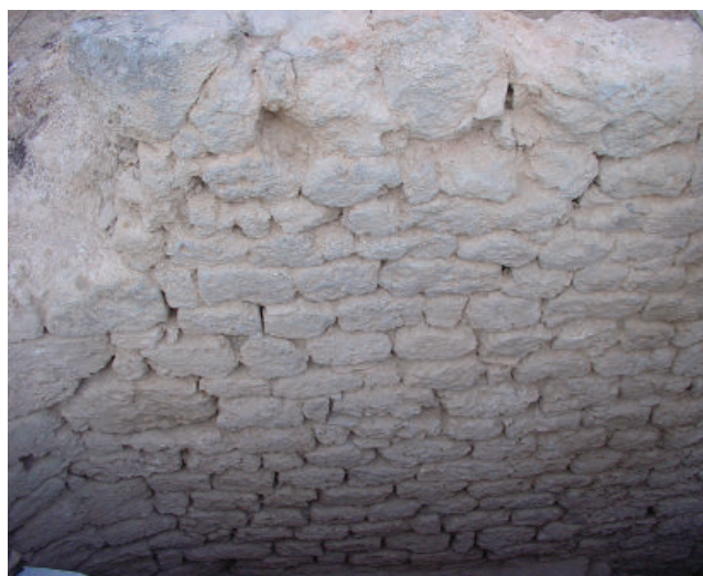
Fig. 87. Álamo del Marqués (GRD-045). Detalle de una de las paredes internas del depósito (Fotografía: M. Luisa Gámez-Leyva)
