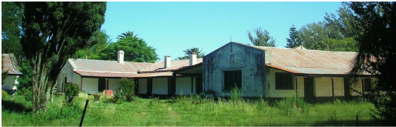
Imagen N°143: Estancia Loma Alta . Casa Principal o Mayorazgo. Arr.: Acceso principal (en desuso). Ab.: Acceso lateral-Este.
