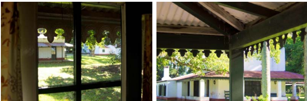
Imagen N°170: Ventanas y galerías [Fotog.: Moreno González, 2013].
