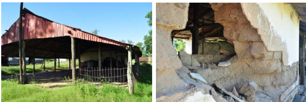
Imagen N°146: Estancia Loma Alta . Izq: Galpón de ensillar caballos. Der: Detalle de la “construcción en terrón” [Fotog.: Soto Farías, 2010].
