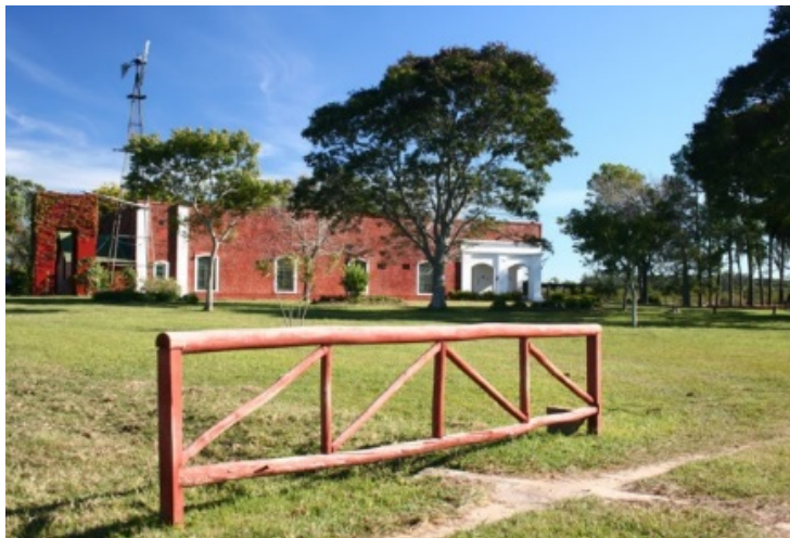
Imagen N°61: Estancia Yapeyú . Izq: Fachada Principal 23 .
