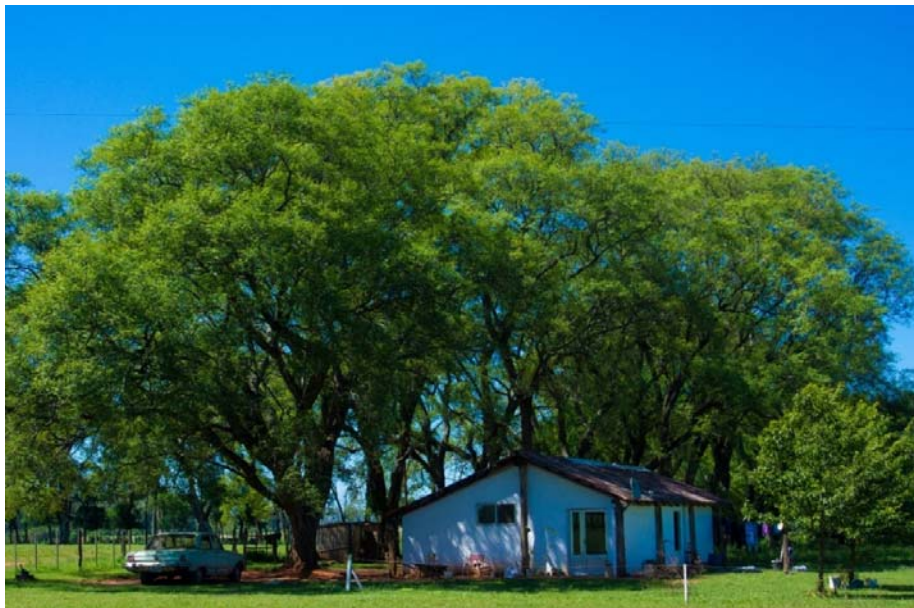
Imagen N°104: Casa del peón, estancia La Armonía . Vista N-O (Fotog.: Moreno González, 2013).
