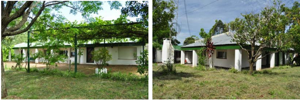
Imagen N°113: Sector más antiguo de la casa de La Higuera Cué . Izq: Vista Norte (Fachada principal, paralela a la RP114). Der: Vista Suroeste [Fotog.: Soto Farías, 2009].
