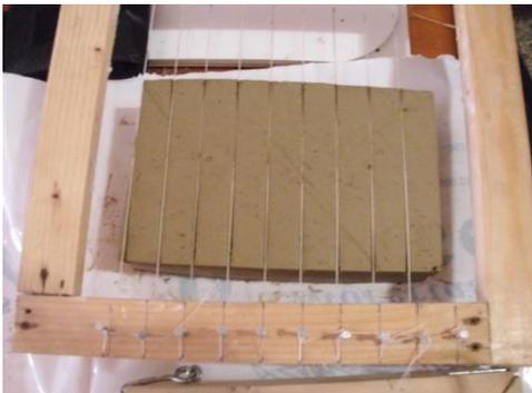
**Figura 31.** Marcado para el corte
