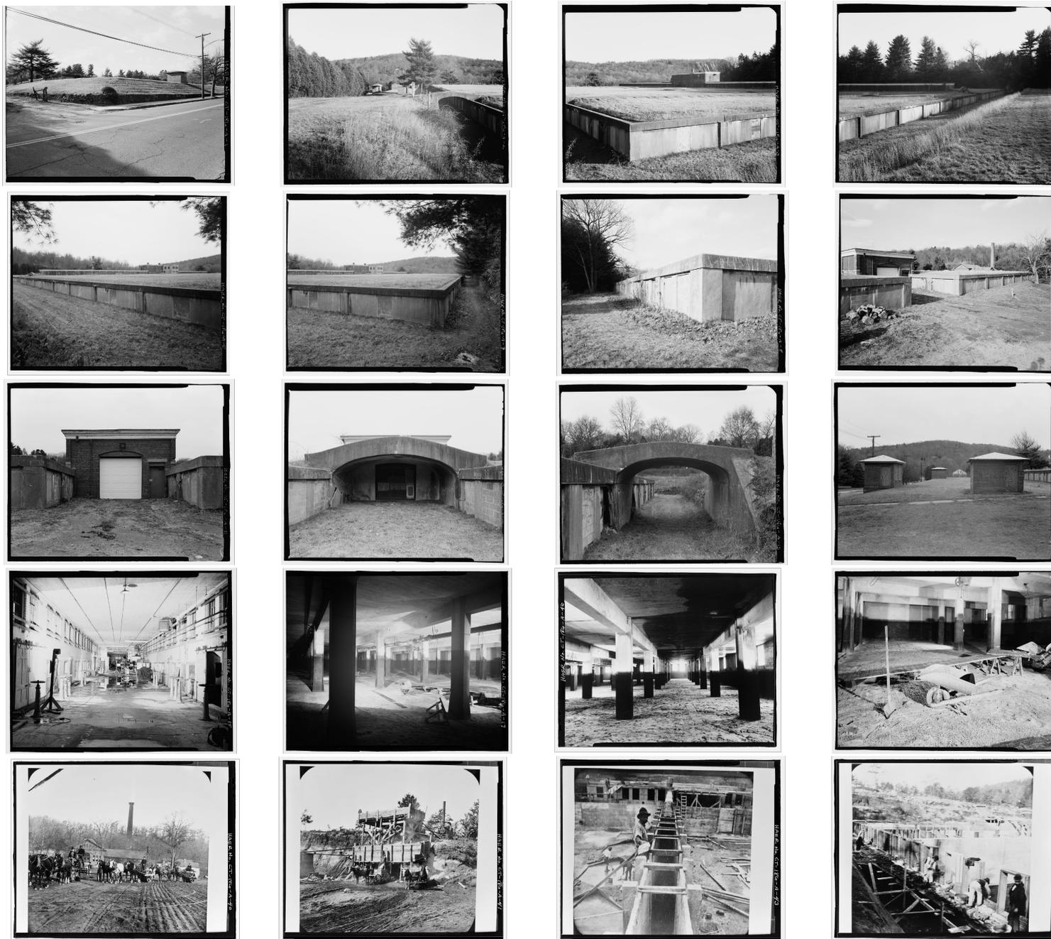
[Figura capIII 33-52] Vista sin de la Antigua planta de filtrado Whitney, silo de árido de filtro y relación con el paisaje, cisternas bajo la cama de filtrado y proceso de construcción.
