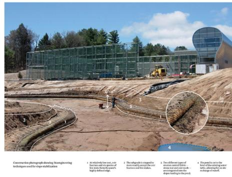
[Figura capIII 70] Fotografía de la construcción que muestra técnicas de bioingeniería utilizada para estabilización de taludes.
