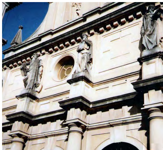
Fachada de la iglesia del Colegio Mayor Isabel la Católica
