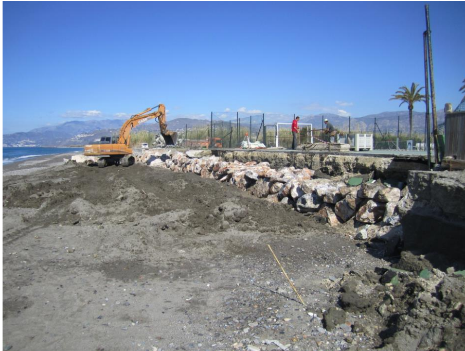
FIGURA 34: CONSTRUCCIÓN DE BARRERA ARTIFICIAL PARA LA PROTECCIÓN DE LA SUBIDA DEL NIVEL DEL MAR.
