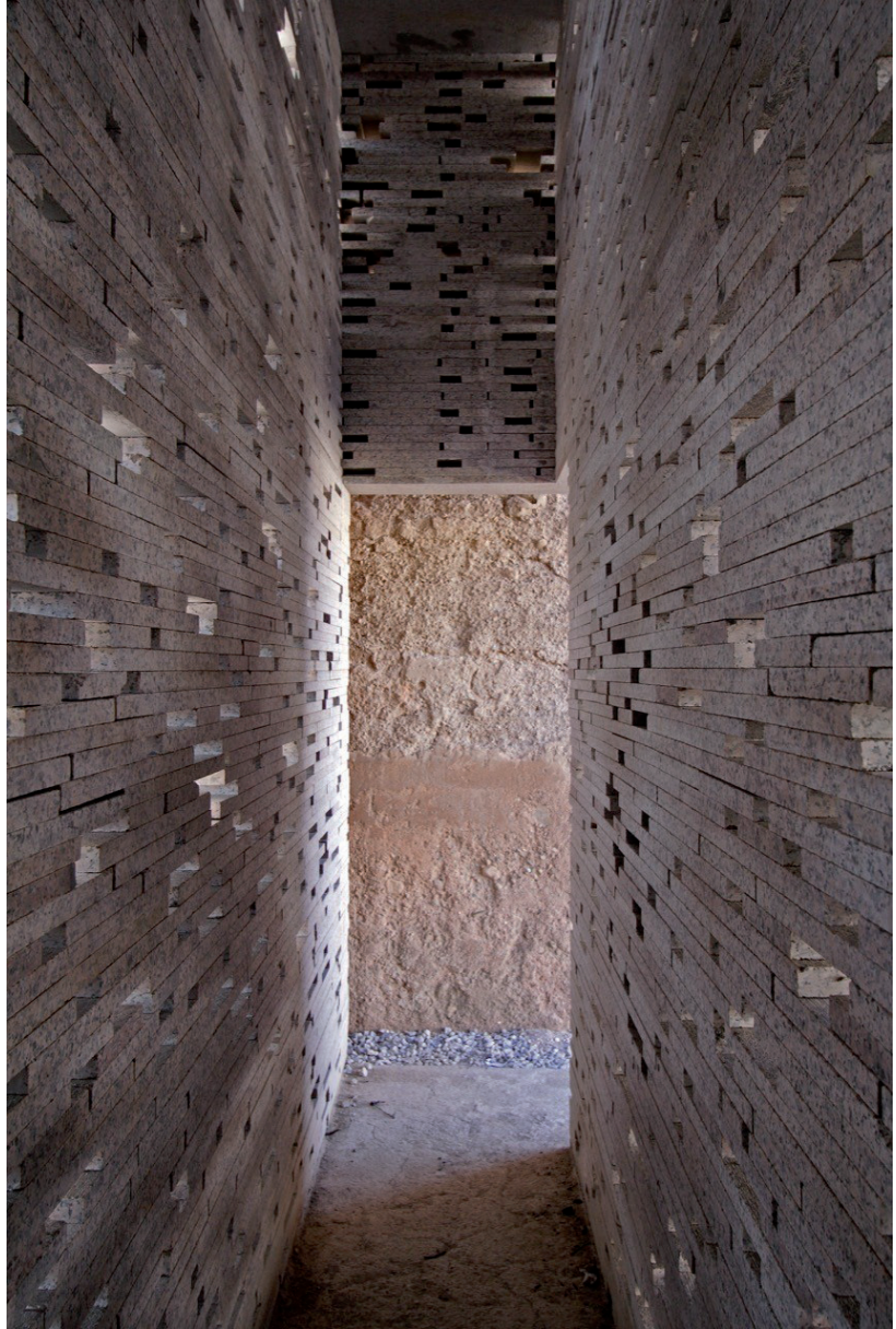
151. Antonio Jiménez Torrecillas, Restauración de la muralla nazarí en el alto Albaicín, interior (Granada, 2005)
