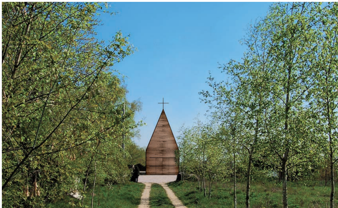
76. Estudio Beton, Capilla de madera (Tarnów, Polonia, 2009)
