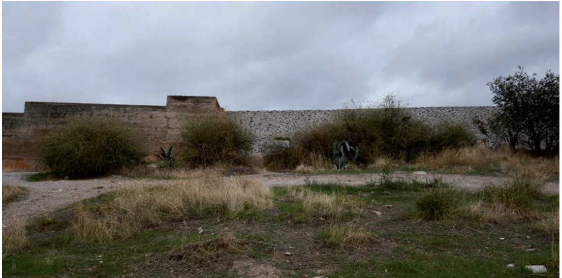
150. Antonio Jiménez Torrecillas, Restauración de la muralla nazarí en el alto Albaicín (Granada, 2005)
