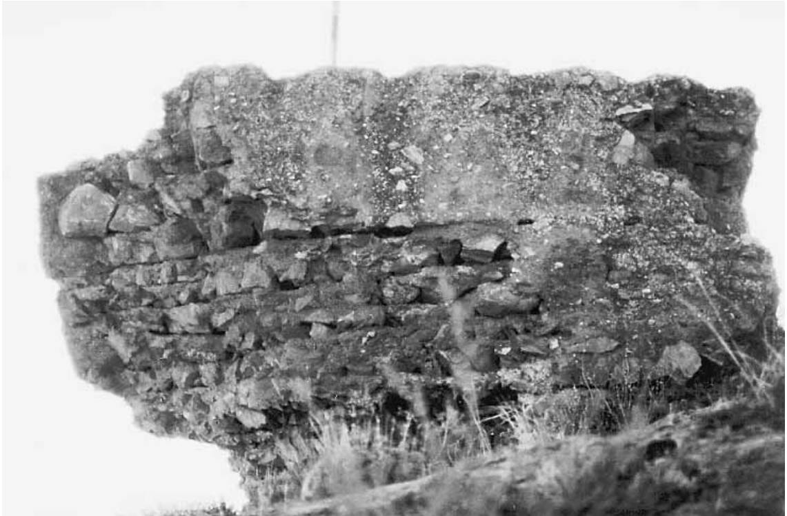
Fig. 5. Torre E. Detalle de la construcción en cal y cantos.
