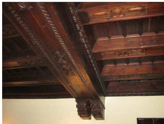
VIGAS SIN FUNCIÓN ESTRUCTURAL EN EL PALACIO DE LAJAROSA Y VIGA METÁLICA FORRADA CON MADERA EN EL PALACIO DE PÉREZ DE HERRASTI
