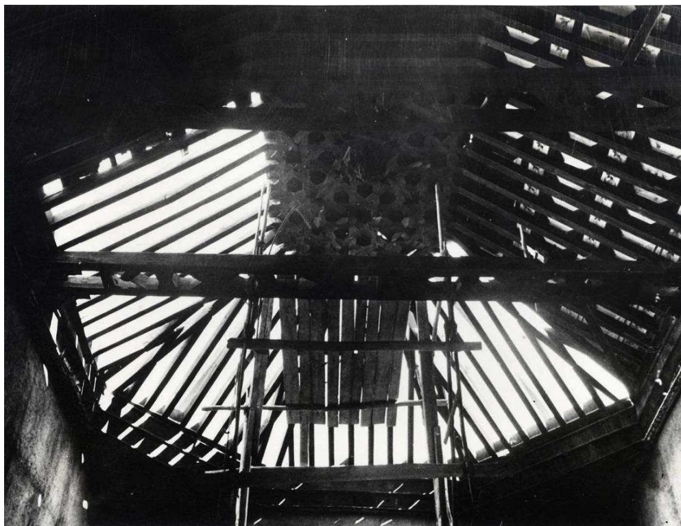
VISTA DE LA ARMADURA DURANTE EL TRANCURSO DE LOS TRABAJOS. (AGA.)
