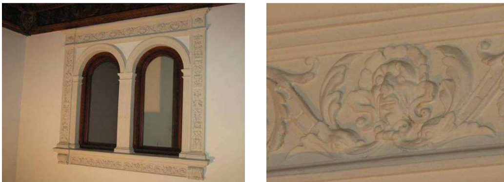
VENTANAS GEMINADAS DE LA ESCALERA
