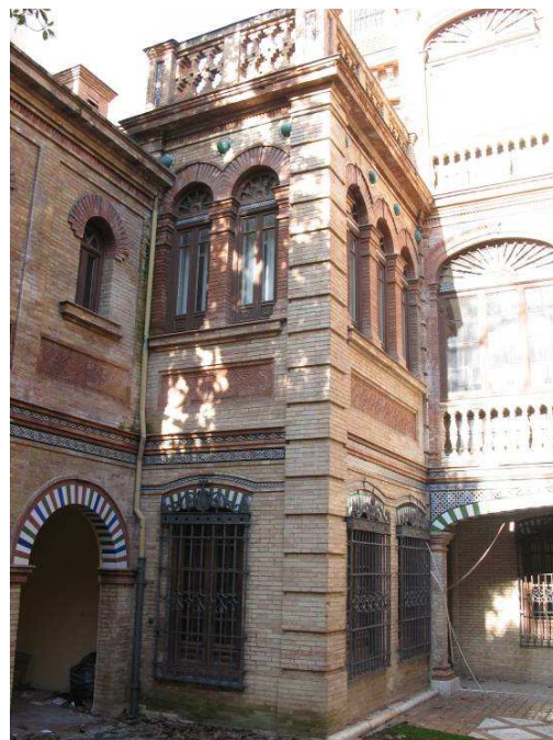
VISTAS GENERALES DE LA FACHADA
