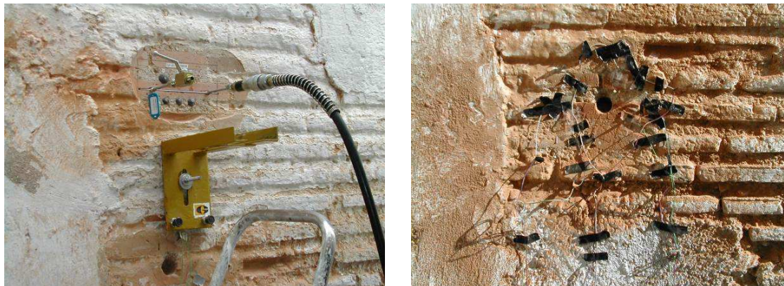
REALIZACIÓN DE GATO PLANO Y DE HOLE DRILLING EN CARRERA DEL DARRO, 25 (PROF. SÁNCHEZ BEITIA)
