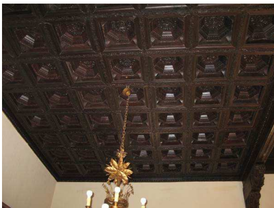
ALFARJE DECORATIVO SUSPENDIDO DE ESTRUCTURA METÁLICA EN EL PALACIO DE PÉREZ DE HERRASTI
