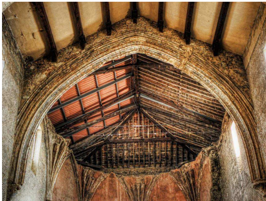
VISTA DEL TECHO DE LA CAPILLA MAYOR
