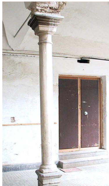
DESPLOME DE LA COLUMNA DE ESQUINA DEL PATIO RENACENTISTA DEL HOSPITAL MILITAR
