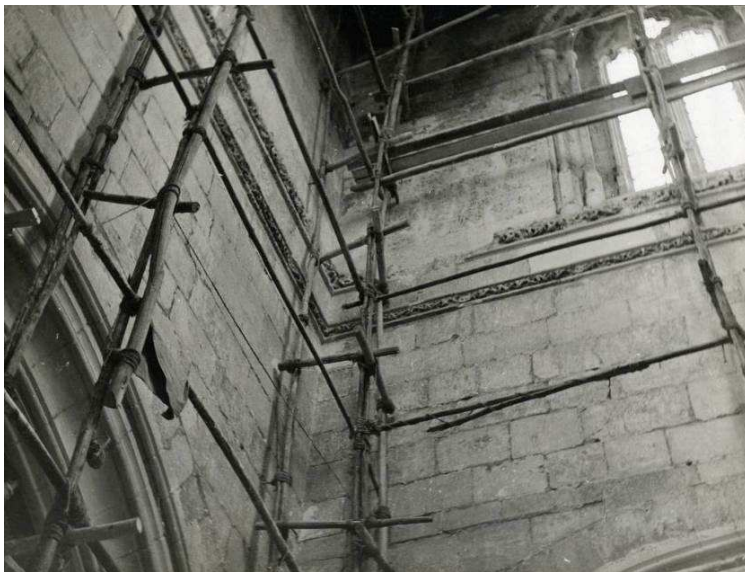
TRABAJOS DE RESTAURACIÓN DEL CIMBORRIO. AGA.
