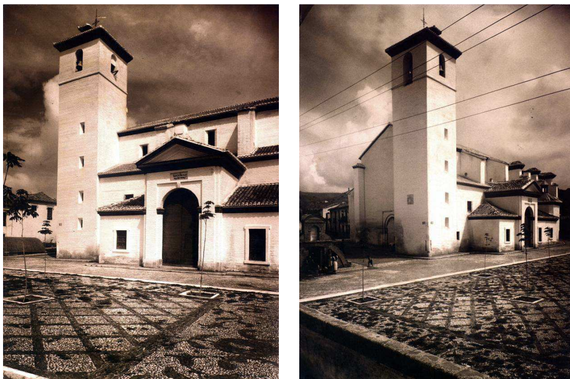
VISTAS DE LA IGLESIA DE SAN NICOLÁS DESPUÉS DE LA CONCLUSIÓN DE LA CUBIERTA (AHMG.)
