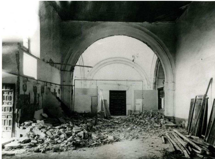
VISTA DEL CRUCERO EN EL TRANSCURSO DE LAS OBRAS. AGA.
