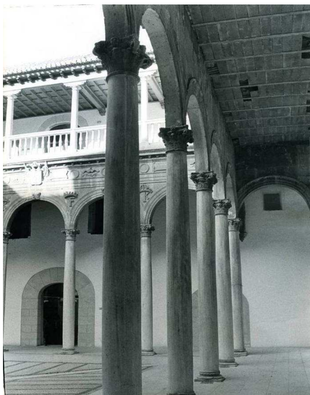
VISTA DE LA GALERÍA ANTES DE LA INTERVENCIÓN. (AGA.)
