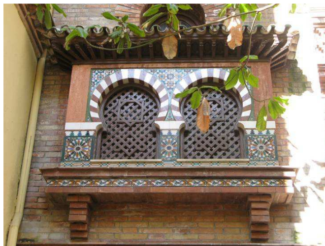
DETALLES DE LA FACHADA
