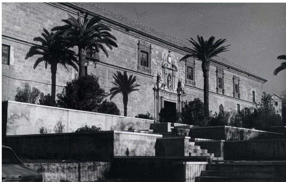
VISTAS DE LA FACHADA PRINCIPAL DEL EDIFICIO DESPUÉS DE LA INTERVENCIÓN. (AGA.)
