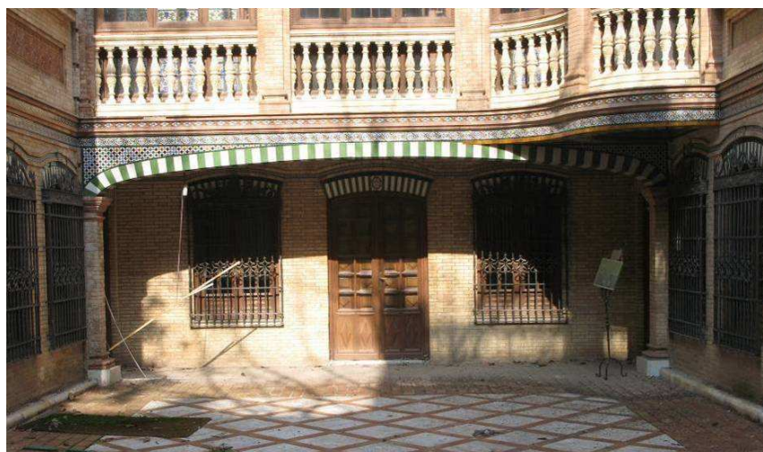
DETALLE DE LA PARTE DE LA FACHADA CORRESPONDIENTE A LA PLANTA BAJA
