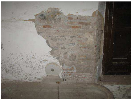
DETALLE DE LAS CABEZAS DE LAS VIGAS DEL CUERPO SOBRESALIENTE EN LA FACHADA. DETALLE DE LA FÁBRICA DE MAMPOSTERÍA Y LADRILLO DE LA FACHADA POSTERIOR.
