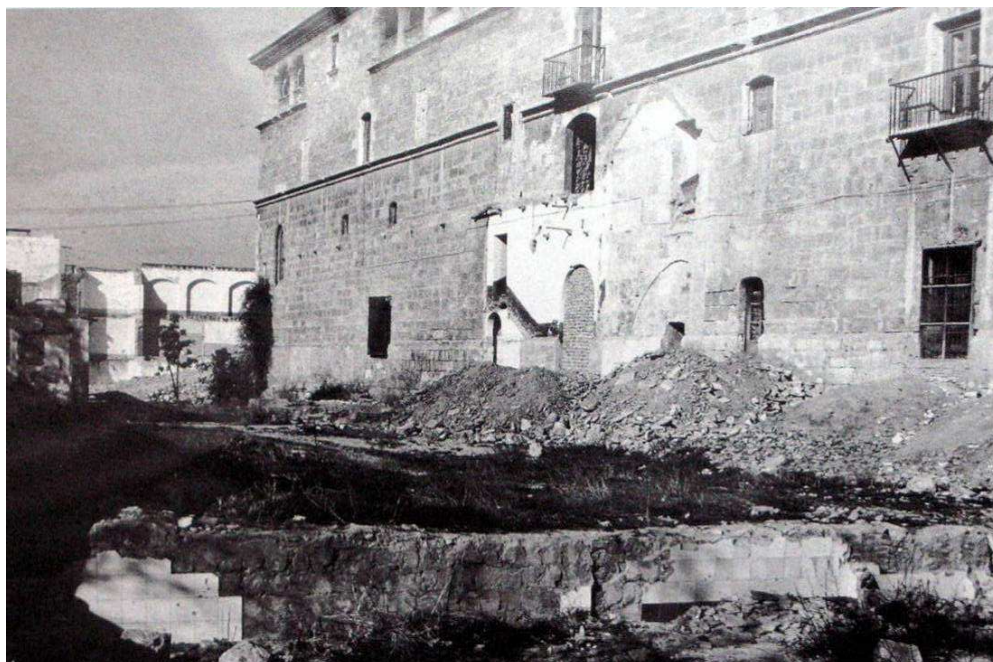
VISTA DEL EXTERIOR DEL EDIFICIO (FACHADA OESTE). (APRLG.)
