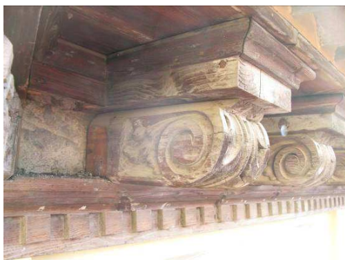
ZAPATAS DE HORMIGÓN ARMADO, CANES DECORATIVOS DE MADERA Y BALAUSTRADA DE PIEDRA ARTIFICIAL EN EL PALACIO DE PÉREZ DE HERRASTI
