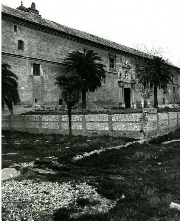
VISTA DE LA FACHADA PRINCIPAL DEL EDIFICIO ANTES DE LA INTERVENCIÓN. (APRLG.)
