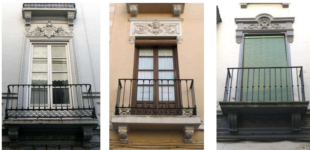
IMAGEN COMPARADA LOS BALCONES DE PLANTA PRIMERA DE LAS CASAS BUENSUCESO N° 19, 21 Y 23
