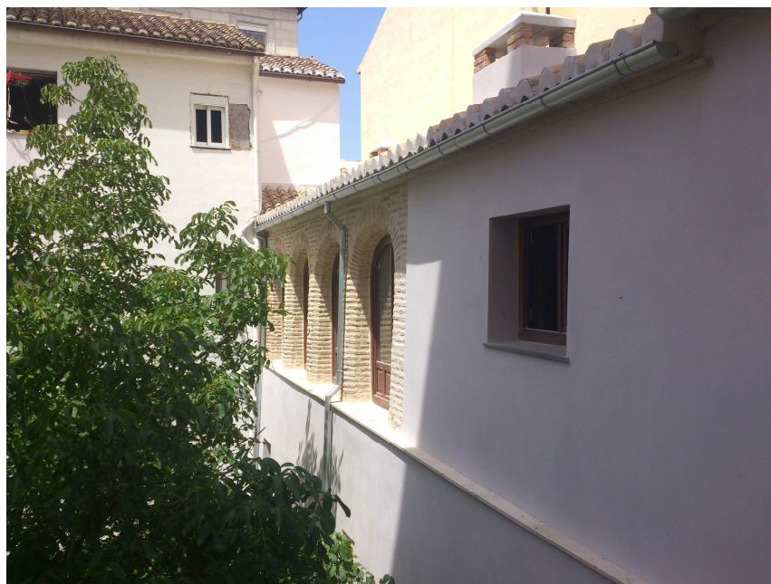
LOGGIA RENACENTISTA DE LA ANTIGUA CASA DE LA TERCIA HACIA EL PATIO, RECUPERADA TRAS LA INTERVENCIÓN DE REHABILITACIÓN DEL EDIFICIO (PROYECTO: FERNANDO ACALE)
