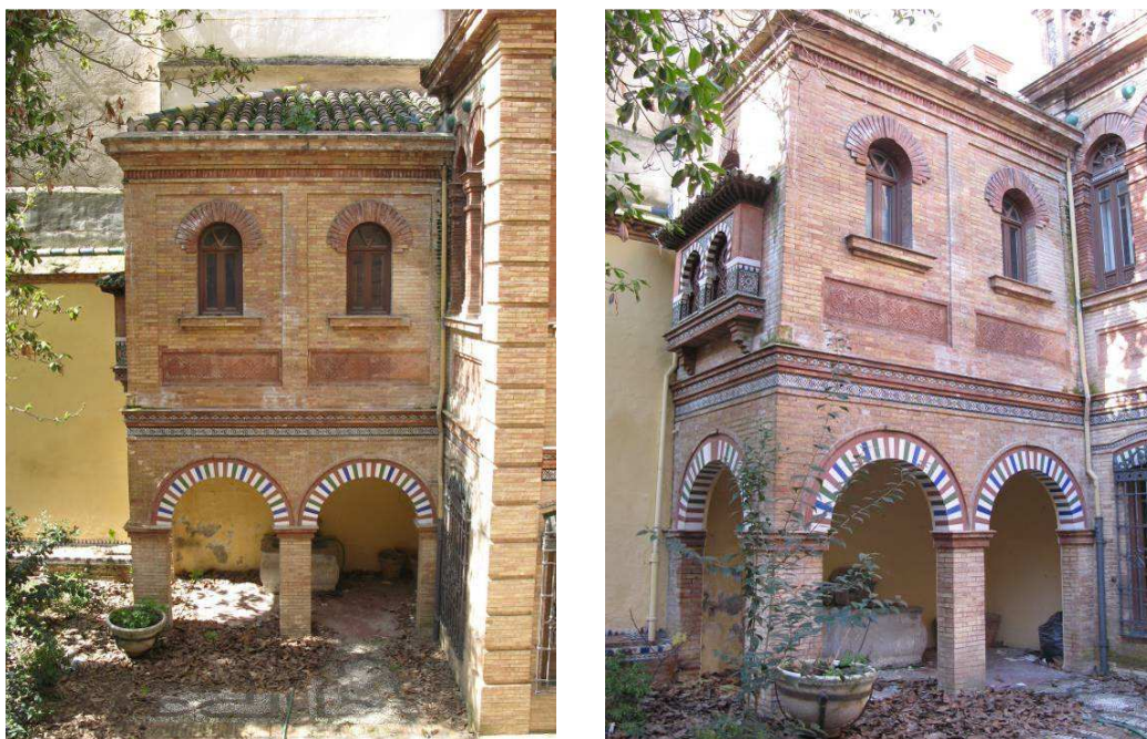
VISTAS GENERALES DE LA FACHADA
