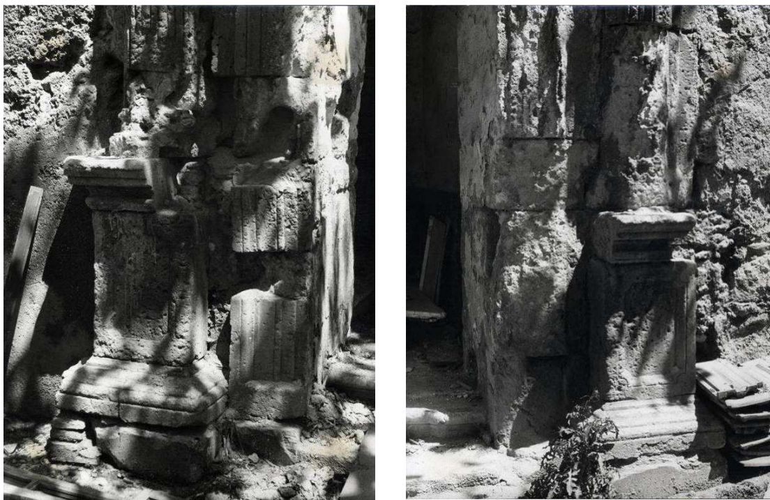
VISTAS DE LA PORTADA DE ACCESO A LA ESCALERA PRINCIPAL ANTES DE LA INTERVENCIÓN. (AGA.)
