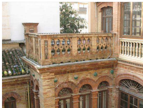
DETALLES DE LA FACHADA
