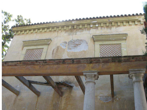
VISTAS DE LAS NUEVAS FACHADAS DEL EDIFICIO
