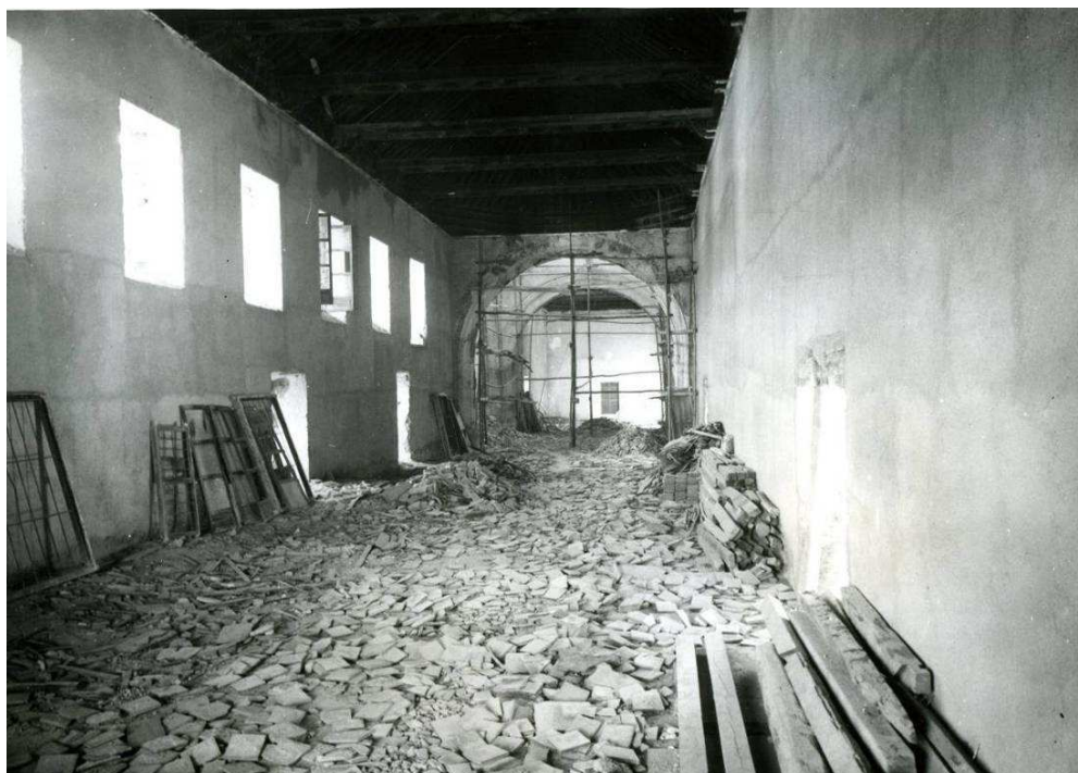
IMÁGENES DEL CRUCERO EN EL TRANCURSO DE LAS OBRAS. (AGA.)
