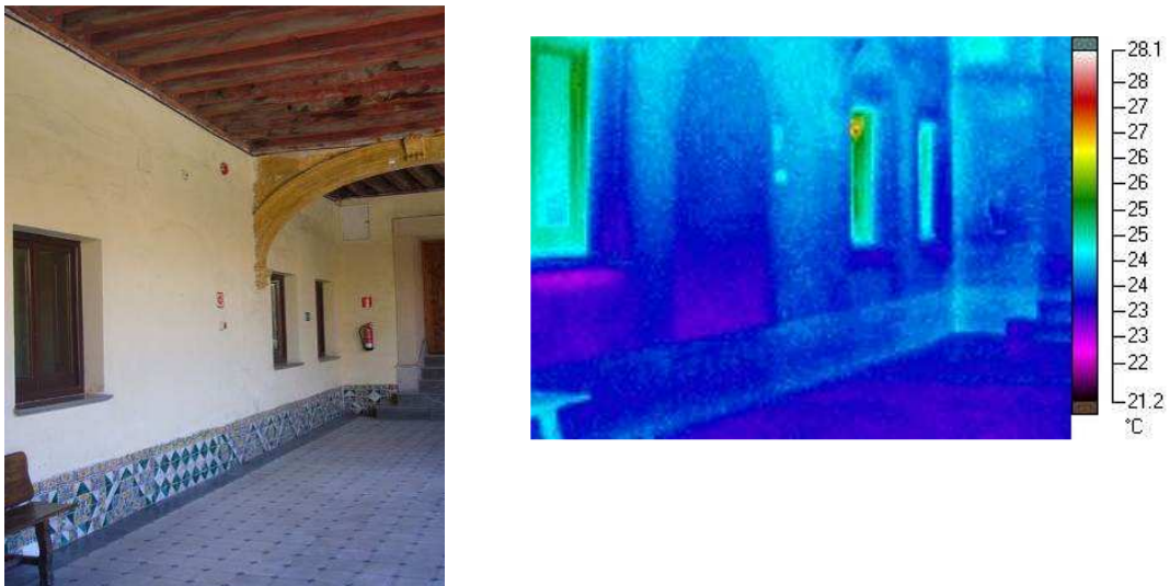
TERMOGRAFÍA DE LAS GALERÍAS DEL HOSPITAL DE SAN JUAN DE DIOS (PLAN DIRECTOR)
