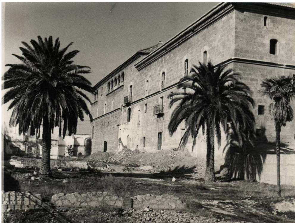
VISTA DE LA FACHADA LATERAL. (AGA.)
