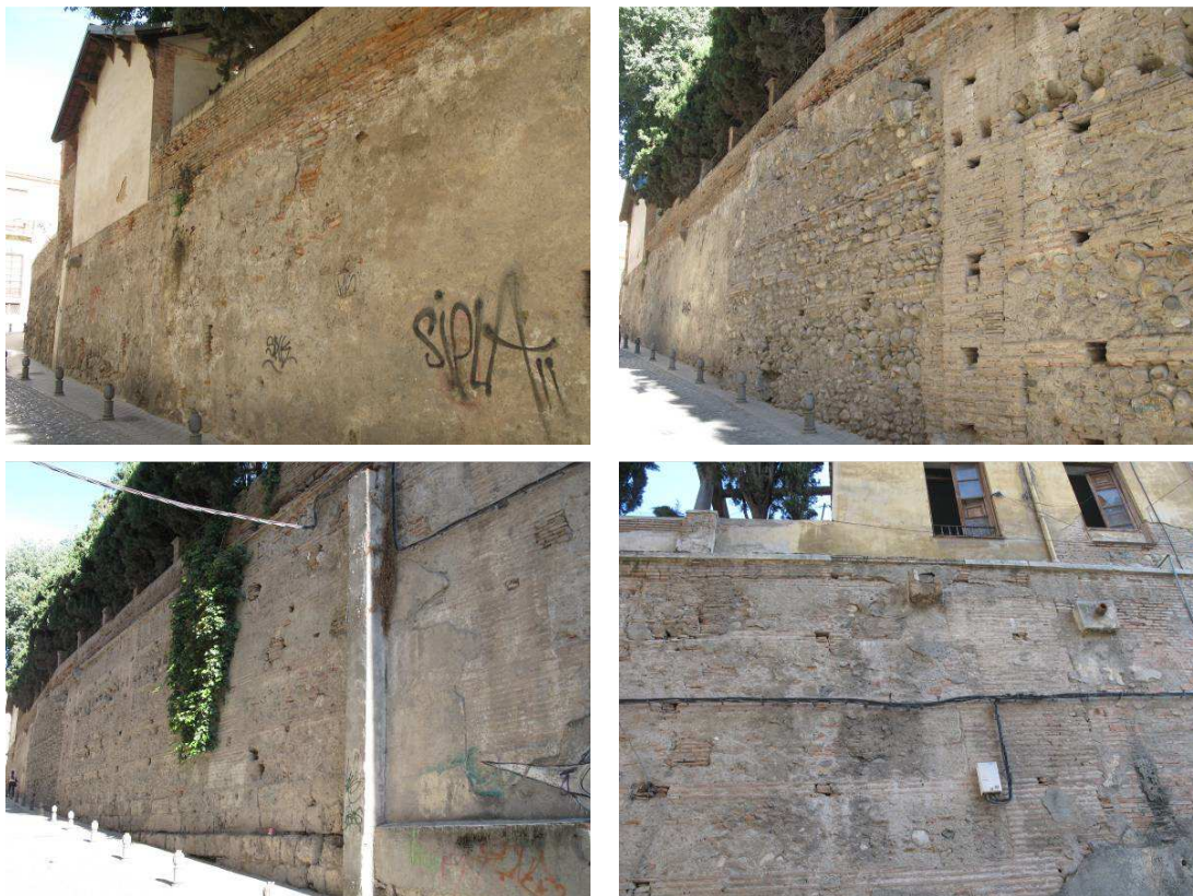
MURO DE CONTENCIÓN ACTUAL EN LA CUESTA DE AIXA, EN EL LUGAR QUE OCUPABA LA MURALLA
