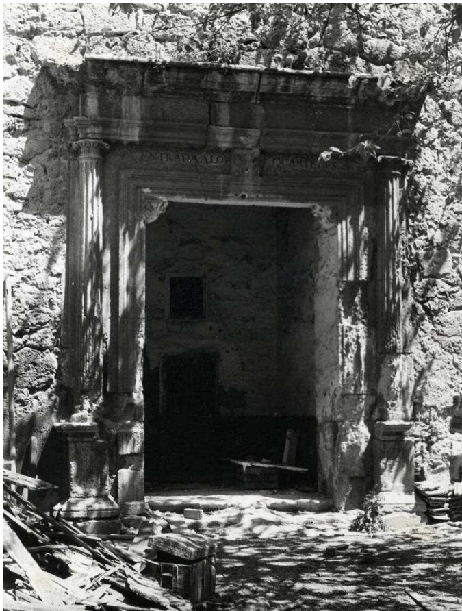
VISTA DE LA PORTADA DE ACCESO A LA ESCALERA PRINCIPAL ANTES DE LA INTERVENCIÓN. (AGA.)
