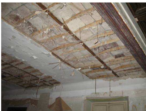
FORJADOS DE VIGUETAS METÁLICAS Y REVOLTONES DE LADRILLO CONSTRUIDOS POR WILHELMI EN LAS REFORMAS DE CARRERA DEL DARRO Nº 11 Y EN EL PALACIO DE PÉREZ DE HERRASTI
