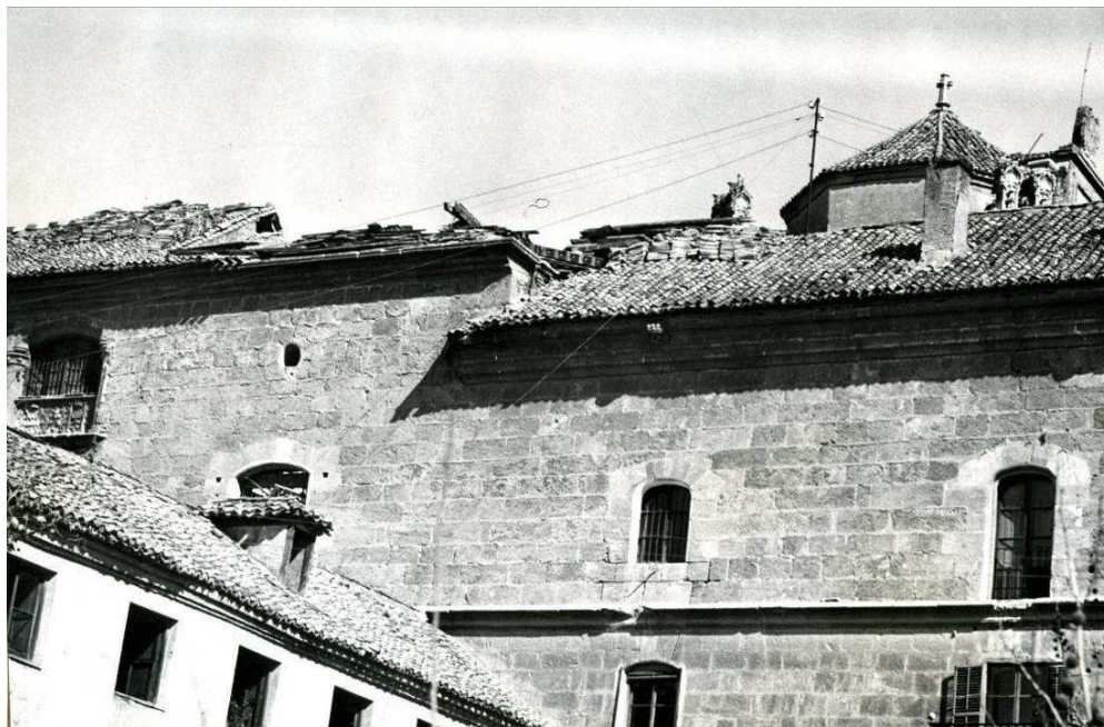
VISTA DE LA FACHADA OCCIDENTAL, ANTES DE LA DEMOLICIÓN DE LOS EDIFICIOS ANEXOS. (APRLG.)
