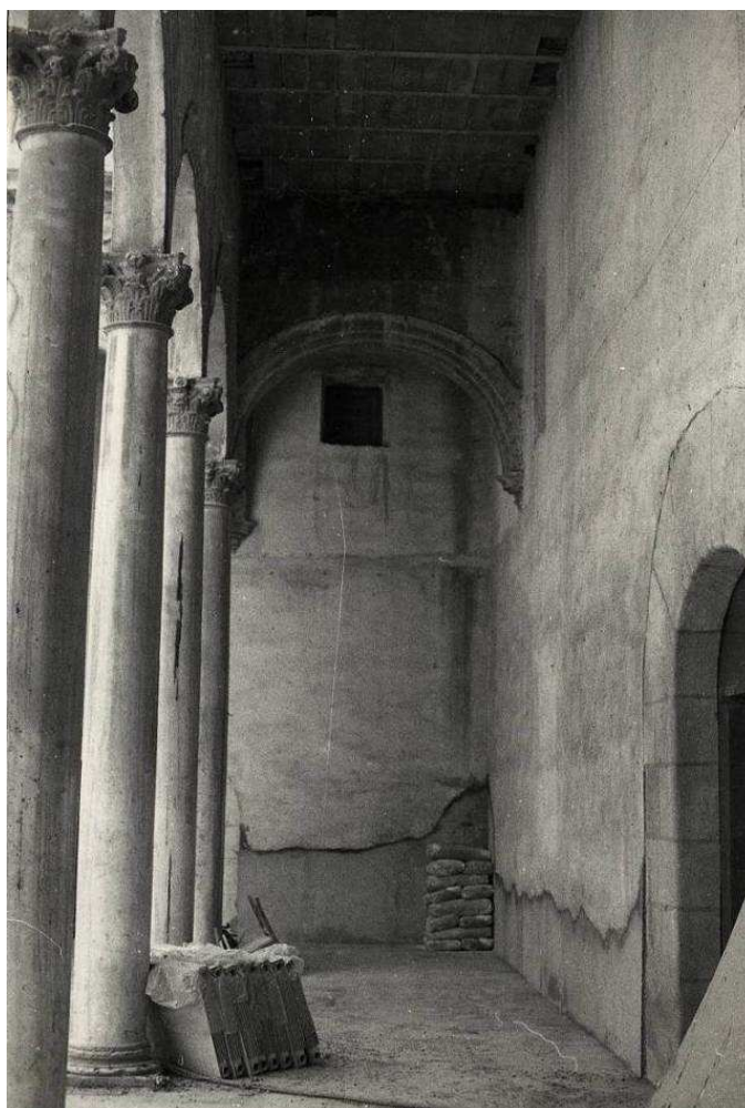
VISTA DEL PATIO DE LA CAPILLA EN EL TRANCURSO DE LAS OBRAS. (AGA.)
