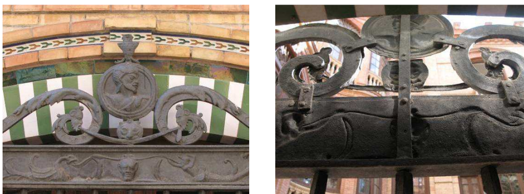
ANVERSO Y REVERSO DEL REMATE DE UNA DE LAS VENTANAS DE LA PORTERÍA HACIA EL JARDÍN
