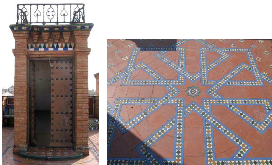
VISTA DEL CASTILLETE Y DEL SUELO DE LA TERRAZA
