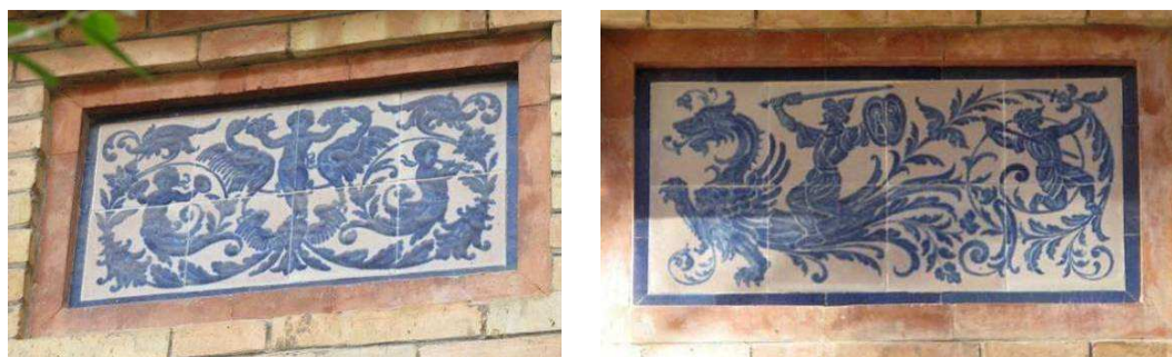
MOSAICOS SITUADOS EN LOS ANTEPECHOS DE LAS VENTANAS DEL DESPACHO
