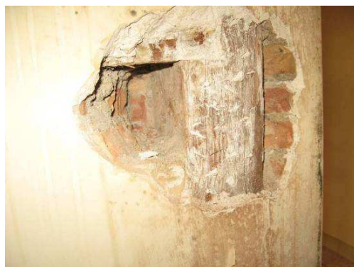
TRASDOSADO DE LOS PARAMENTOS DEL PATIO EN PLANTAS SEGUNDA Y PRIMERA. A LA IZQUIERDA PARAMENTO ORIGINAL PERDIDO DENTRO DE LA CÁMARA
