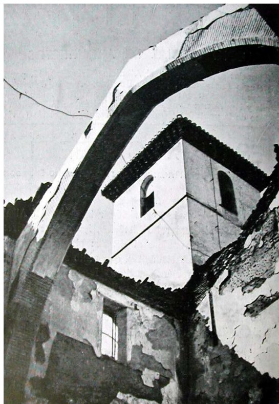
ASPECTO INTERIOR DE LA IGLESIA TRAS EL INCENDIO (1932) (PRIETO- MORENO, 1933)
