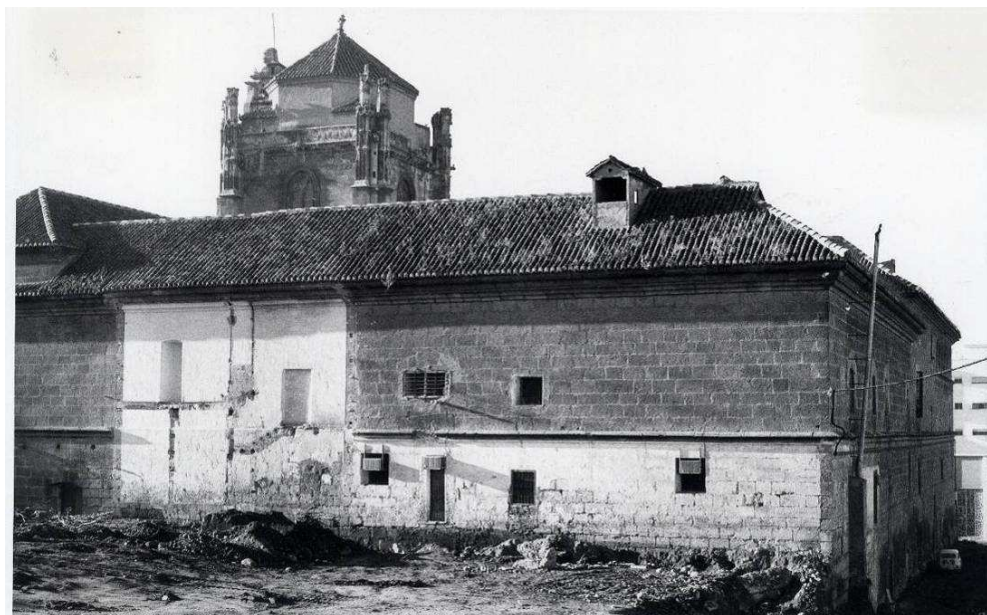
VISTA DE LA FACHADA ANTES DE LA INTERVENCIÓN. (AGA.)
