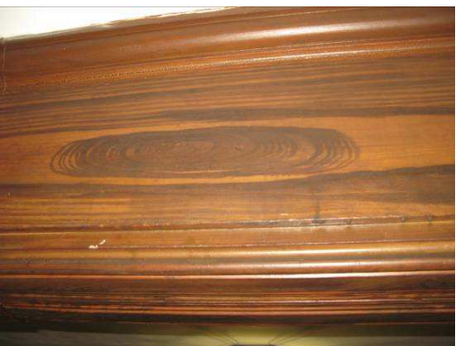
DECORACIÓN DE LAS FALSAS VIGAS DEL ZAGUÁN IMITANDO LAS VETAS DE LA MADERA
