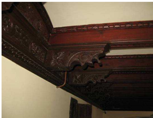
FORJADO DE VIGUETAS DE MADERA Y ENTREVIGADO CURVO EN EL COMEDOR DE PLANTA PRIMERA Y EN EL DESPACHO DE PLANTA BAJA
