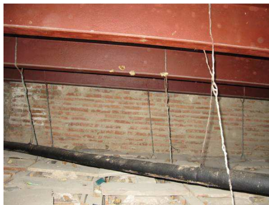
ALFARJE DECORATIVO SUSPENDIDO DE ESTRUCTURA METÁLICA EN EL PALACIO DE PÉREZ DE HERRASTI
