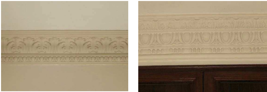
FRISO DE LA LOGIA EN PLANTA PRIMERA Y DEL DISTRIBUIDOR DE PLANTA SEGUNDA
