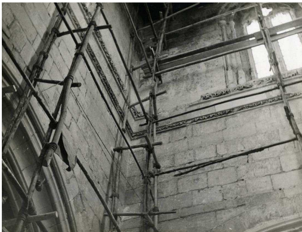
TRABAJOS DE RESTAURACIÓN DEL CIMBORRIO. (AGA.)
