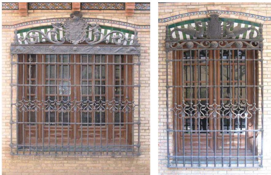
REJAS DE UNA DE LAS VENTANAS DEL DESPACHO Y DE UNA DE LAS VENTANAS DEL COMEDOR
