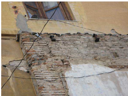
DETALLE DE LAS CABEZAS DE LAS VIGAS DEL CUERPO SOBRESALIENTE EN LA FACHADA. DETALLE DE LA FÁBRICA DE MAMPOSTERÍA Y LADRILLO DE LA FACHADA POSTERIOR.
