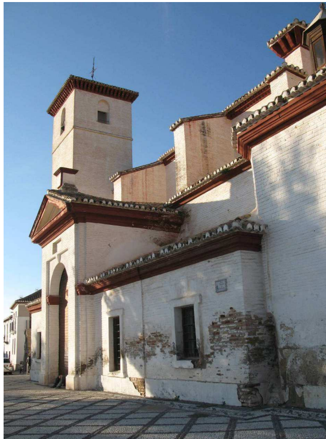
VISTA GENERAL DEL EDIFICIO DESDE LA PLAZA
