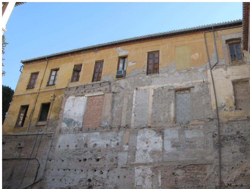
IMAGEN DEL EDIFICIO DE CONTRERAS, CON LA HUELLA DE LA CONEXIÓN VERTICAL DEMOLIDA
