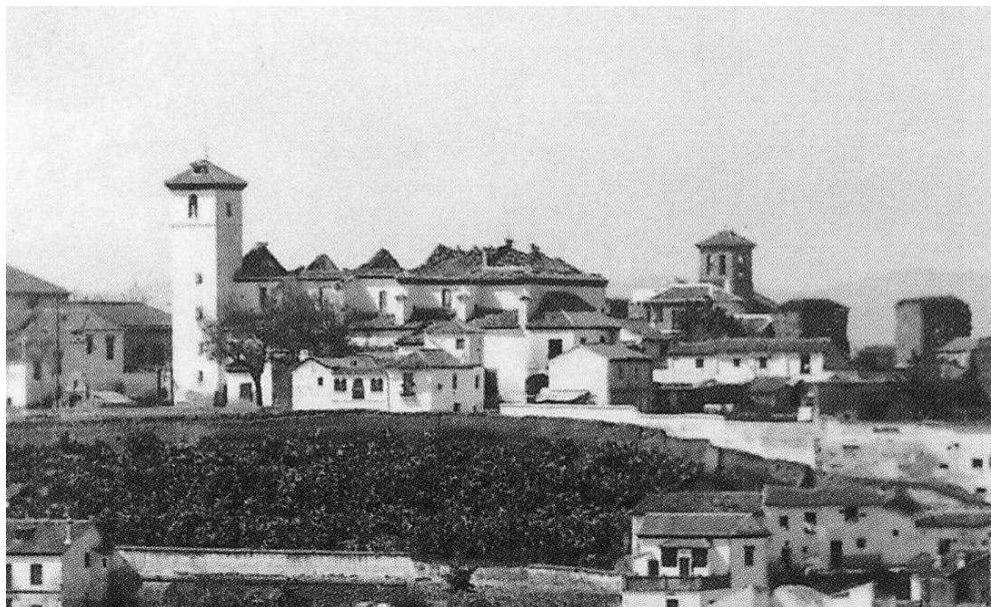
IMAGEN DE LA IGLESIA DESPUÉS DEL INCENDIO Y ANTES DEL DERRUMBE DE LA BÓVEDA (1932- 1935). (APJMBR)
