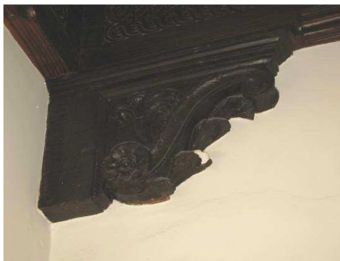
DETALLE DEL HUECO DE UNA ZAPATA DEL PATIO Y ROTURA EN UNA DE LAS ZAPATAS DEL ZAGUÁN
