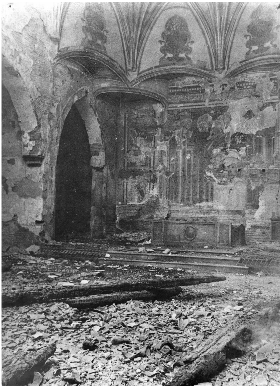
VISTA DE LA CAPILLA MAYOR TRAS EL INCENDIO (TORRES MOLINA?, 1932). (AHA.)
