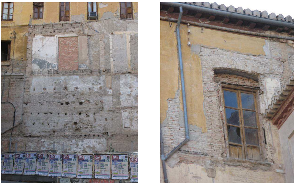
DETALLES DE LA FACHADA DEL EDIFICIO DE CONTRERAS
