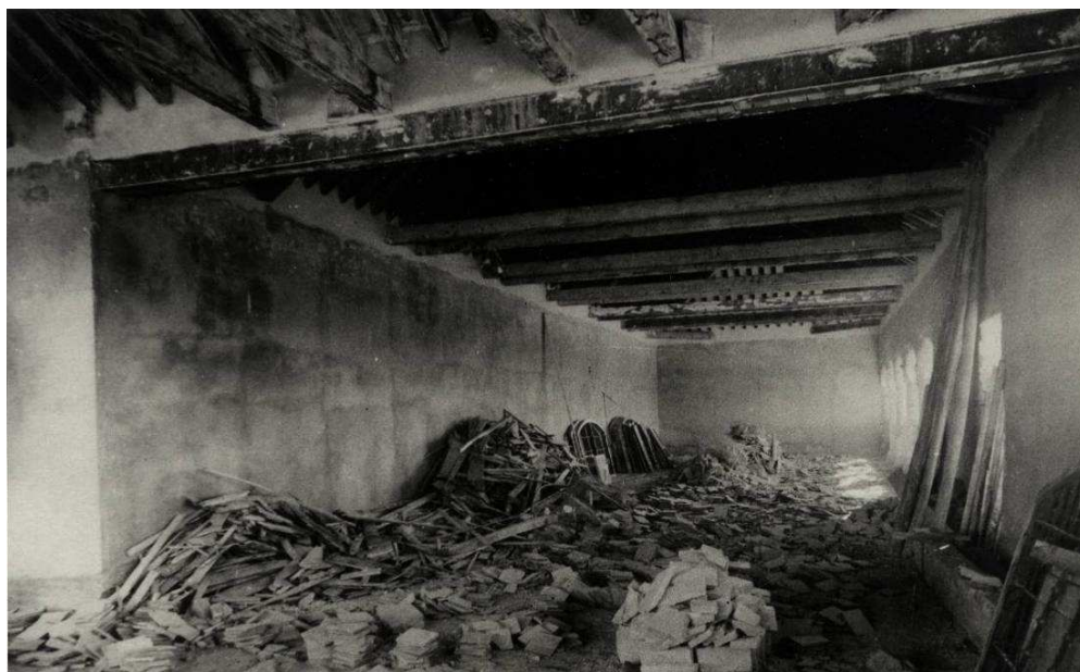
VISTA DE LA GALERÍA DE CONVALECIENTES EN EL TRANSCURSO DE LAS OBRAS. (AGA.)
