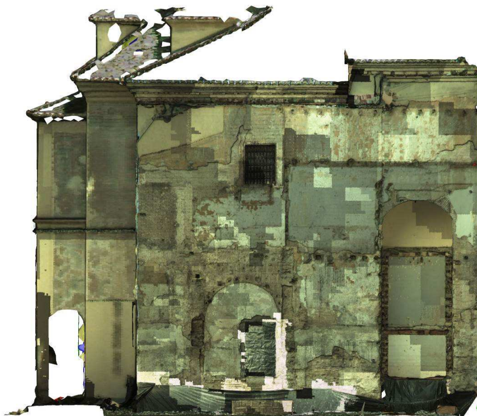
ORTOFOTOGRAFÍA OBTENIDA A PARTIR DE LA NUBE DE PUNTOS (GRAF: JUAN FCO. REINOSO, SMLAB. PROYECTO: FERNANDO ACALE)
