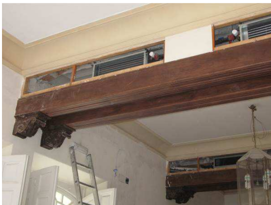
VIGAS SIN FUNCIÓN ESTRUCTURAL EN EL PALACIO DE LAJAROSA Y VIGA METÁLICA FORRADA CON MADERA EN EL PALACIO DE PÉREZ DE HERRASTI
