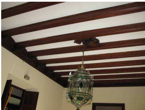
FORJADO DE VIGUETAS DE MADERA Y ENTREVIGADO CURVO EN EL COMEDOR DE PLANTA PRIMERA Y EN EL DESPACHO DE PLANTA BAJA
