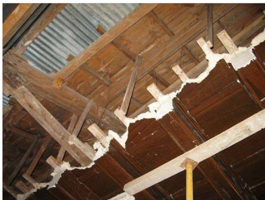
FALSO ALFARJE DE ESCAYOLA EN EL SALÓN PRINCIPAL DE LA PLANTA ALTA
