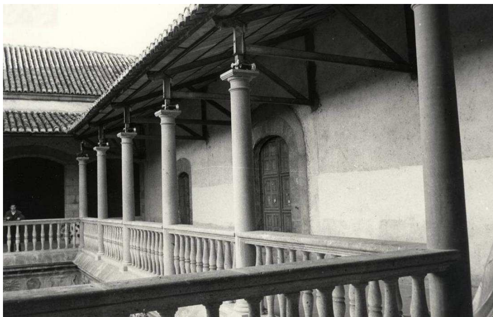
VISTA DE LA GALERÍA SUPERIOR ANTES DE LA INTERVENCIÓN. (AGA.)
