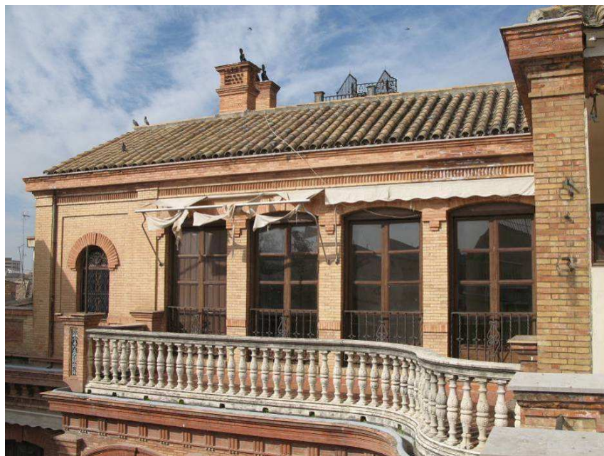
DETALLE DE LA PARTE DE LA FACHADA CORRESPONDIENTE A LA PLANTA TERCERA
