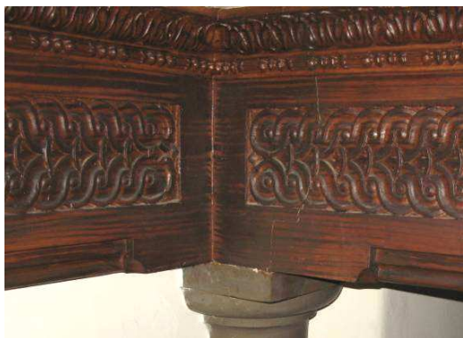
DECORACIÓN DE LAS FALSAS VIGAS DEL ZAGUÁN IMITANDO LAS VETAS DE LA MADERA
