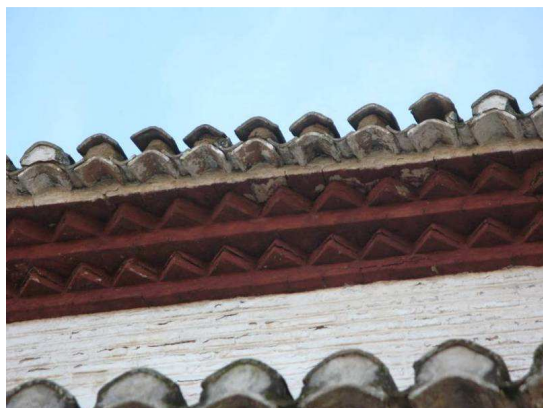
DIFERENTES TIPOLOGÍAS DE ALERO EN EL EDIFICIO
