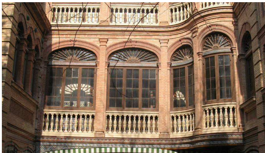
DETALLE DE LA PARTE DE LA FACHADA CORRESPONDIENTE A LA PLANTA PRIMERA
