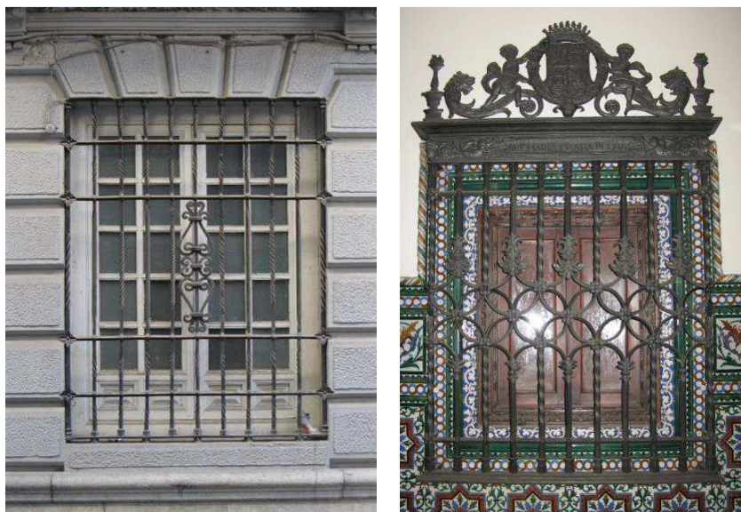
REJAS DE LAS VENTANAS DE LA FACHADA Y DE LA VENTANA DE LA PORTERÍA HACIA EL PORTAL
