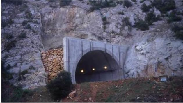
**Figura 12. Prolongación exterior de la bóveda del túnel. Fuente: Español, y otros (2008)**
