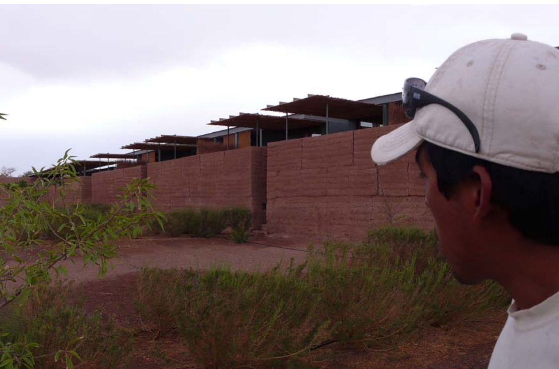
3.95 Recorrido de acceso alrededor del antiguo palo de amarre de los toros en el Hotel Tierra Atacama, San Pedro de Atacama, Chile. Fotografías del autor, 2011
