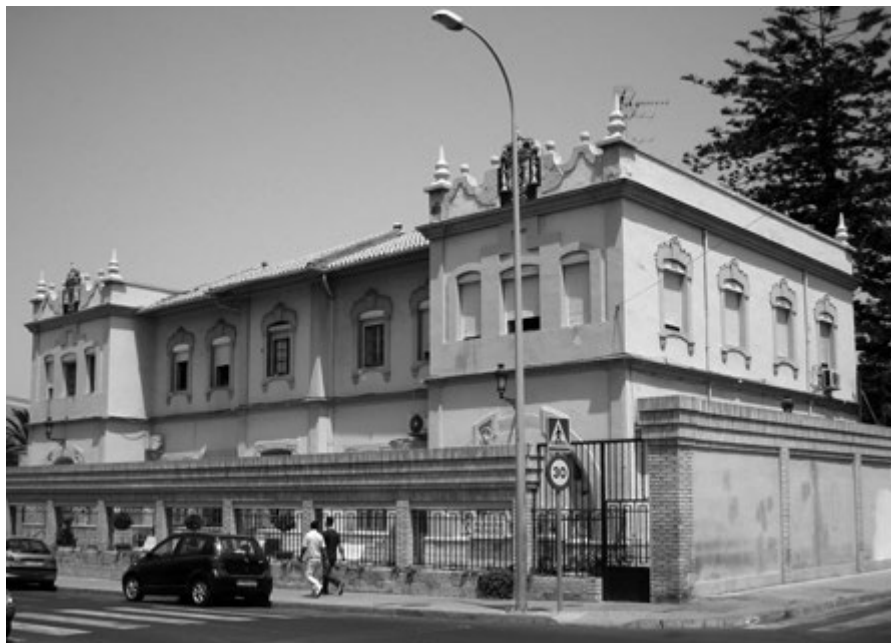
84. Centro Asistencial de Melilla. Fachada Principal, 2005. (AFM)
