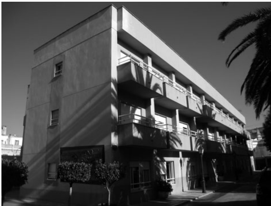
98. Pabellón de Ancianas. Fachada, 2014. (SGA)
