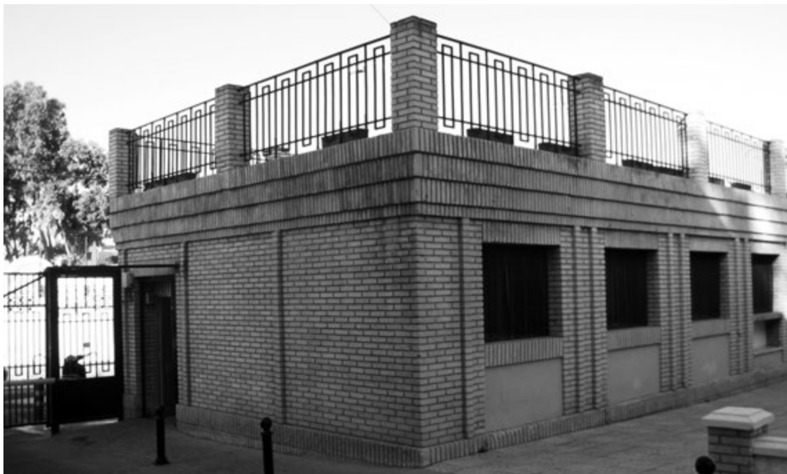
75. Cocina del Centro Asistencial. Fachada lateral, 2014. (SGA)
