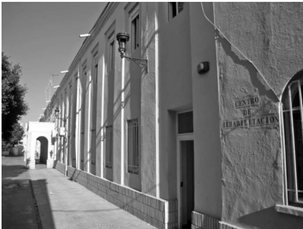
108. Centro de Rehabilitación. Fachada, 2014. (SGA)
