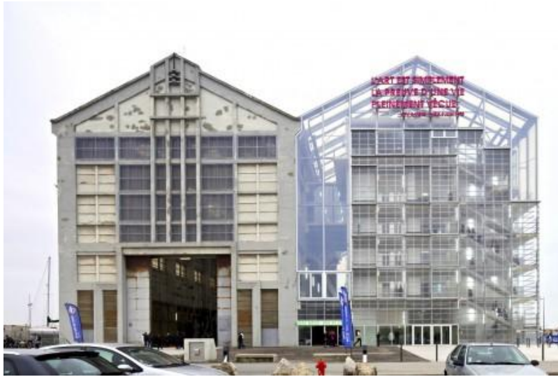
Imagen 23: Proyecto FRAC, Nord-Pas de Calais en Dunkerque, de I&V. 113
