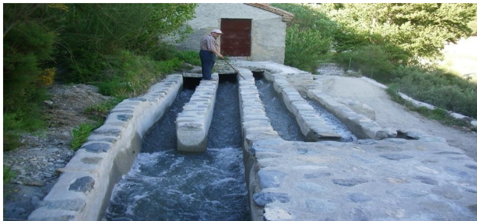
Ilustración 64: Primer partididor de la Acequia de Nigüelas, que divide el caudal en tres partes iguales, una de ellas (a la derecha de la foto) pertenece a Acequias y las otras dos partes son para Nigüelas y Dúrcal
