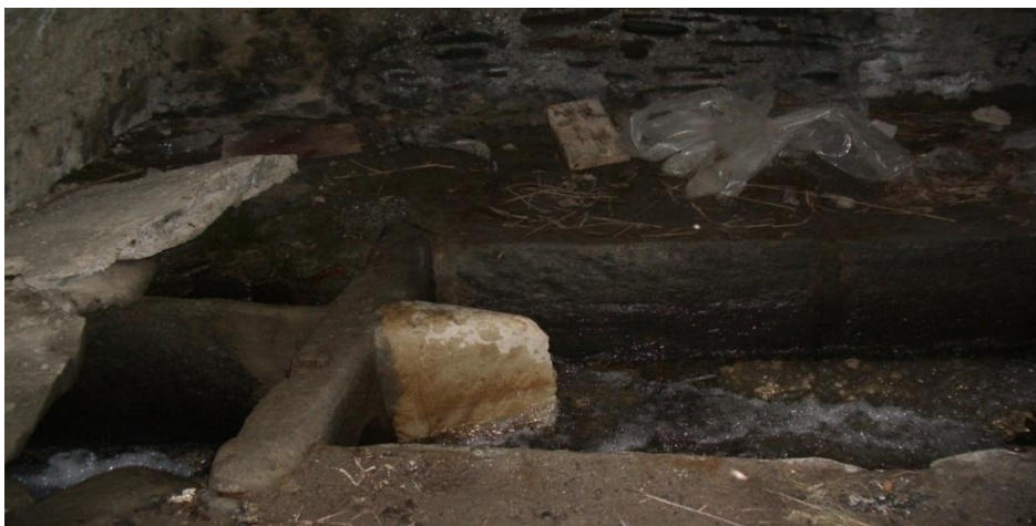
Ilustración 65: Partidor de Nigüelas donde se divide en dos mitades el caudal de la acequia, una parte para Dúrcal y la otra para Nigüelas
