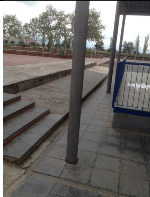
Imagen 6. Zona de acceso a espacios exteriores. Columnas y escalones sin protección.
