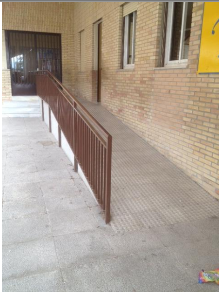
Imagen 33. Zona de acceso a espacios interiores.
