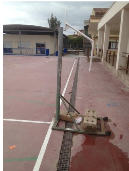
Imagen 8. Poste para vóley y tenis. Con contrapesos y situados en el borde de la pista, sin guardar distancia de seguridad. Riesgo importante.
