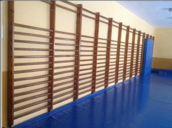
Imagen 42. Espalderas. Espalderas en buen estado.
