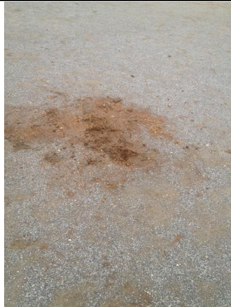
Imagen 24. Pavimento del campo de fútbol.
