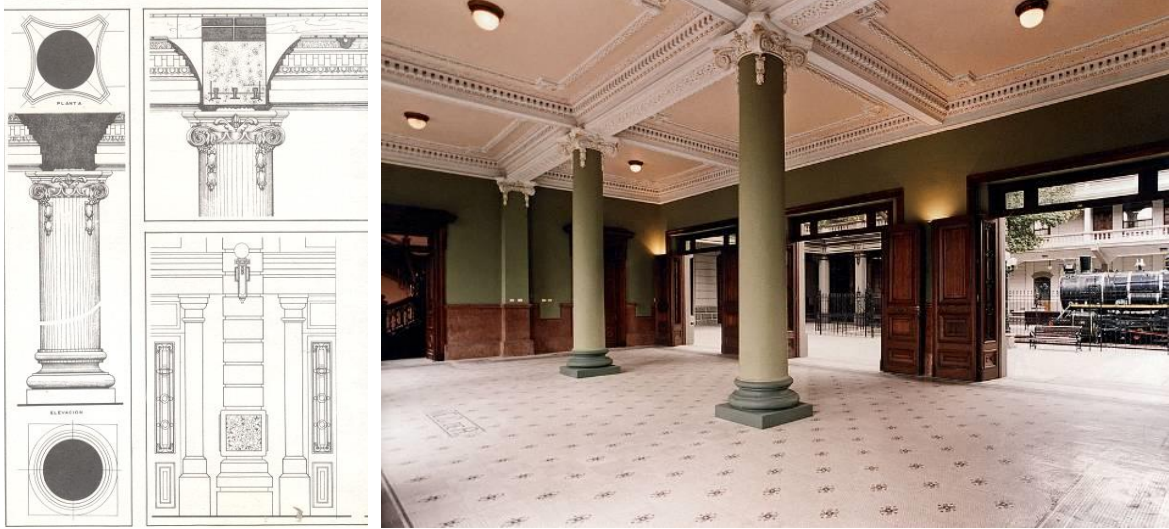
Figura No. 4-38: (Izq.) Sección y vista del capitel, columna central de la sala de tiquetes. (Der.) Sala principal de tiquetes y de espera restaurada. Fuente: Archivo Fundación Ferrocarril d Antioquia
