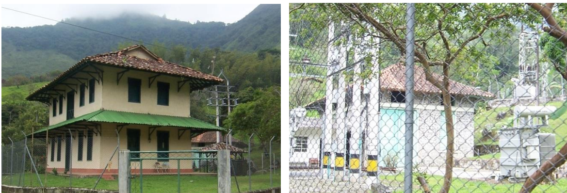
Figura No. 4-72: Izq.) Casa de ingenieros (Der.) Central Hidroeléctrica en el sitio de La Quebra de la Estación 'El Limón'. Fotografía del autor
