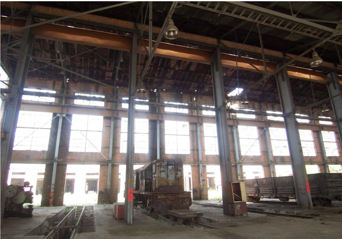
Figura No. 4-67: Cobertizo Taller de Diésel en Talleres de Bello. Fotografía del autor
