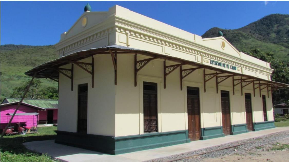
Figura No. 4-53: Estación 'El Limón'. Restauración Julio de 2014. Fotografía del autor
