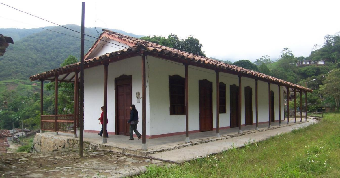
Figura No. 4-50: Estación Santiago restaurada, 2011. Fotografía del autor
