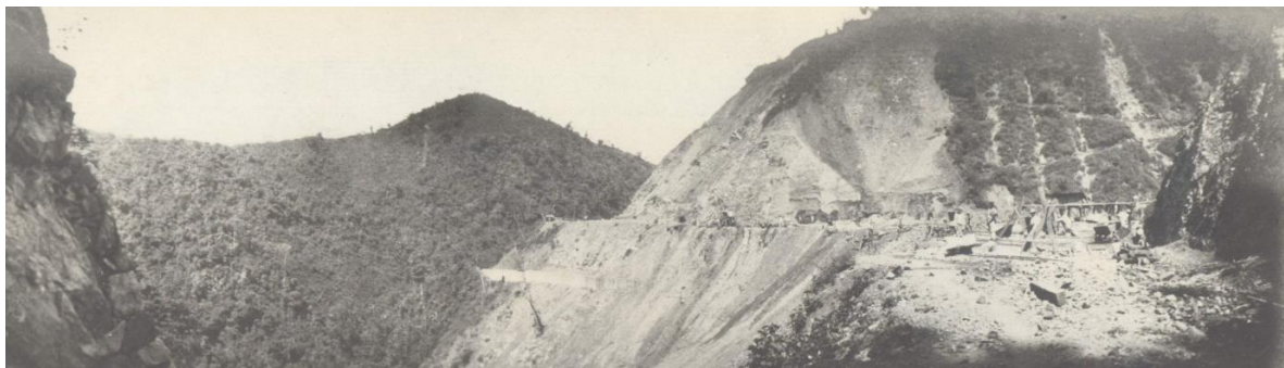
Figura No. 4-77: Registro de las obras de construcción del ferrocarril en la difícil topografía Antioqueña. Foto de archivo Fundación Ferrocarril de Antioquia
