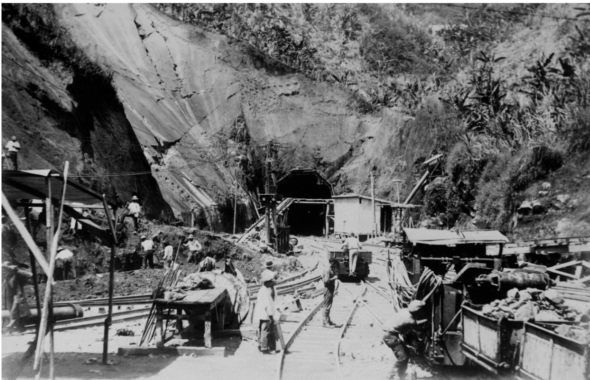
Figura No. 3-4: Fase de construcción del Túnel de la Quebra –Boca El limón 1926. Fuente: Archivo Fotográfico Biblioteca Pública Piloto. Ref.: BPP-F-003-0713.
