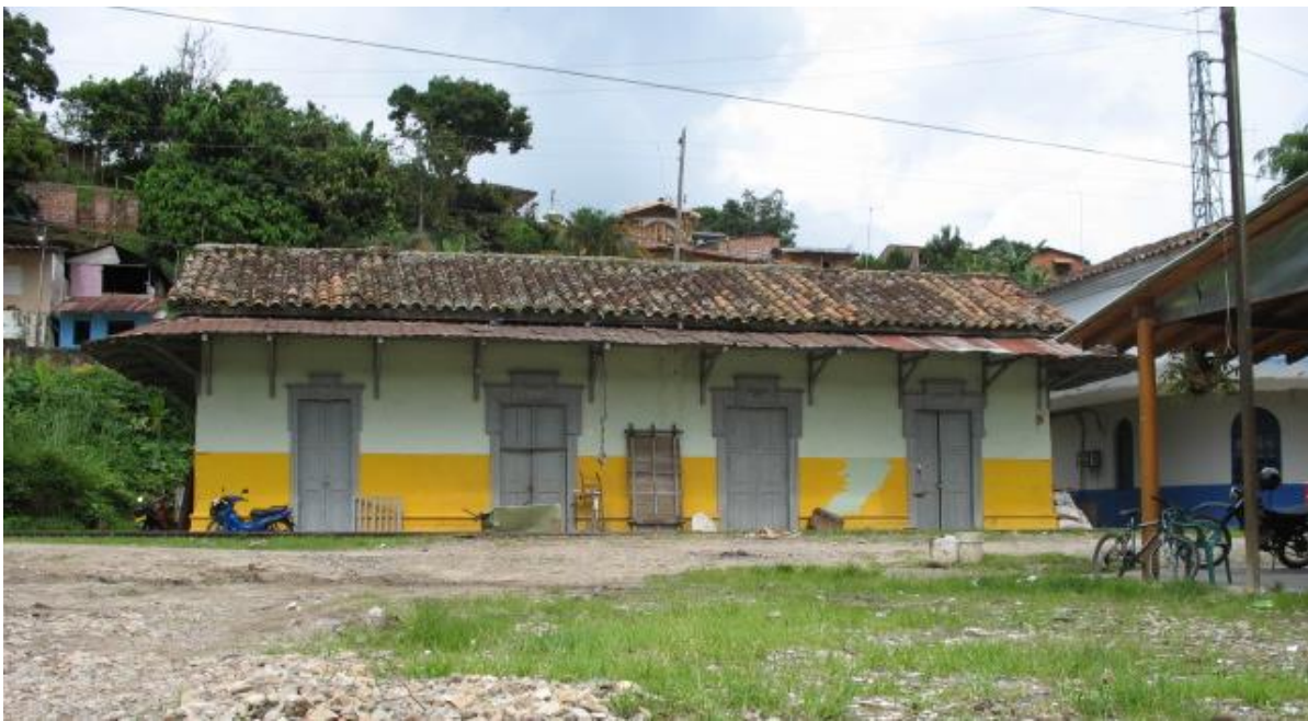
Figura No. 4-57: Estación San José del Nus en su estado actual. Fotografía del autor
