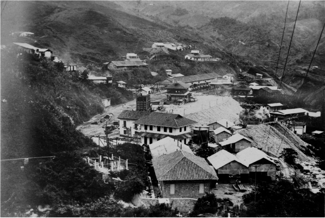
Figura No. 4-52: Paraje de El Limón durante las obras de construcción del Túnel de la Queiebra. Al fondo la Estación y bodegas Fuente: Archivo Fotográfico Biblioteca Pública Piloto. Ref.: BPP-F-003-0713
