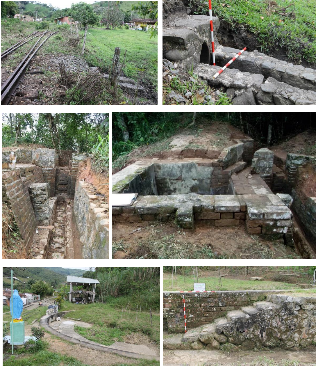
Figura No. 4-7: Imágenes superior: Acueducto para el conjunto y. Estación Botero, construido en piedra, ladrillo y argamasa; imágenes línea media: Sistema de conducción y drenaje de aguas superficiales Estación Botero; Imágenes línea inferior: Mesa giratoria para cambio de sentido de las locomotoras en Estación Santiago. Fotografías Carlos Orozco. 35
