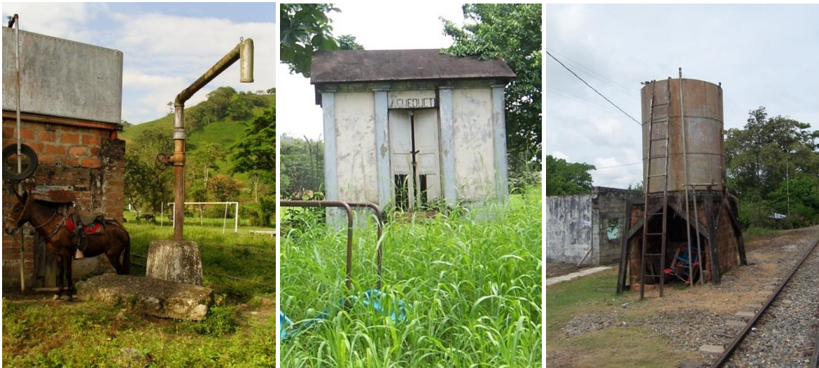
Figura No. 3-12: Sistemas de acueducto y almacenamiento de agua para provisión vaporinas. 2012. Fotografías del autor.
