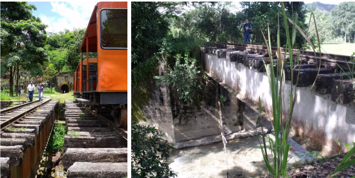
Figura No. 4-6: Puentes de vigas simples en alma llena y superficie de rodadura superior para luces cortas. Izq. Estación Santiago. Der. Trayecto Botero-Porce. Fotografía Paulo C. Gómez M.
