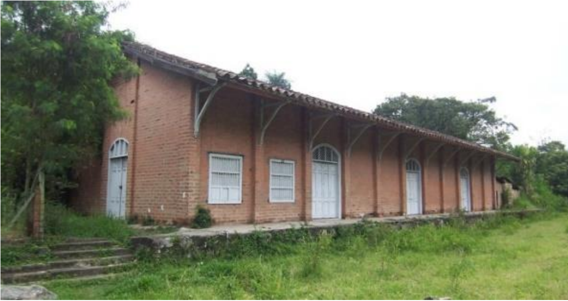
Figura No. 4-45: Estación Hatillo. Estado actual. Fotografía del autor
