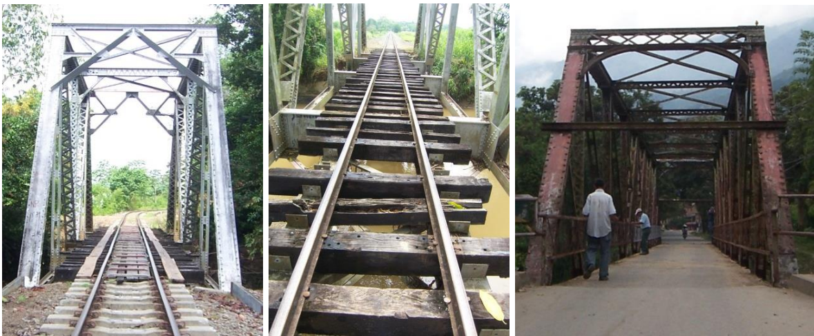
Figura No. 4-79: Puentes en estructura metálica del ferrocarril. Foto del autor
