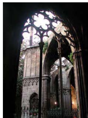
Img. 11. 35 Catedral de Barcelona. Interior del Claustro. Vista del patio a través de un arco ojival. Foto: google.
