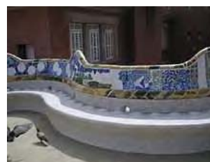
Img. 15. 74 Banco de trencadís en el parque Güel, realizado por el arquitecto modernista catalán Josep Maria Jujol i Gibert (1879-1949) en colaboración con Gaudí. Fuente: Google.
