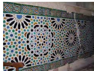
Img. 11. 24 Formas geométricas Derivadas del octógono y las subdivisiones de la cir- cunferencia circunscrita al mismo en 16 partes. Alham- bra. Granada.
