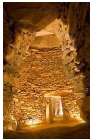
Img. 12. 76 Dolmen de El Romeral, Antequera, Málaga. 1800 a.C. Cámara en falsa bóveda. Foto: Google.
