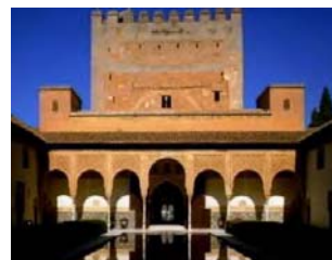
Img. 11. 6 Patio de los Arrayanes, fachada norte. Alhambra. Granada.
