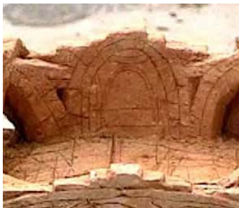
Detalle de [5.51] interior del muro este.
