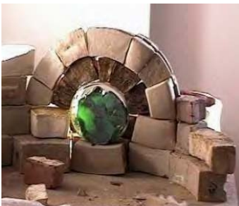
Img. 5. 17 1999 06 Construcción dovélica y muestrario. Pueden verse dovelas de primera y segunda generación y vidrio reciclado verde.
