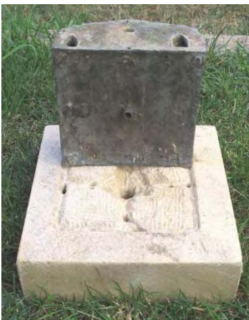
Img. 7. 10 2000 07. El Castillete, detalle de fontaneria por la cara inferior.
