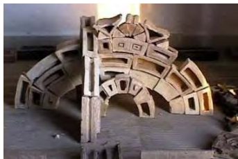
Img. 5. 55 1999 07 Construcción dovélica, efímera, primer plano frontal Arquitectura muestrario.
