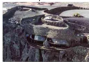
Img. 14. 56 Cesar Manrique. Mirador del Río . 1973. Lanzarote. En parte excavado, y cubierto con dos cúpulas enterradas. Con piedra loca se mimetiza sobre un acantilado. Lo hizo en colaboración con el arquitecto Fernando Higueras, entre otros. Fuente: cesarmanrique.com
