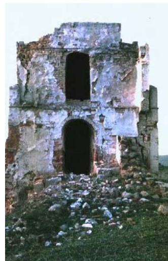
Img.4. 24 Tejar de Toribica. Vista de las dos supuestas puertas para cargar las piezas a cocer, zona de carga. Foto: A. Salas.
