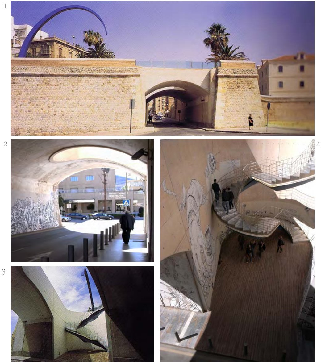
Fig. 4.2.7 Imágenes del estado actual de la rasante superior e inferior de la calle Gisbert.
