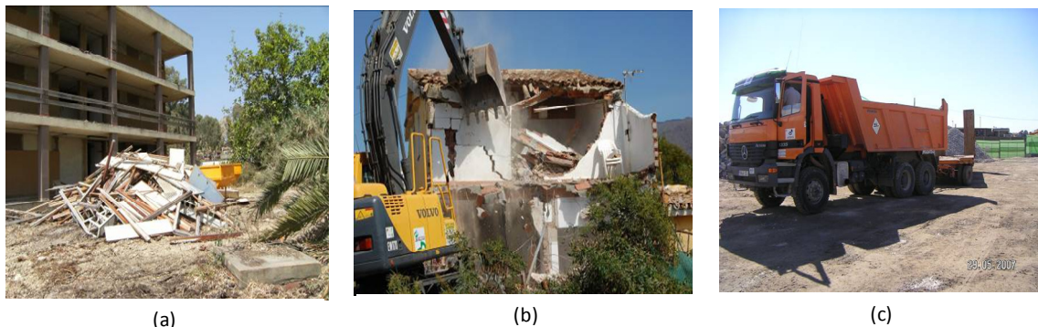
Figura 6. Proceso de demolición de la obra de construcción
