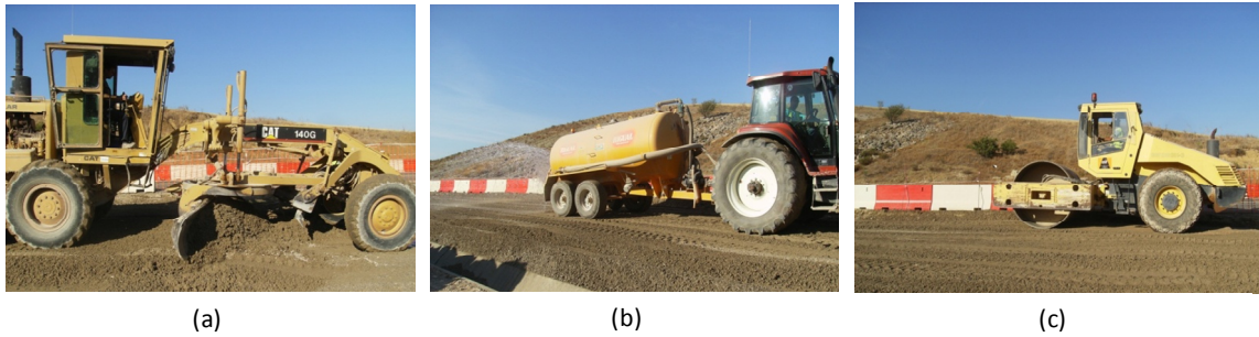
Figura 14. Equipos utilizados en la puesta en obra
