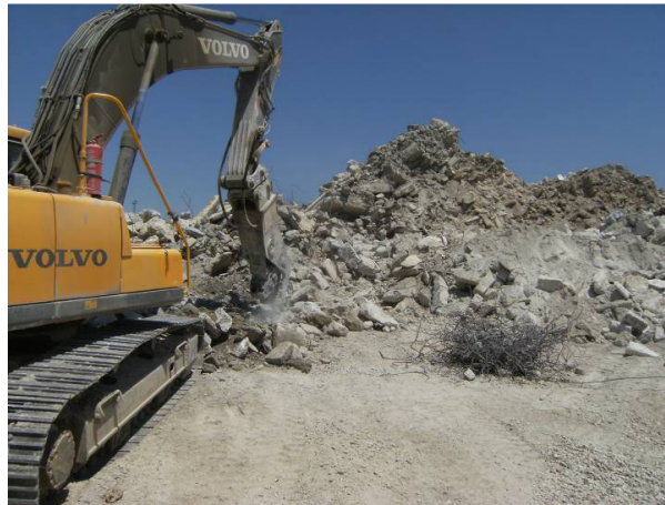
Figura 8. Retroexcavadora de cadenas con pinza hidráulica.
