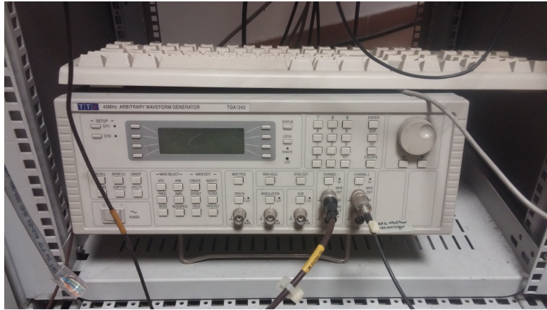
Figura 9: Detalle del generador de funciones visible en la parte inferior del Rack de la imagen de la izquierda en la figura 6.
