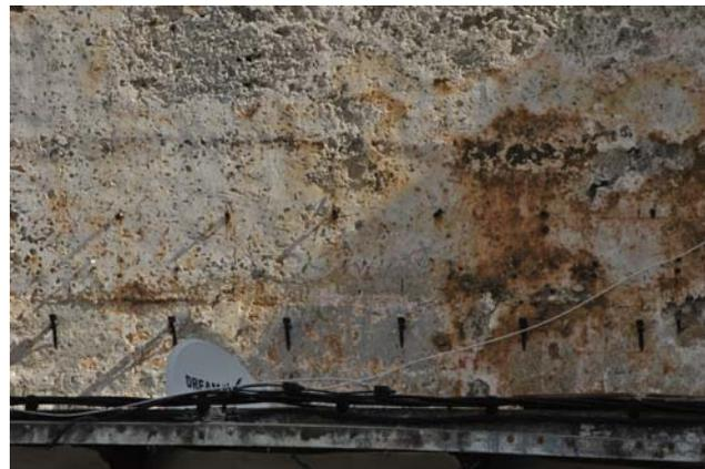
Figs. 22 y 23; Lienzo de muralla a estudiado. Almenas como de doble pezón como elemento decorativo. Detalle del revestimiento y su estado de conservación; suciedad, picado, elementos no originales adheridos al muro -bridas, antenas y cables, entre otros-.
