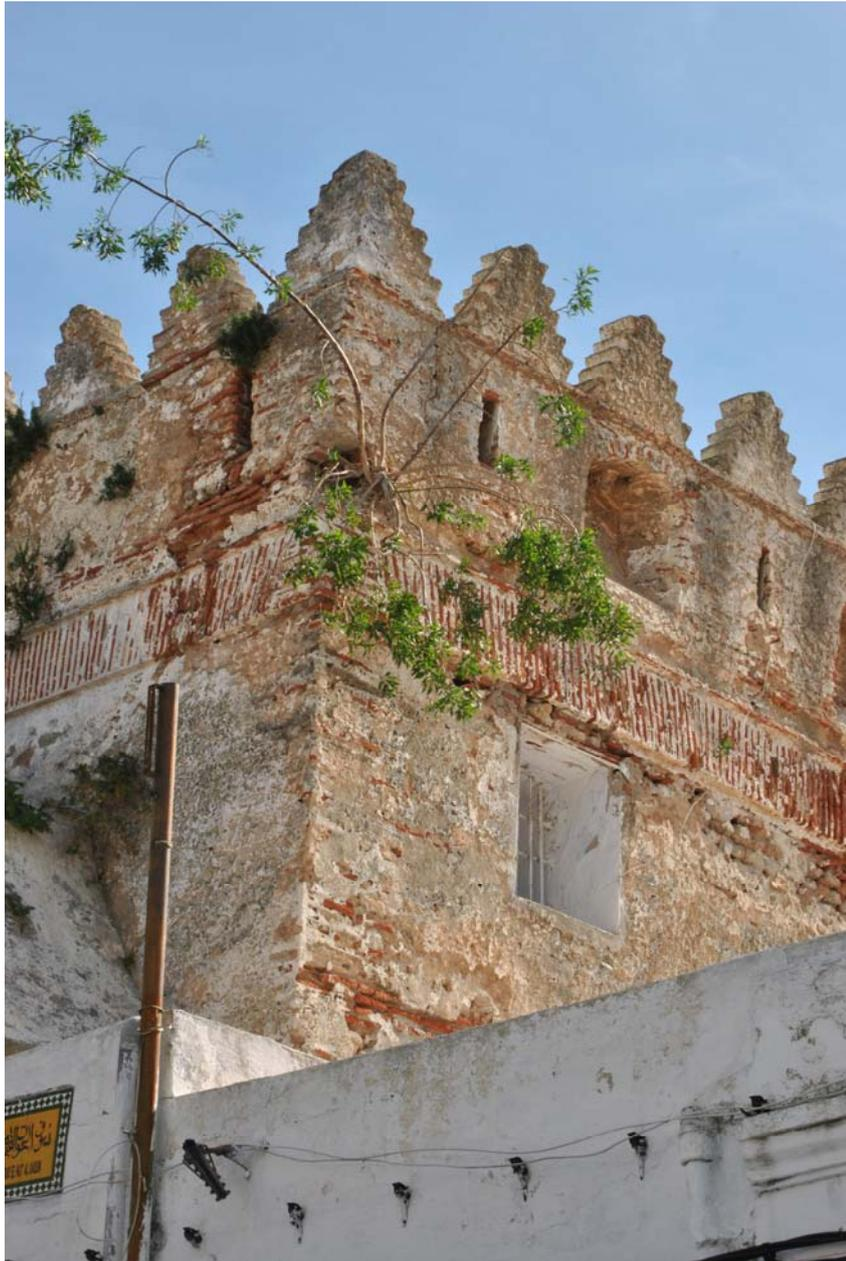
Figs. 24; Torre Sur de planta rectangular, fotografía general que recoge los materiales y fábricas empleados en su construcción. En la parte inferior izquierda de la imagen, la construcción de comercios adheridos a los muros y las torres históricas realizados con materiales actuales, perjudiciales para el Bien Inmueble.
