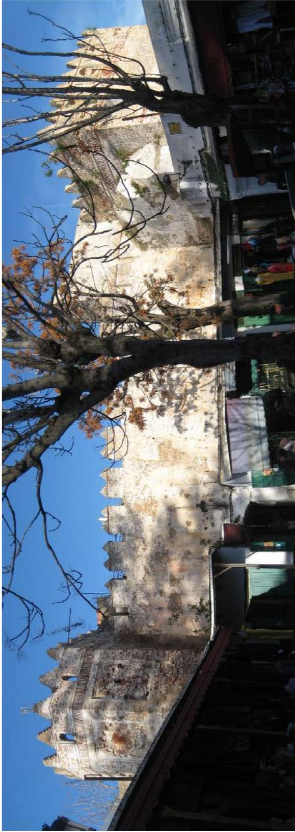
Fig. 11; Imagen panorámica en la que puede apreciarse en su totalidad el área de muralla y las torres sometidas a estudio. La zona baja de la arquitectura queda cegada por la presencia de comercios adosados, situación que impide el acceso visual y palpable al arranque de torres y muralla hasta una altura aproximada de 3,24 m. Por este motivo no se pueden valorar alteraciones y patologías de toda esta superficie.
