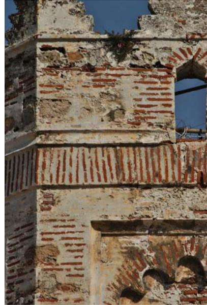
Figs. 20 y 21; Torre central de planta poligonal y detalle. Ladrillo macizo, mampostería careada, y sillar de travertino en las esquinas y arco lobulado.
