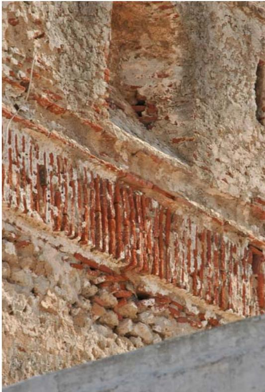
Figs. 25 y 26; Torre Sur, detalle, materiales y fábrica; mampostería, cintas de ladrillo macizo, almenas de cola de milano y ventanas ciegas.
