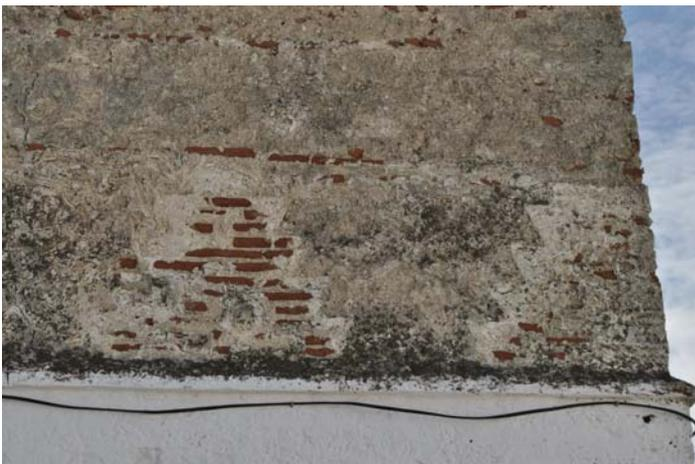
Fig. 34; Detalle de las almenas invadidas por el añadido de tabiques no originales.
