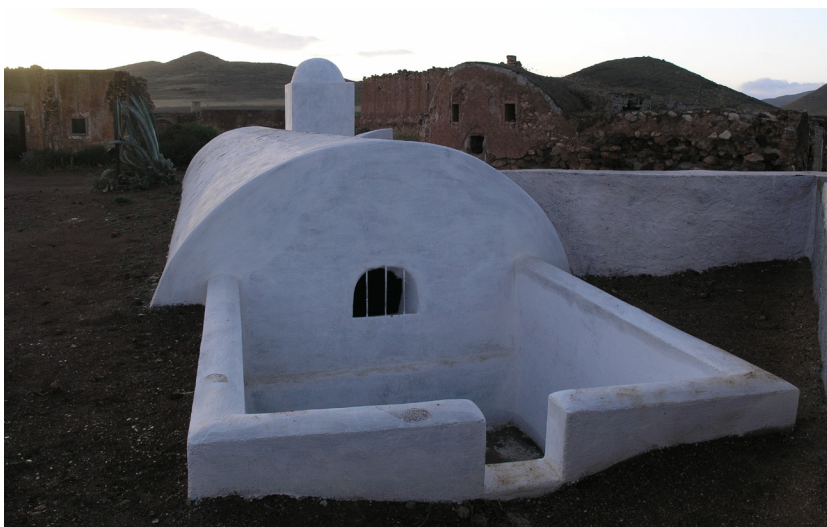
Aljibe-abrevadero. Cortijo del Fraile (Níjar, Almería).
