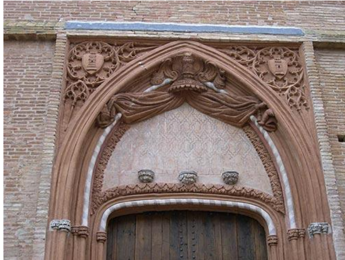
Ilustración 10. San Félix. Detalle de la portada gótica, con los agramilados diseñados por Chueca. Estado actual (foto de la autora).
