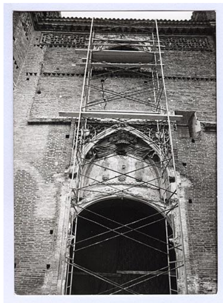
Ilustración 08. La misma fachada durante el proceso de restauración, con el descubrimiento de la portada gótica original, en mayo 1972. Archivo de la empresa Tricás.
