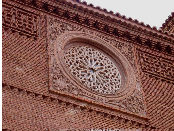
Link 19. San Félix. Detalle del rosetón colocado por Chueca Goitia. Estado actual (foto de la autora).
