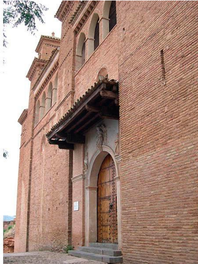
Link 11. Fachada norte de la iglesia de San Félix, con el nuevo ingreso diseñado por Chueca Goitia en 1961, estado actual (foto de la autora).
