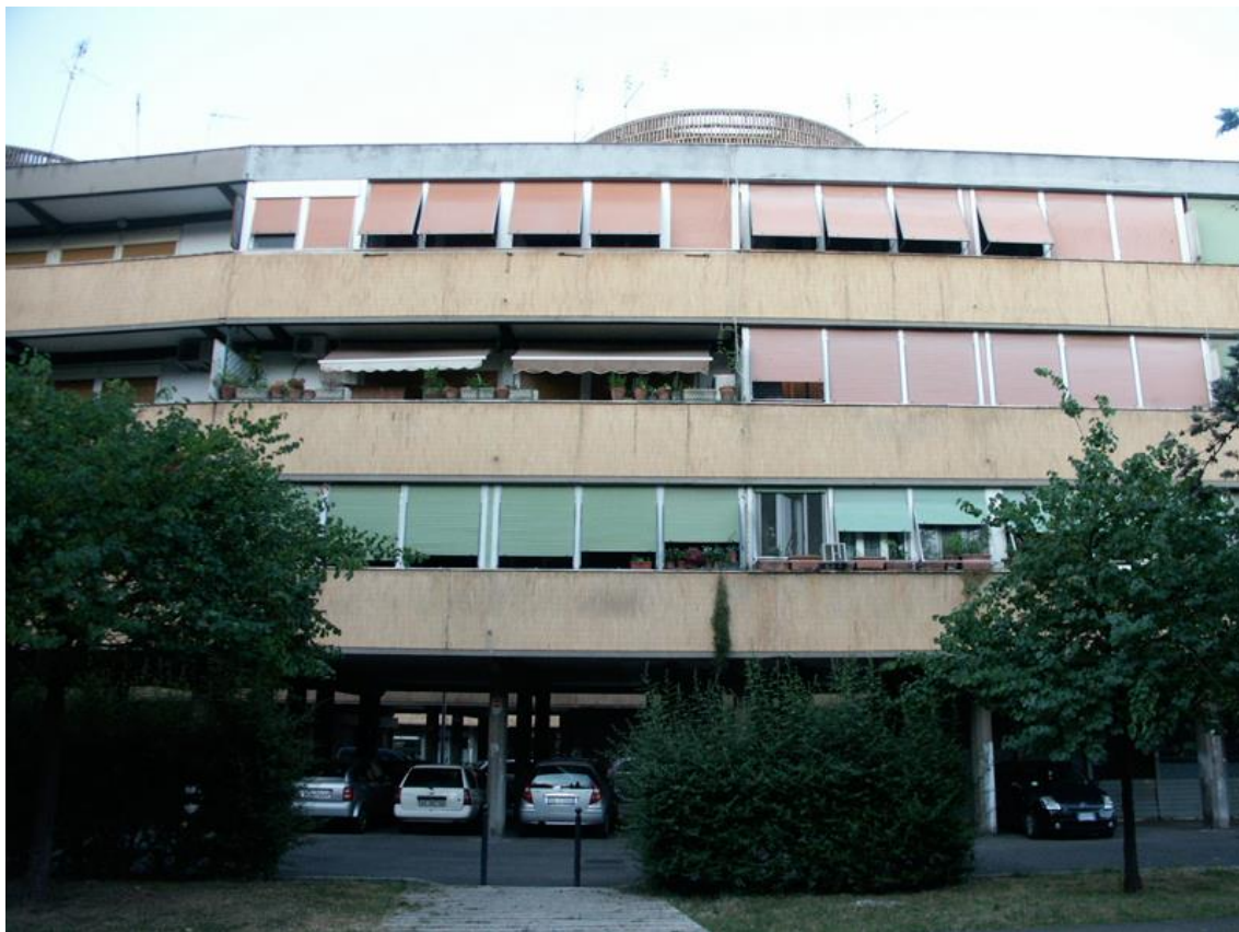
Ilustración 09. Roma, Villaggio Olimpico, edifici del tipo 'A': modifiche all'involucro edilizio.
