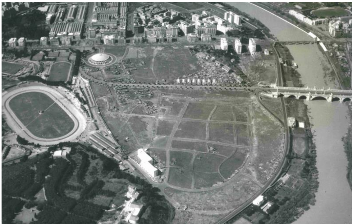
Ilustración 03. Roma, Villaggio Olimpico, veduta aerea dell'area destinata alla realizzazione del quartiere prima della costruzione, 1958. Archivio Coni.
