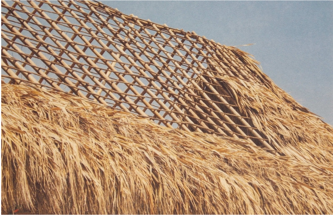
Ilustración 46 Cubierta de palma amarga y sistema de hueva de perro para sostener la palma de tradición indígena. Savia Caribe. Inventario Botánico de La Región. Tomo I. Medellín: Argos. 2012.
