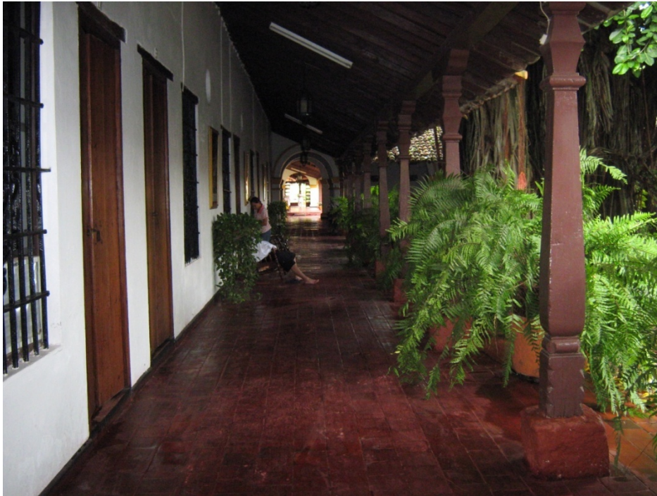
Ilustración 90 Imagen del sistema de pie derechos de la casa de Don Germán y Ribón y Doña Manuela, hoy Hostal Doña Manuela en Santa Cruz de Mompox. Archivo de Lucía Victoria Franco Ossa
