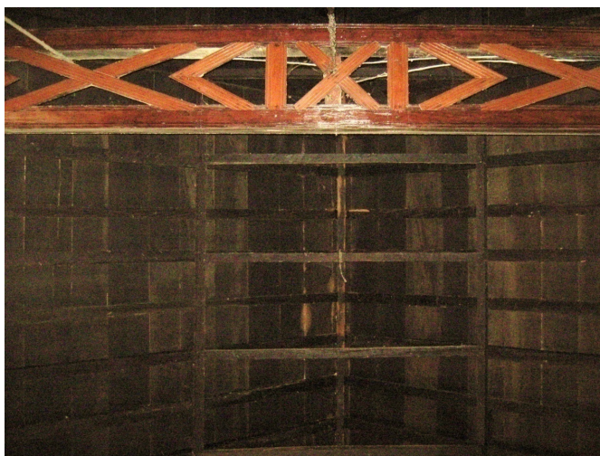
Ilustración 89 Sistema de cubierta con tirantes, En Santa Cruz de Mompox. Archivo de Lucía Victoria Franco Ossa
