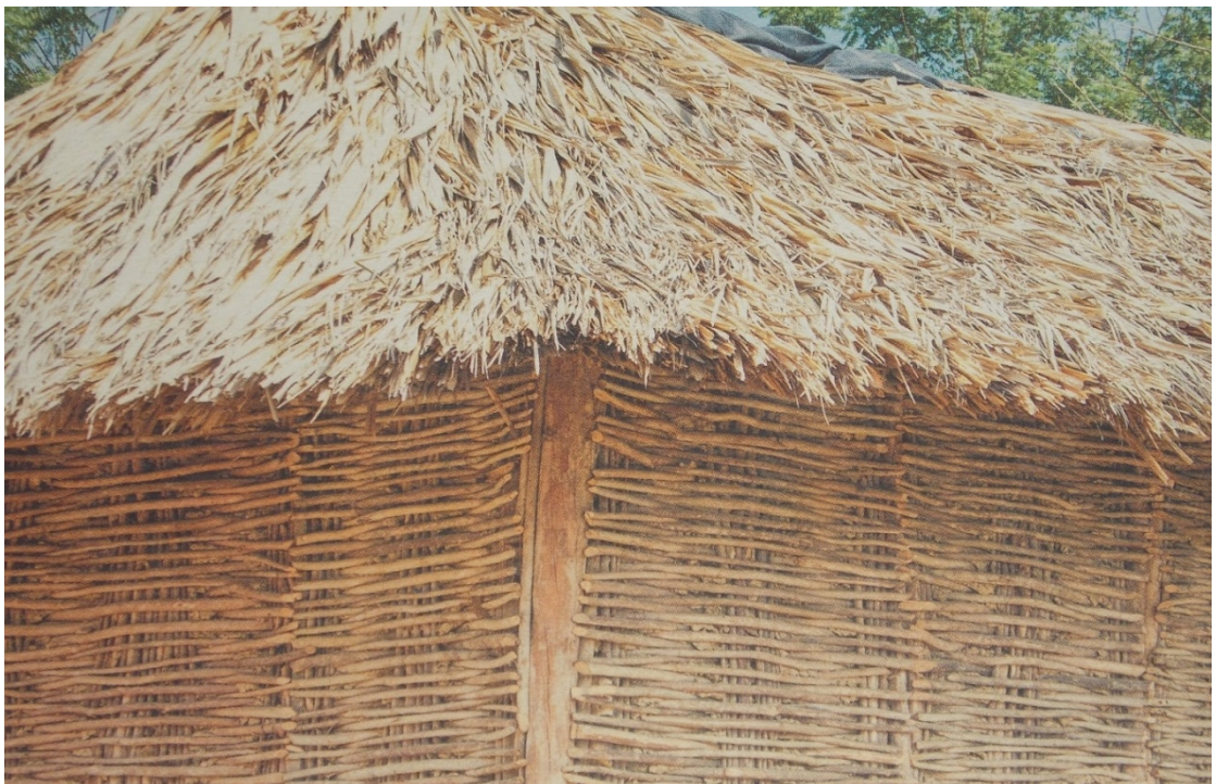
Ilustración 47 Muros de mimbre de madera. Savia Caribe. Inventario Botánico de La Región. Tomo I. Medellín: Argos. 2012.
