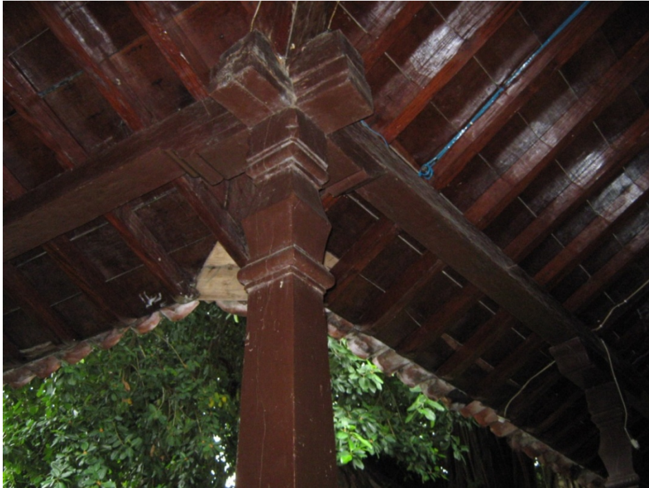
Ilustración 91 Sistema de pie derechos de cubierta de los corredores, Santa Cruz de Mompox. Archivo de Lucía Victoria Franco Ossa
