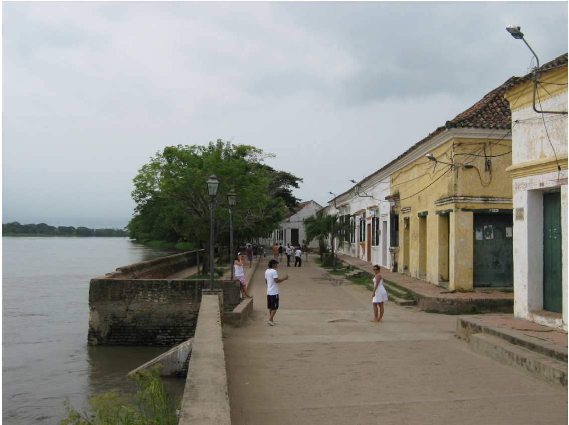
Ilustración 95 Albarrada o pretil de ladrillo a manera de malecón y alameda construida en 1803. Santa Cruz de Mompox. Archivo de Lucía Victoria Franco Ossa
