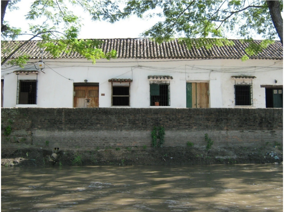
Ilustración 94 Muro o Albarrada de la Calle del río de Santa Cruz de Mompox. Archivo de Lucía Victoria Franco Ossa
