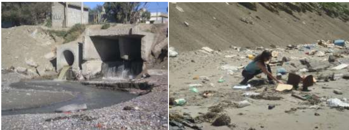
Imagen 1. Desagüe de efluente sin tratar
