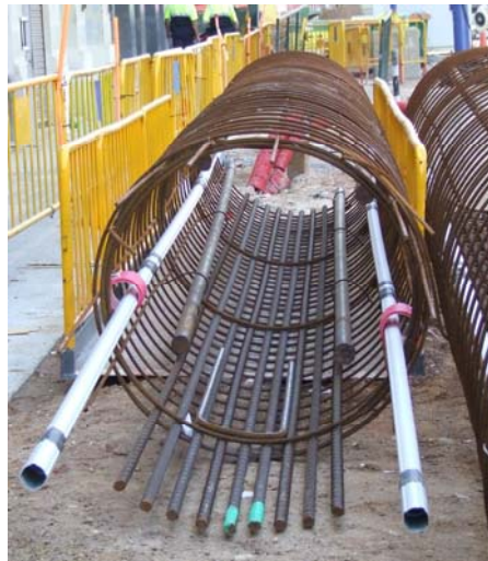
Fig. 5.6. Pilote con armadura asimétrica empleado en el tramo Sants- La Sagrera
