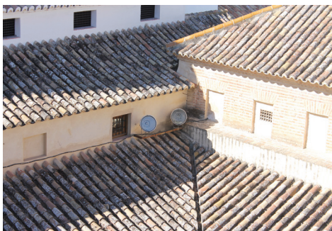
Proyectores que causan deslumbramiento
