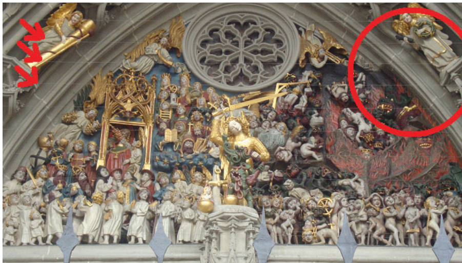
Ejemplo de red de sedales de nylon para evitar la degradación que provocan las aves en el tímpano de la Catedral de Berna, Suiza.
