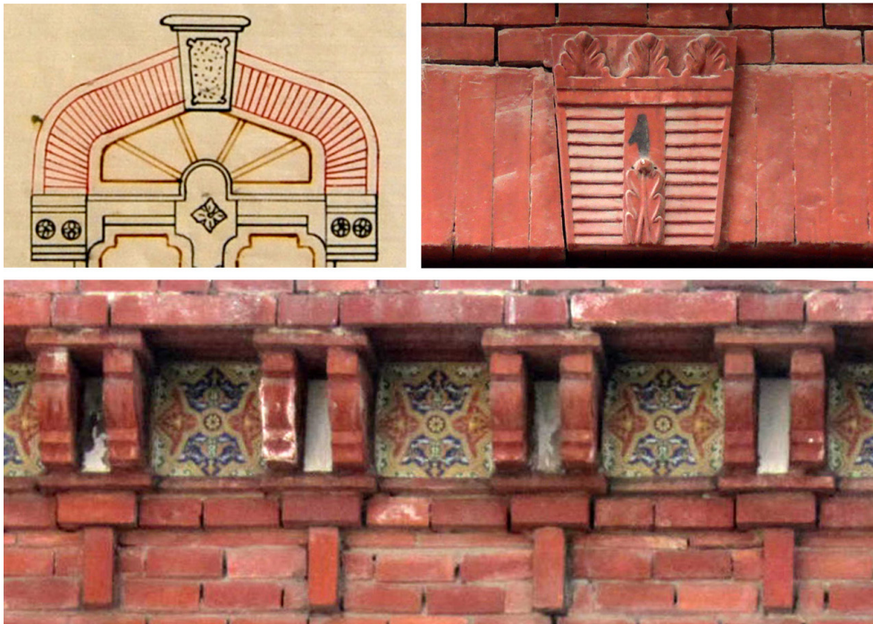
Figura 6. Superior izquierda: detalle del arco del Proyecto original del Laboratorio Municipal, del arquitecto Francisco Ferriol (1909). Superior derecha: fotografía del estado actual detalle de la clave y de las contraclaves de la casa de Augusto Millán, del arquitecto Segundo Vilorio (1914). Inferior: alero de ladrillos aplantillados. Casa de Miguel Hernández, del arquitecto Gregorio Pérez Arribas (1908).
