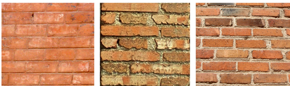
Figura 4. Aparejos de ladrillos ordinarios, con la traba más cuidada y las juntas más estrechas en edificios residenciales que en los industriales. Izquierda: aparejo a tizón , Casa de Matilde Merchán, del arquitecto Segundo Vitoria (1894). Central: aparejo belga , Fábrica de harinas Isidoro Rubio, del arquitecto Gregorio Pérez Arribas (1917). Derecha: aparejo a tizón , Matadero Municipal, de los arquitectos Enrique Crespo y Francisco Hernanz (1929).
