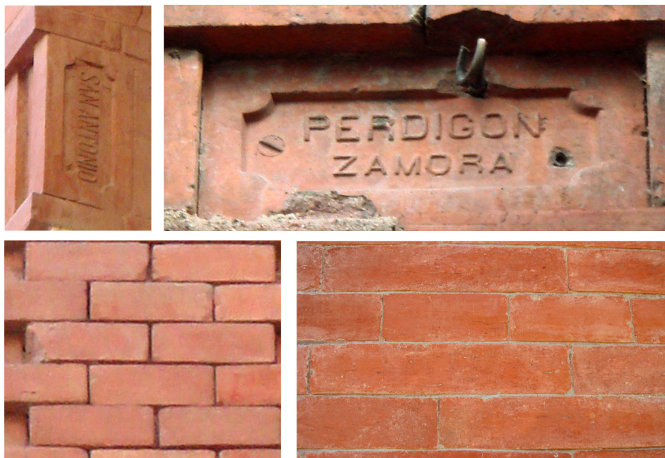
Figura 5. Superior: ladrillos fabricados en la Tejera de San Antonio, en El Perdígón (Zamora). Izquierda: jamba de un vano de un edificio del arquitecto Francisco Ferriol (hacia 1910). Derecha: En imposta de un edificio del arquitecto Segundo Viloría (hacia 1910). Inferior izquierda: aparejo con ladrillo fino con junta a hueso u oculta, Casa de José Cid del arquitecto Segundo Viloría (1902). Inferior derecha: aparejo con ladrillo fino y junta enrasada, Laboratorio Municipal del arquitecto Francisco Ferriol (1909).
