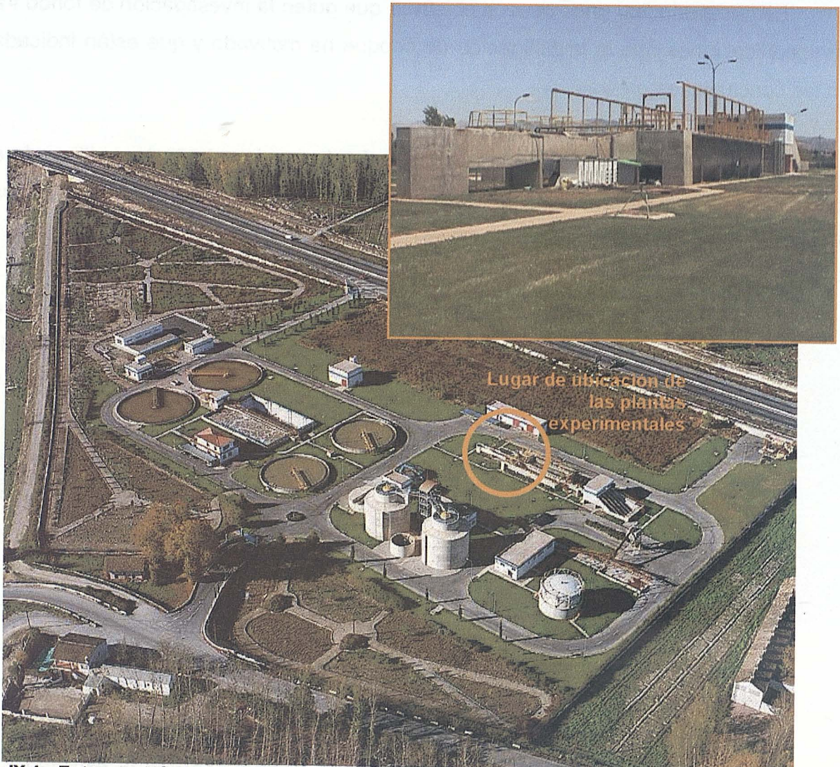
Fig.IX.1.- Foto panorámica de la EDAR Sur de Granada (Puente de Los Vados). Se indica el punto de ubicación de las plantas piloto y se adjunta foto ampliada de lugar de ubicación.
