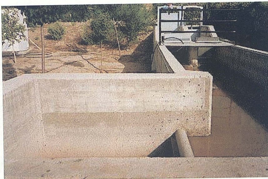
Fig.VI.3.-Desarenador-desengrasador de la ED de Villanueva de las Torres.
