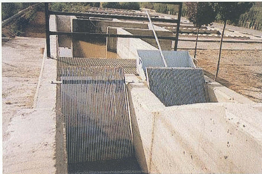
Fig.VI.2.- Pretratamiento: Rejas de finos y desarenador-desengrasador de la ED de Villanueva de las Torres
