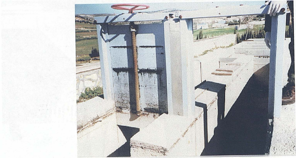
Fig.VI.14.- Desarenador de la ED de Piñar.
