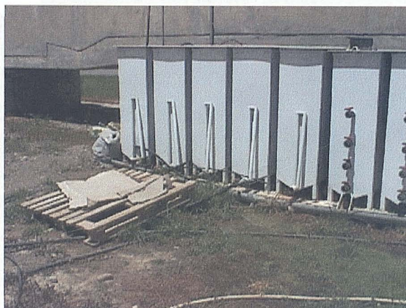
Fig.VIII.6.-Vista de los sifones dispuestos para salida de agua de los lechos de turba. Esto posibilita el trabajo por inundación
