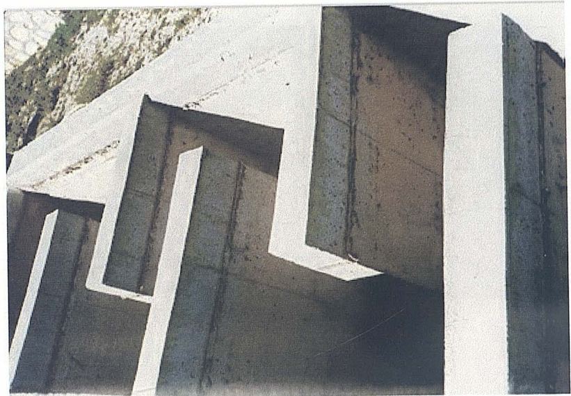
Fig.VI.15.- Desengrasador de la ED de Piñar.
