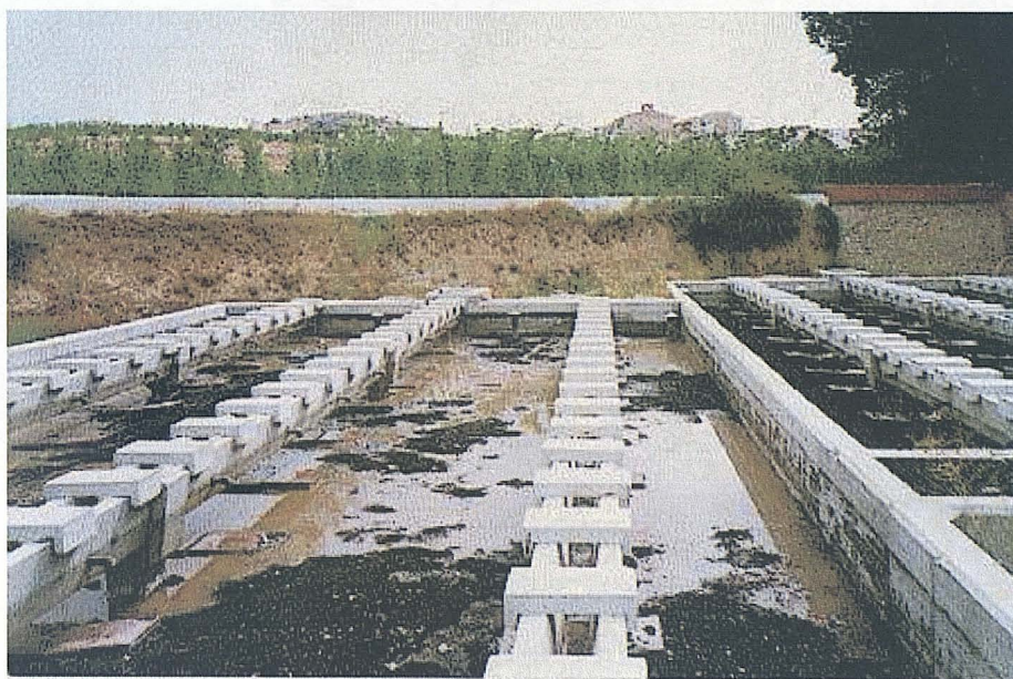
Fig.VI.21.- Lecho de turba en funcionamiento de la ED de Jayena.
