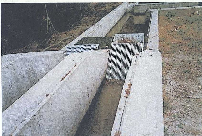
Fig.VI.19.- Pretratamiento: Reja de finos y desarenador, de la ED de Jayena.
