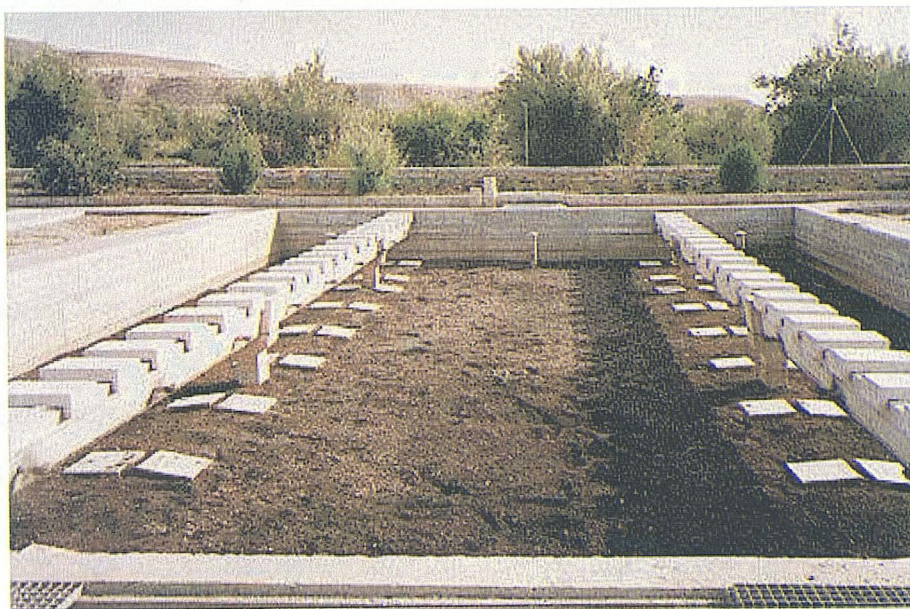
Fig.VI.6.-Lecho de turba preparado para entrar en funcionamiento. Se ha eliminado la costra de fango y se ha volteado la turba de la ED de Villanueva de las Torres.
