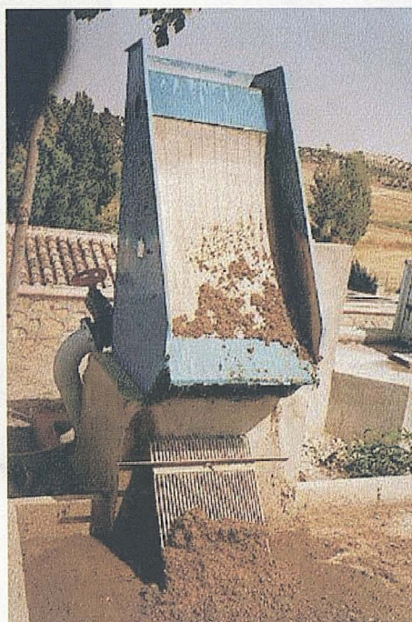
Fig.VI.13.- Tamiz estático de la ED de Piñar.
