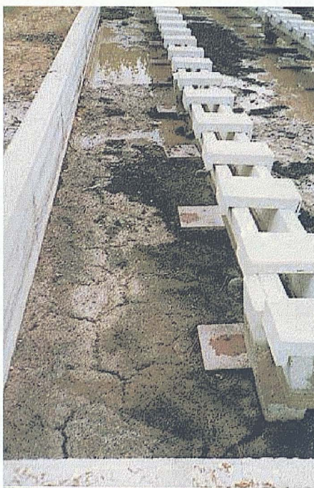
Fig.VI.23.- Lecho de turba en fase de secado en la ED de Jayena.
