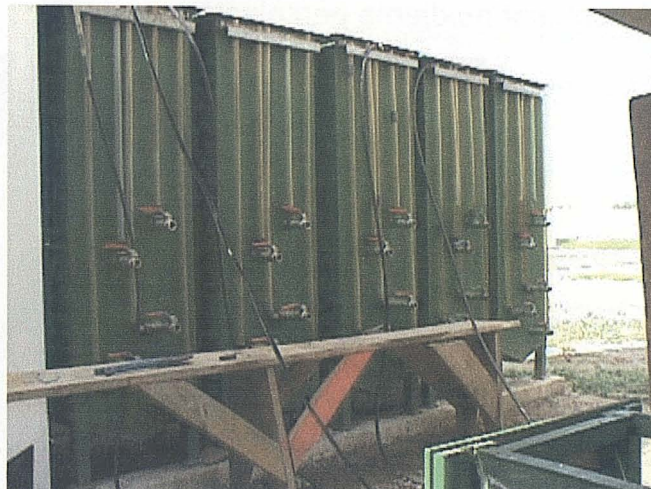
Fig.VIII.4.-Piezómetros instalados en los laterales de las plantas piloto. Están hechos en metacrilato y se dispone de válvulas para su limpieza.
