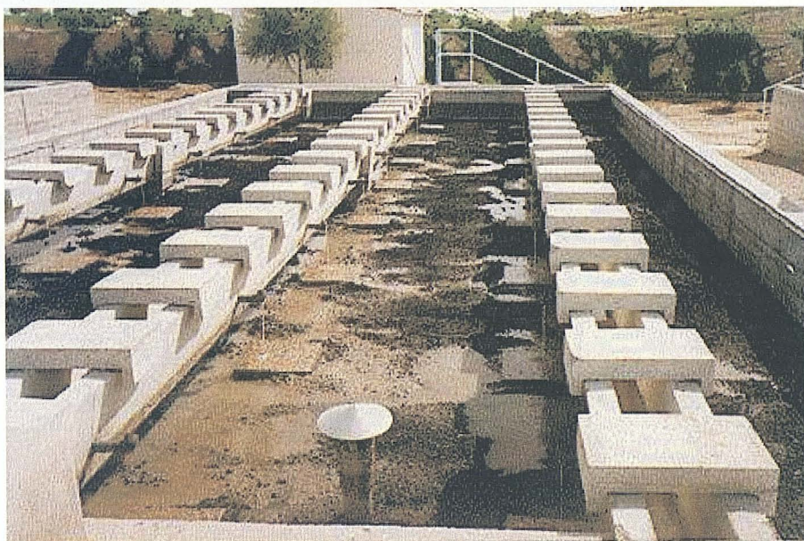
Fig.VI.10.- Lecho de turba de la ED de Torrecardela: En fase de funcionamiento.
