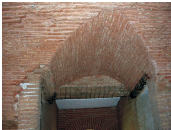
Fig. 6. Luneto del área abovedada de la Qubba Mayor.
