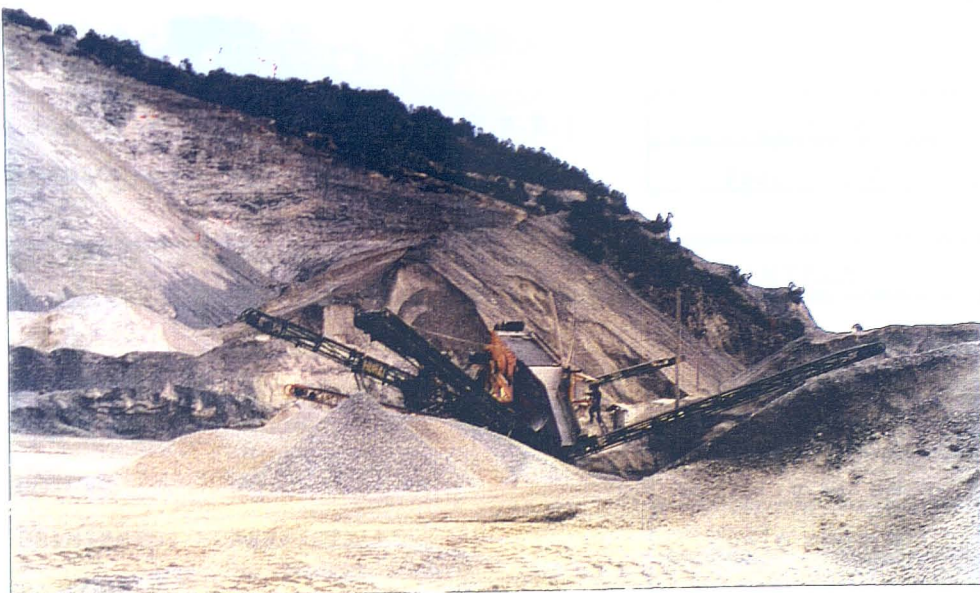
Foto 2.- Frentes de explotación nº 3 y 4 y equipo principal.
