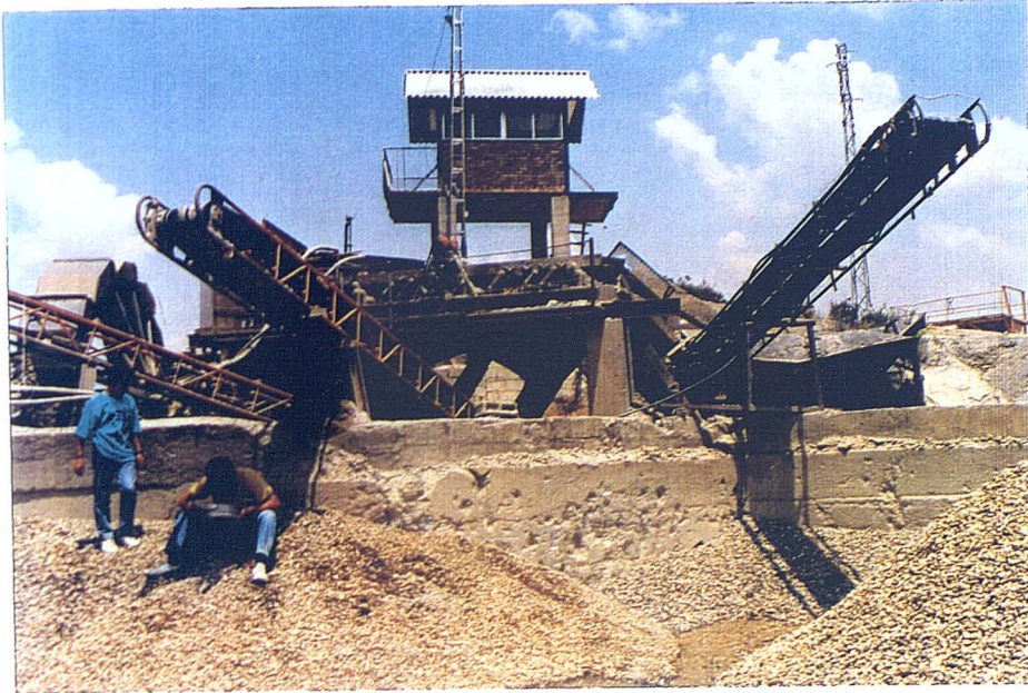
Figura 3.1. Vista del equipo principal, con tolva suministrada por pala, cinta transportadora, cribas y cintas de salida.
