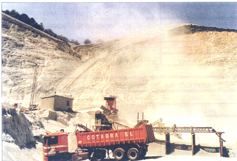
Foto 2.- Vista del frente de explotación y del equipo.
