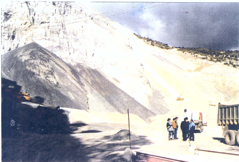
Foto 1.- Vista del frente de explotación y acopios previos.
