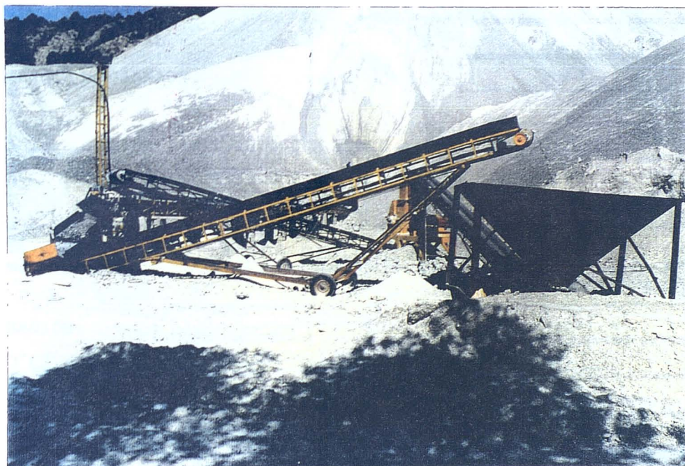
Foto 2.- Vista parcial del equipo que suministra a la planta principal.
