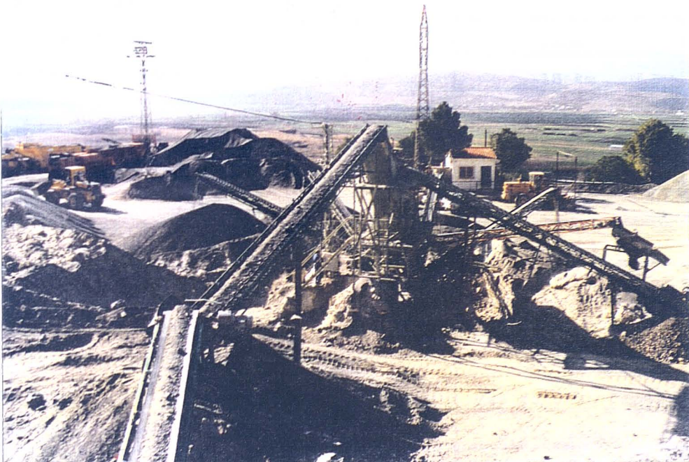
Foto 2.- Vista de detalle del equipo principal.
