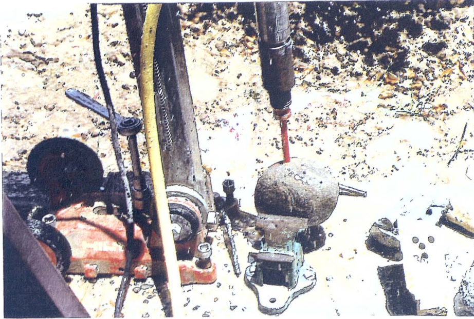
Figura 5.20. Extracción de cilindros de roca con broca de diamante.
