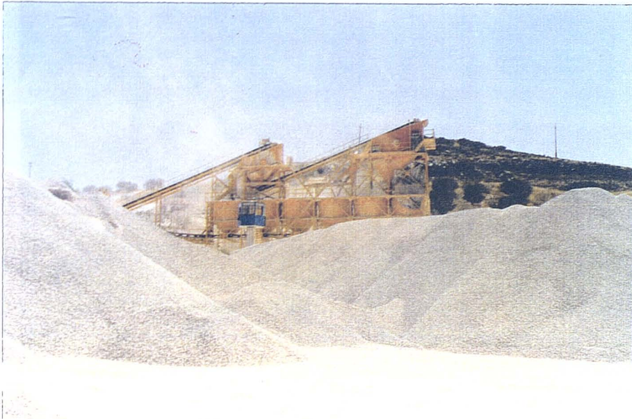
Figura 5.4. Acopios a la intemperie y en silos de áridos fraccionados.
