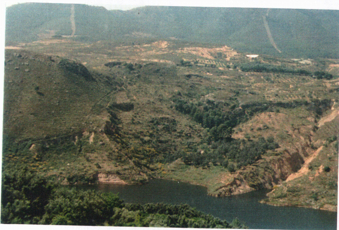
Fotografía 10. Algunos movimientos que afectan a las laderas del embalse de Béznar. Son sobre todo de tipo flujos de tierra y deslizamientos según los materiales afectados.
