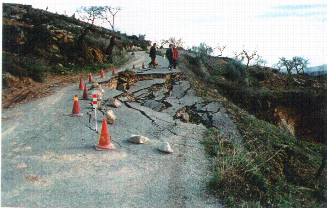
Fotografía 15. Roturas en el firme de la carretera Albuñuelas-Cozvíjar producidas como consecuencia de la inestabilidad general que presenta la vertiente septentrional del barranco de Luna y el encajamiento del mismo
