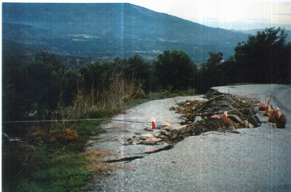
Fotografía 16. Cabecera del deslizamiento rotacional que afecta a la carretera forestal de Albuñuelas.
