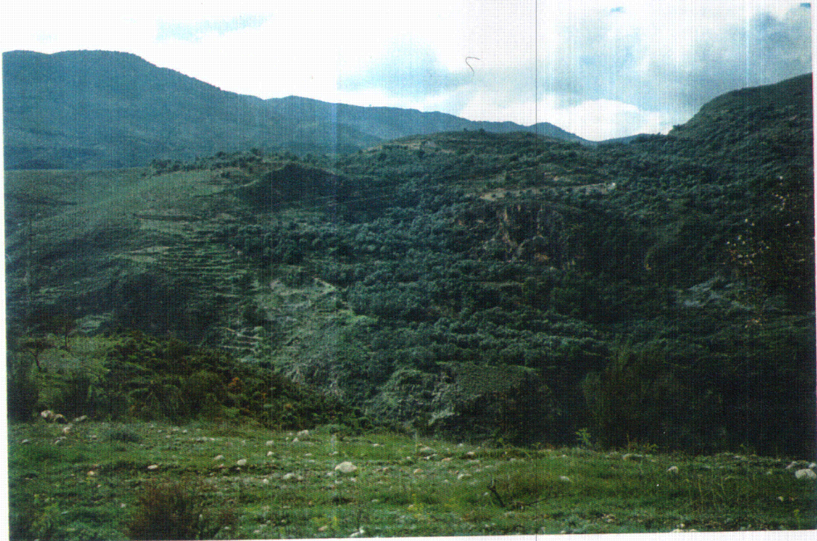
Fotografía 9. Movimiento complejo (desprendimiento-deslizamiento) afectando a las dolomías y filitas alpujárrides en la zona del Cerro Soriano (municipio del Pinar). El movimiento es avanzado, intermitente y causado principalmente por el encajamiento del río Ízbor.
