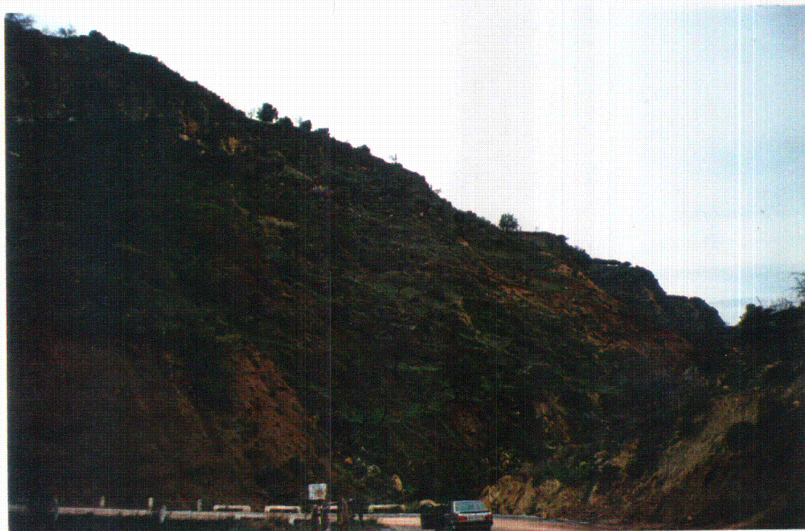
Fotografía 11. Flujos que afectan a las laderas del barranco de Luna. Estos se producen en los limos y arenas messinienses y se reactivan en cada periodo de lluvia.
