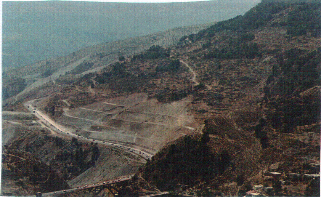
Fotografía 19. Movimiento complejo de la Fuente del Miriñaque afectando a la carretera N-323. Es un deslizamiento incipiente con una componente de desprendimiento en su parte alta. En el corte de la carretera se aprecian pequeños deslizamientos traslacionales.
