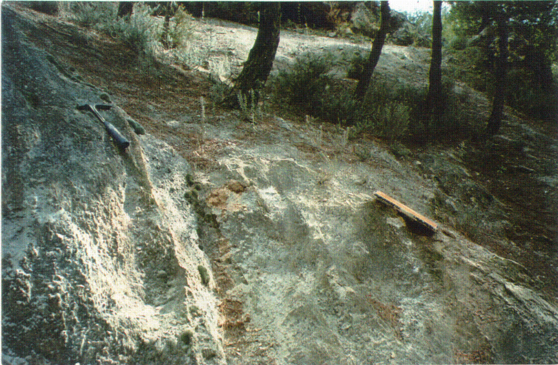
Fotografía 5. Detalle de la falla principal con sedimentos de conos de deyección (a la derecha) arrastrados y parcialmente fosilizados por caliche. Se observan superficies topográficas anteriores fosilizadas por caliche. Las antiguas se muestran con inclinación posterior.
