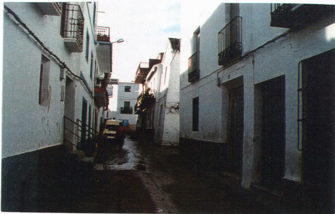
Fotografía 14. La calle Correo del pueblo de Albuñuelas donde se aprecia la inclinación de casas antiguas respecto a otras nuevas posiblemente debido a las reactivaciones del deslizamiento rotacional que afecta a este pueblo (Chacón, 1988).
