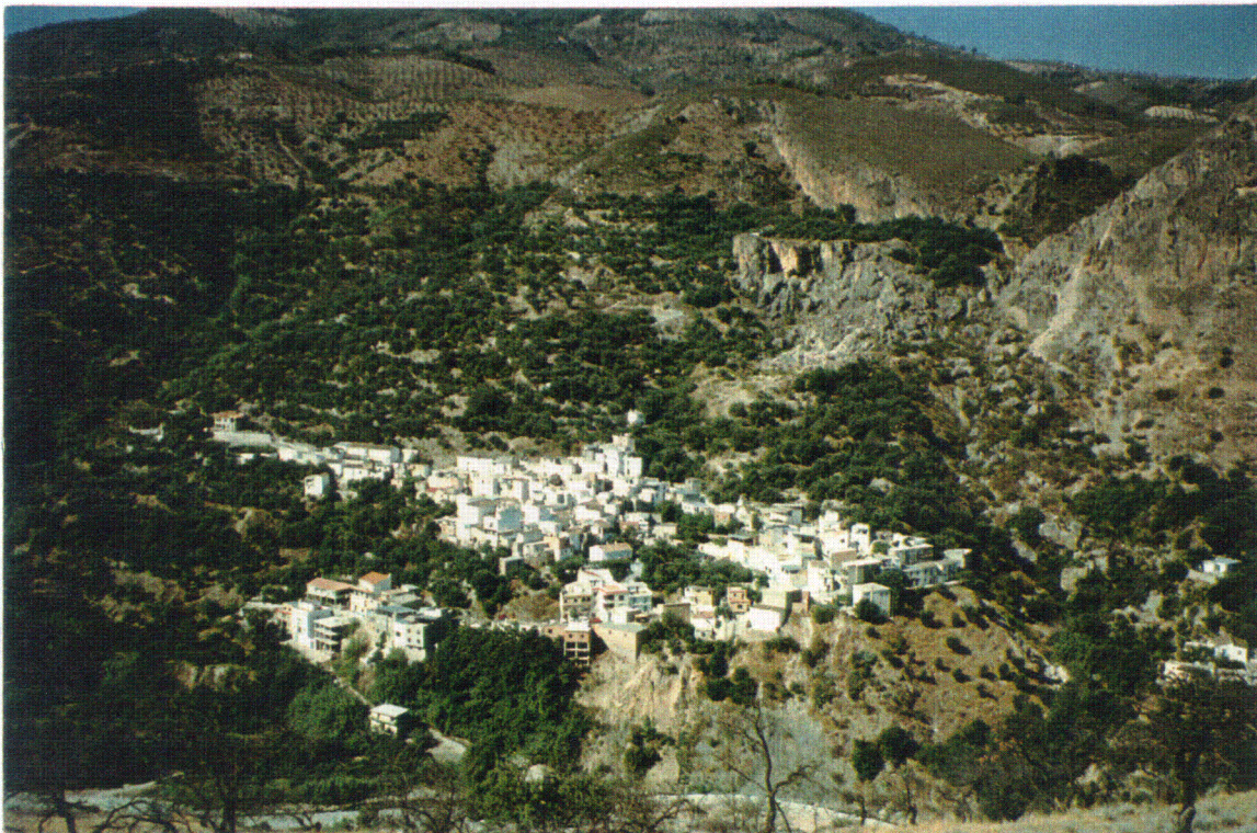
Fotografía 20. Movimiento profundo en el pueblo de Ízbor en esquistos grises. En la parte alta se observa el desprendimiento de los mármoles. Se trata de un deslizamiento rotacional ya que los mármoles situados en cabecera de éste se encuentran basculados. En la parte baja del pueblo se aprecia el descalce provocado por el río Ízbor y que amenaza la destrucción de varias casas de este pueblo.
