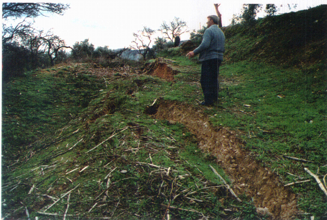
Fotografía 17. Escarpe secundario del mismo deslizamiento de la foto 16.
