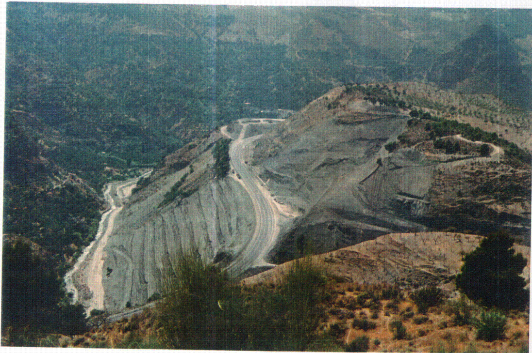
Fotografía 18. Aspecto de las obras realizadas para contener varios deslizamientos enfrente del pueblo de Ízbor y que han afectado seriamente a la carretera N-323.
